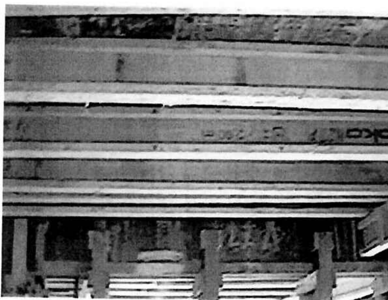
Figura 3 – Foto do detalhe dos garfos para escoramento e travamento de vigas.
