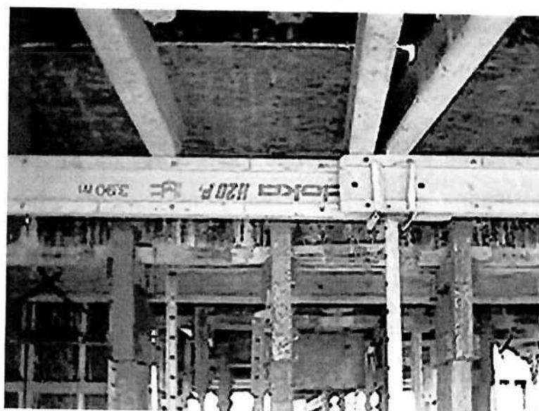
Figura 4 – Foto da vista inferior de cimbramento de laje tipo
