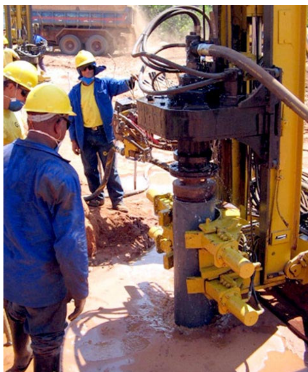
Figura 5.4.33 –Execução da perfuração da estaca
