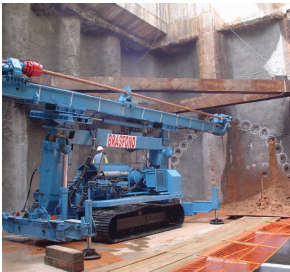
Figura 5.5.17 - Locação dos eixos das colunas na frente de tratamento
