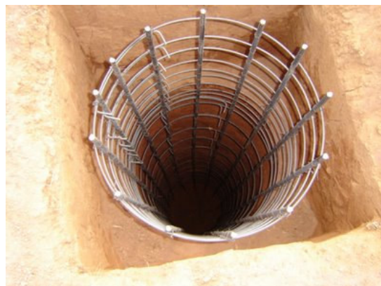
Foto 5.4.28 – Início da escavação do fuste e armadura do fuste, respectivamente.
