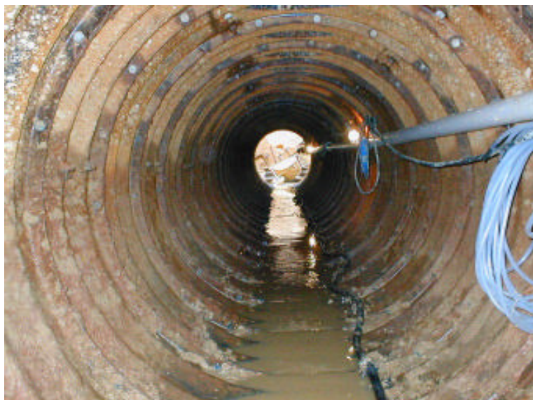
Figura 5.5.8: Revestimento Metálico dos Túneis
