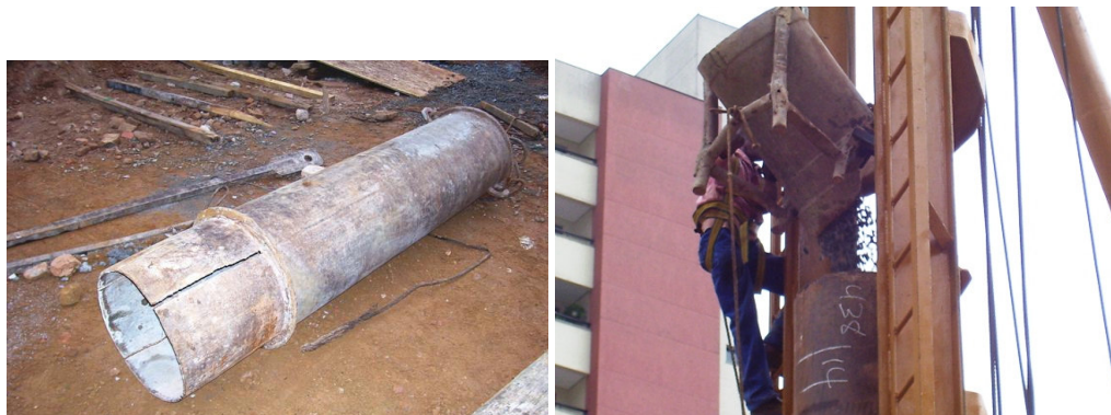
Foto 5.4.20: Complemento de tubo e reposição de brita, respectivamente.
