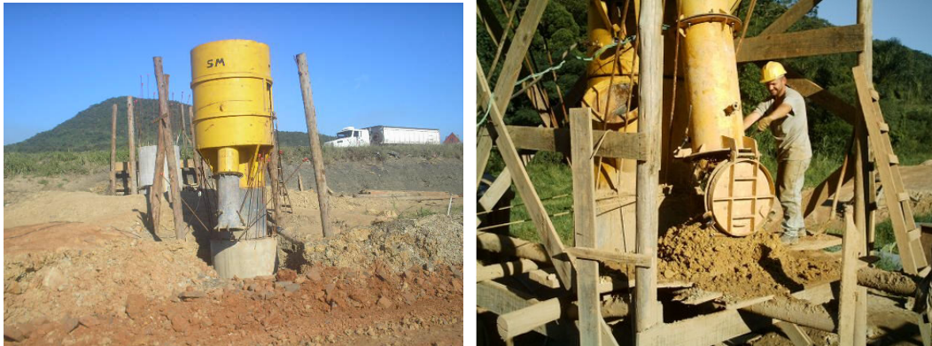
Foto 5.4.30: Campânula e retirada do material escavado, respectivamente.
