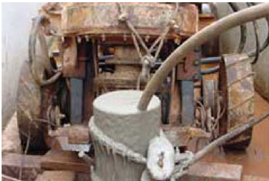
Figura 5.4.36 – Etapa final da concretagem da estaca
