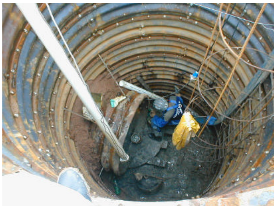
Figura 5.5.10: Emboque do Túnel
