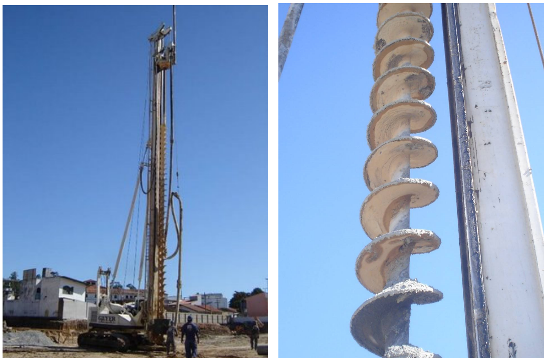
Foto 5.4.22 – Perfuratriz e hélice espiral utilizada na perfuração
