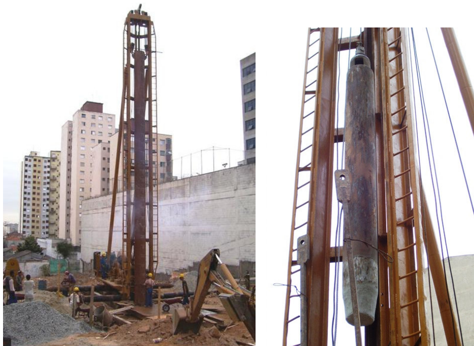
Foto 5.4.19: Bate estaca e pilão, respectivamente.
