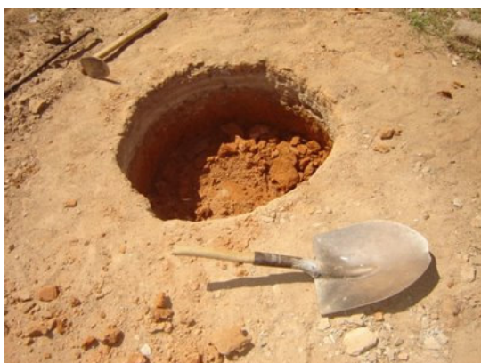
Foto 5.4.28 – Início da escavação do fuste e armadura do fuste, respectivamente.
