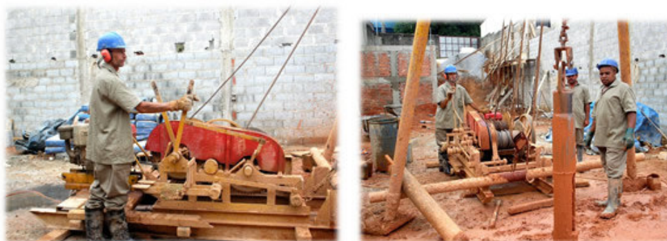
Foto 5.4.16: Equipamentos utilizados – motor e barrilete
