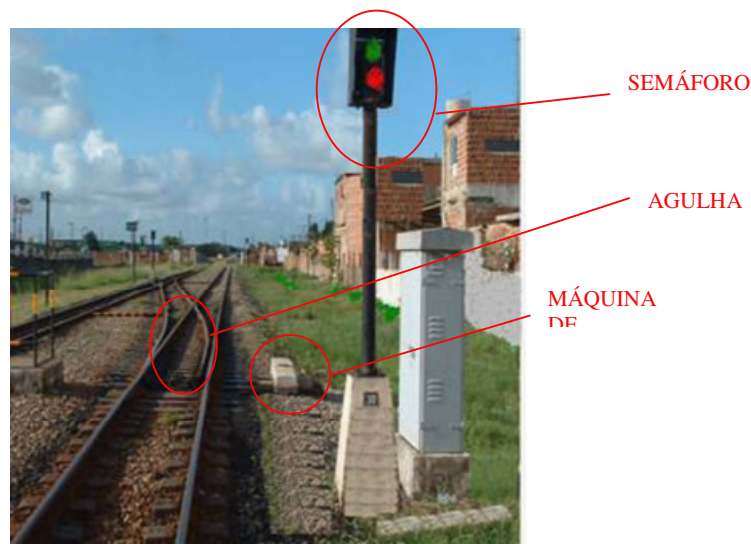
Figura 2.7.3: Componentes do Intertravamento.
