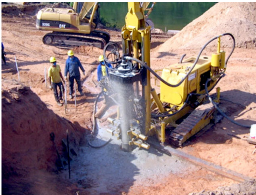
Figura 5.4.35: Concretagem da estaca raiz
