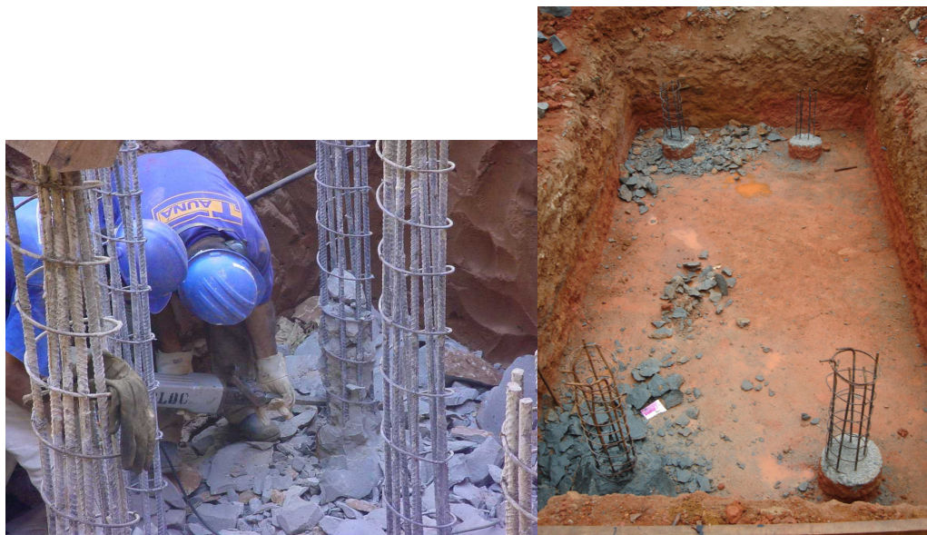
Figura 5.4.37: Arrasamento das estacas
