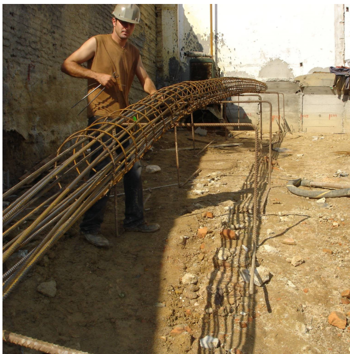
Figura 5.4.34: Preparação da armadura da estaca
