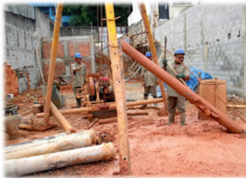
Foto 5.4.17: Retirada da terra coletada pelo barrilete
