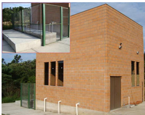
Figura 4.6. Miniestação. Destaque para o tanque de armazenamento de esgoto, onde foi feita a coleta.
