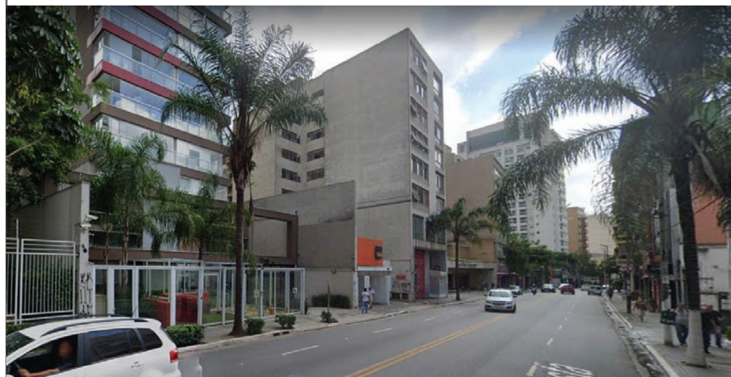
Google Street View, Rua Augusta na altura do número 810 - março de 2022. Fonte: Google Maps - Street View.
