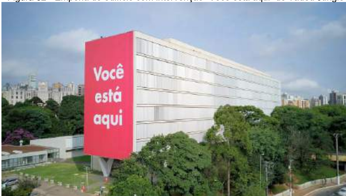
Figura 62 - Empena do edifício com intervenção “Você está aqui” de Tadeu Jungle
