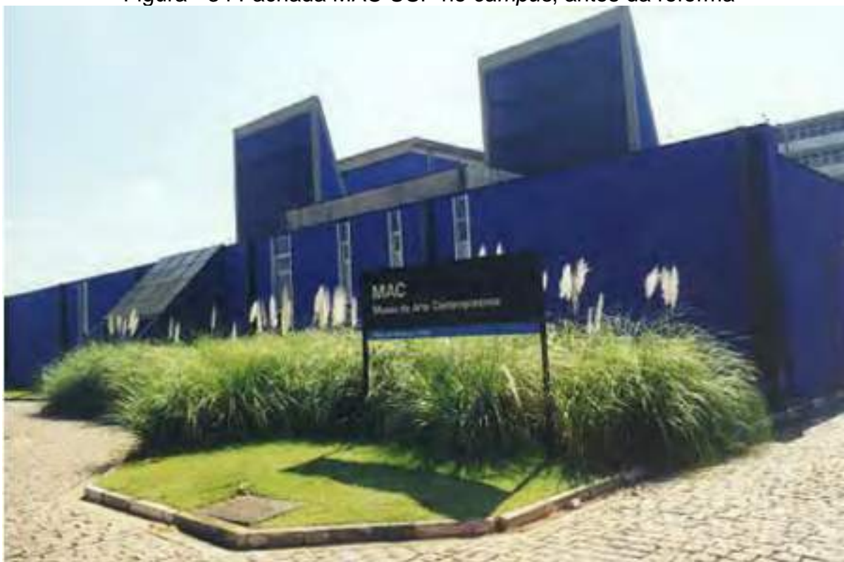
Figura - 34 Fachada MAC USP no campus , antes da reforma
