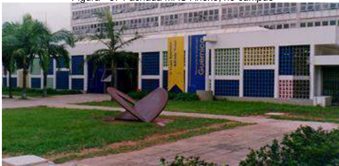
Figura - 37 Fachada MAC Anexo, no campus
