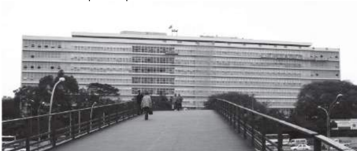
Figura 39 - Fachada do antigo Palácio da Agricultura, durante obras de reforma a partir da passarela Ciccillo Matarazzo. 2009
