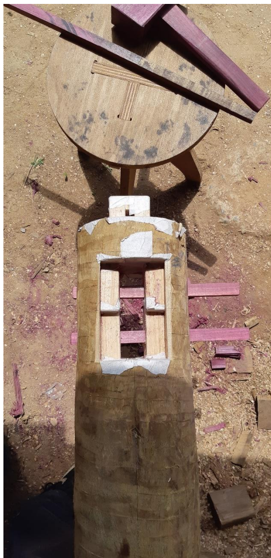
Figuras 93 e 94. Teste do encaixe dos pilares PB2 e PB3 com a viga VB2 e dos pinos de travamento de roxinho. Fonte: Alexander Chang.
