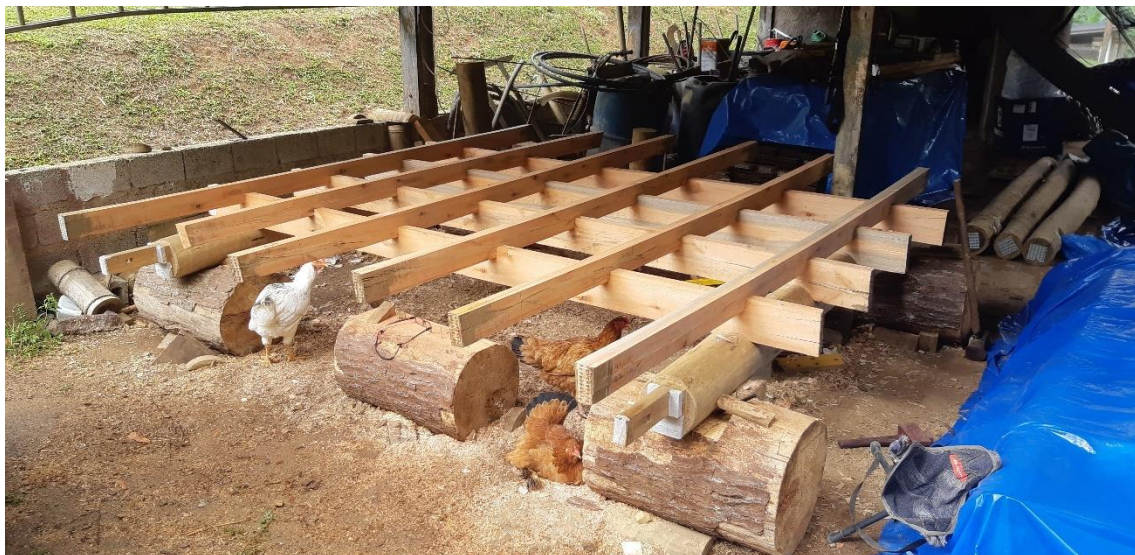
Figura 104. Estrutura do piso, sem as vigas V1 e V2. Fonte: Alexander Chang.
