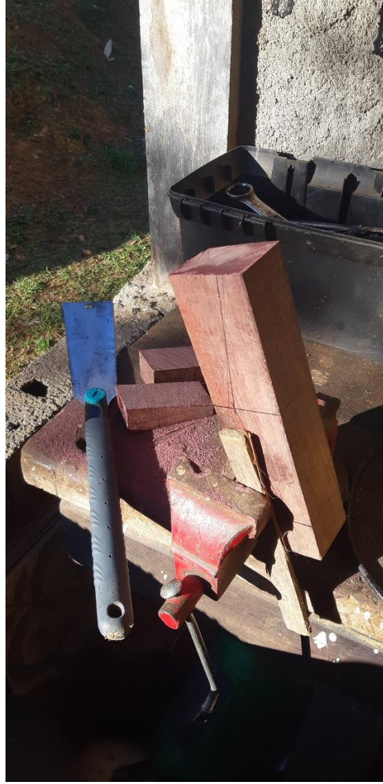
Figuras 133 e 134. Pilar PA1' e produção das cunhas de roxinho para o travamento. Fonte: Alexander Chang.
