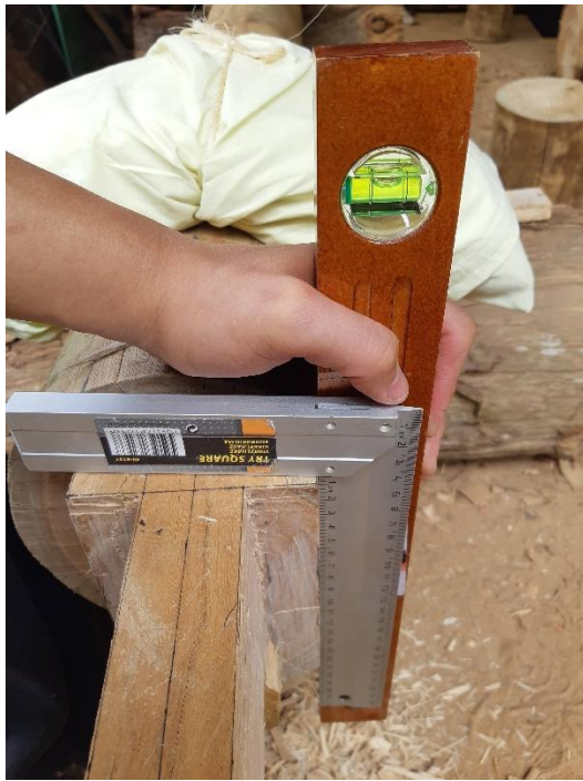
Figuras 67 e 68. Execução do encaixe da outra extremidade da vigia VA2. Fonte: Alexander Chang.
