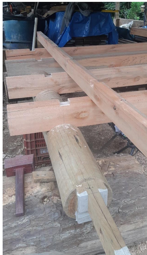
Figuras 100 e 101. Determinação do eixo da viga superior da estrutura do piso e encaixes entre vigas. Fonte: Alexander Chang.
