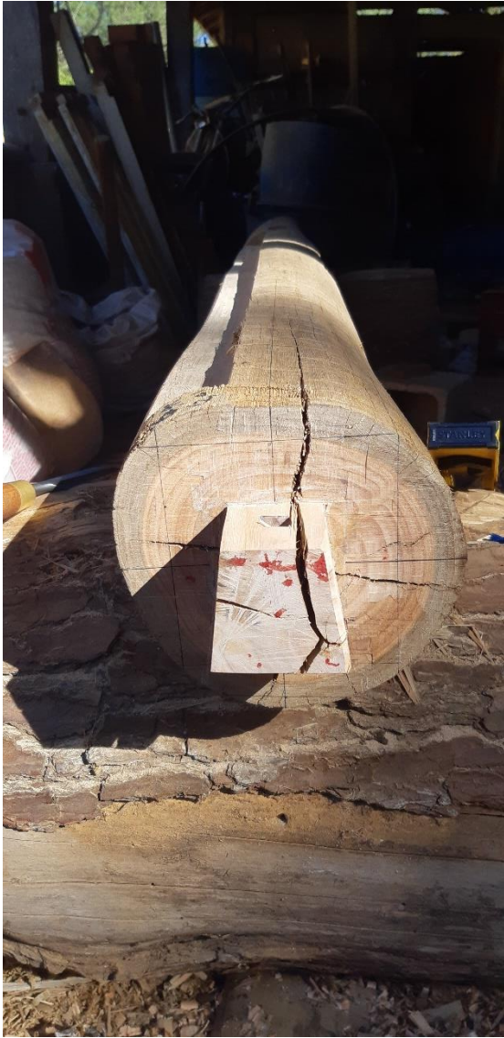
Figuras 133 e 134. Pilar PA1' e produção das cunhas de roxinho para o travamento. Fonte: Alexander Chang.
