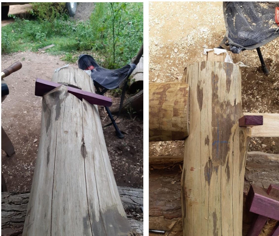
Figuras 95 e 96. Teste do encaixe para a cunha de roxinho no pilar PB3. Fonte: Alexander Chang.
