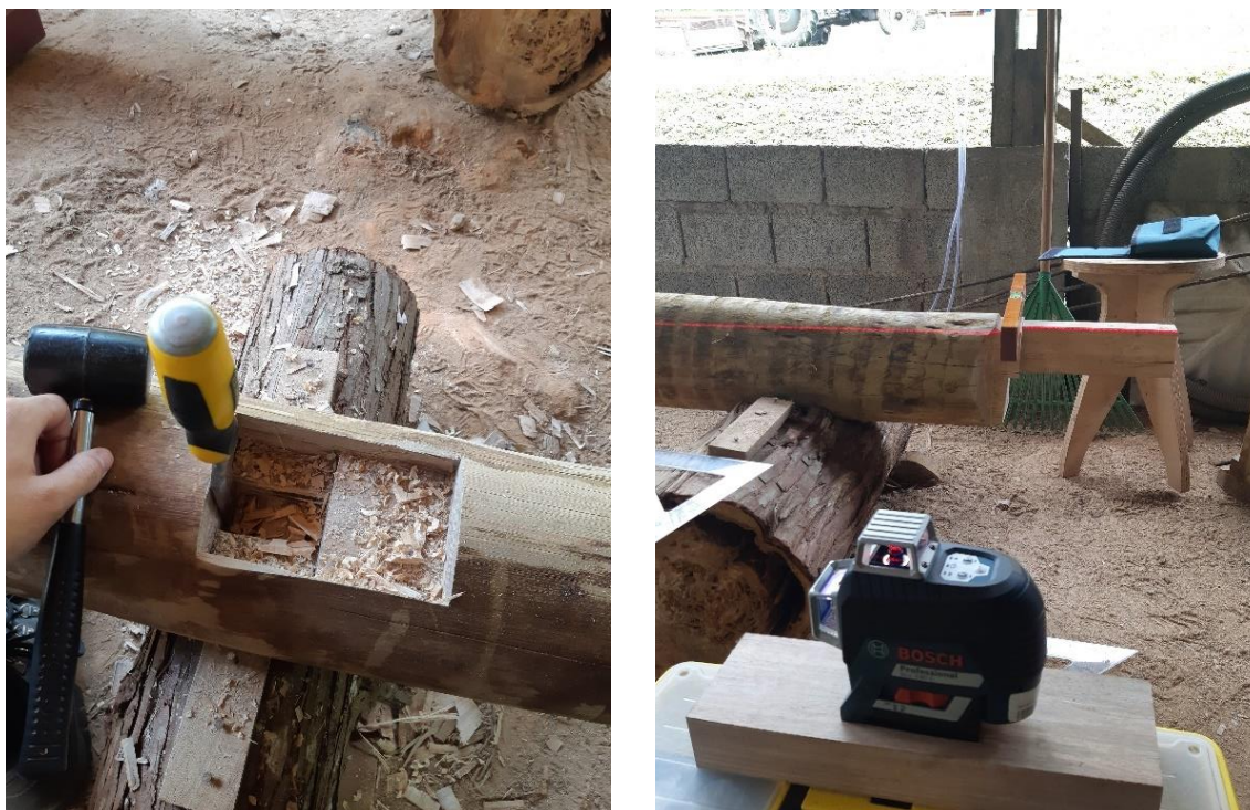
Figuras 63 e 64. Execução do entalhe do pilar PA3 e conferência do encaixe da viga VA2, realizado anteriormente. Fonte: Alexander Chang.
