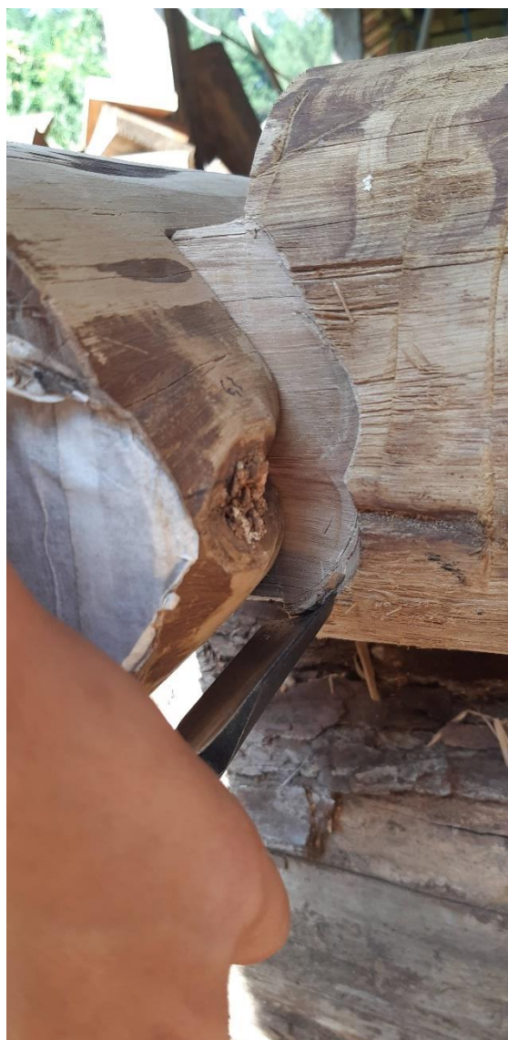
Figuras 91 e 92. Encaixe do pilar PB3 e a viga VB2. Fonte: Alexander Chang.
