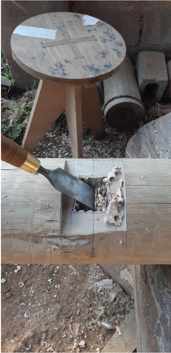
Figuras 121 e 122. Remoção do material e finalização do encaixe. Fonte: Alexander Chang.
