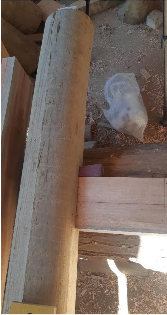
Figuras 135 e 136. Teste do travamento entre pilares. Fonte: Alexander Chang.
