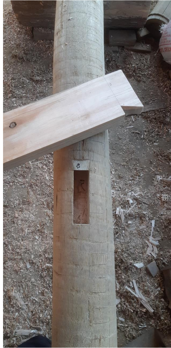
Figuras 129 e 130. Travamento entre pilares e seu respectivo encaixe. Fonte: Alexander Chang.
