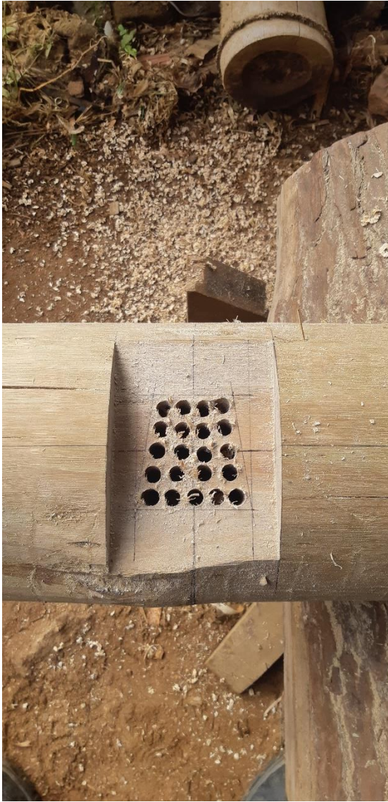
Figura 119 e 120. Uso da furadeira para facilitar o uso do formão. Fonte: Alexander Chang.
