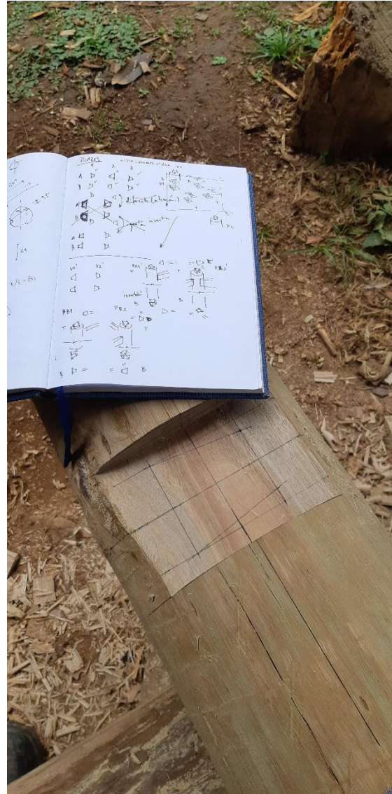
Figuras 117 e 118. Uso da plaina block e desenho do encaixe. Fonte: Alexander Chang.
