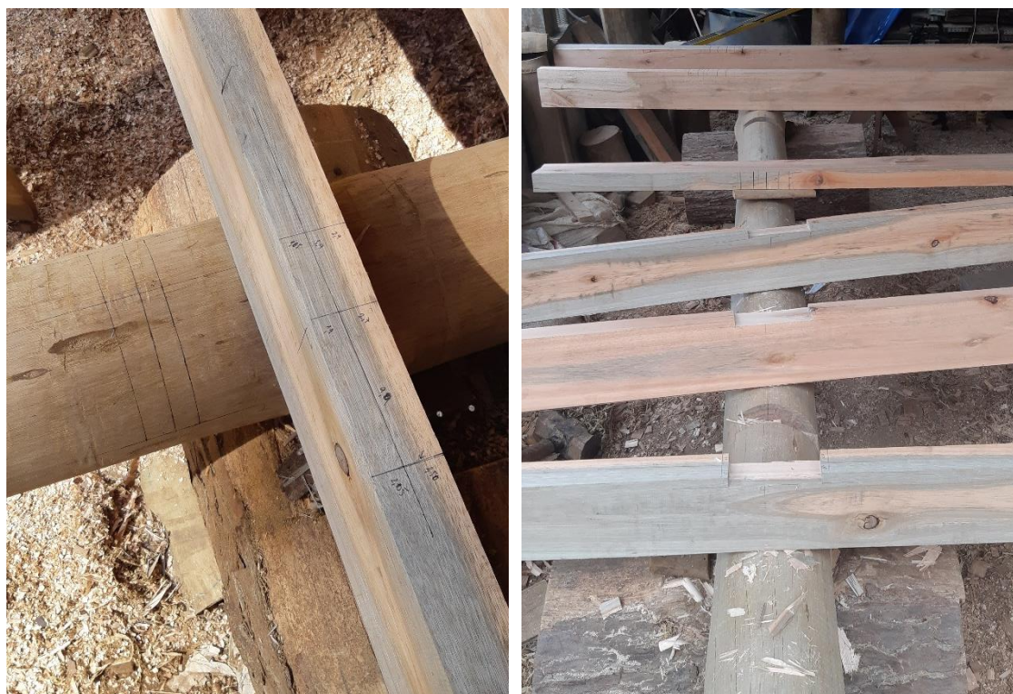
Figuras 105 e 106. Execução dos encaixes das vigas do telhado. Fonte: Alexander Chang.
