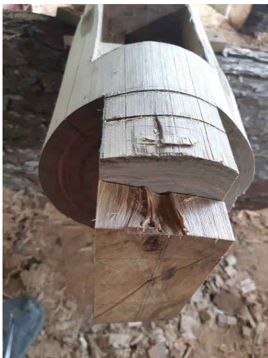
Figuras 69 e 70. Execução do encaixe na ponta do pilar PA3. Fonte: Alexander Chang.
