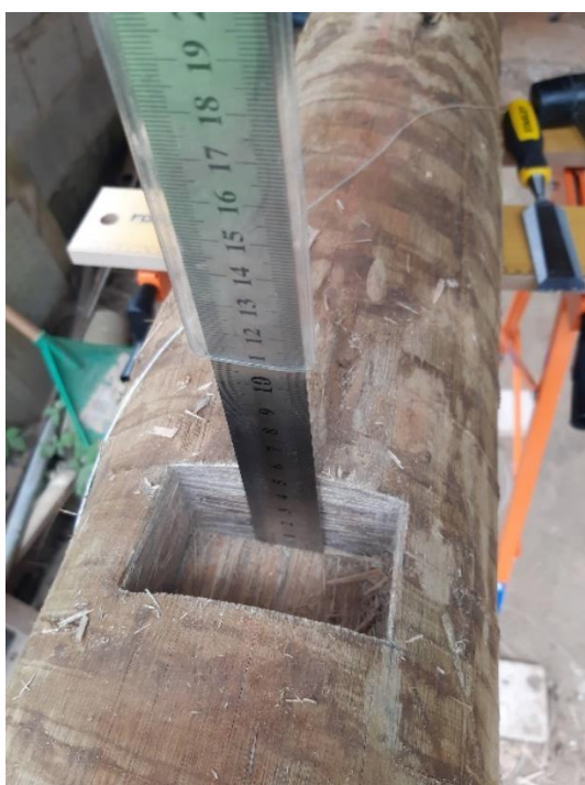
Figuras 55 e 56. Encaixe da viga V3, conferência e proteção à perda de umidade. Fonte: Alexander Chang.
