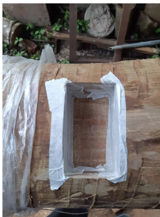
Figuras 55 e 56. Encaixe da viga V3, conferência e proteção à perda de umidade. Fonte: Alexander Chang.
