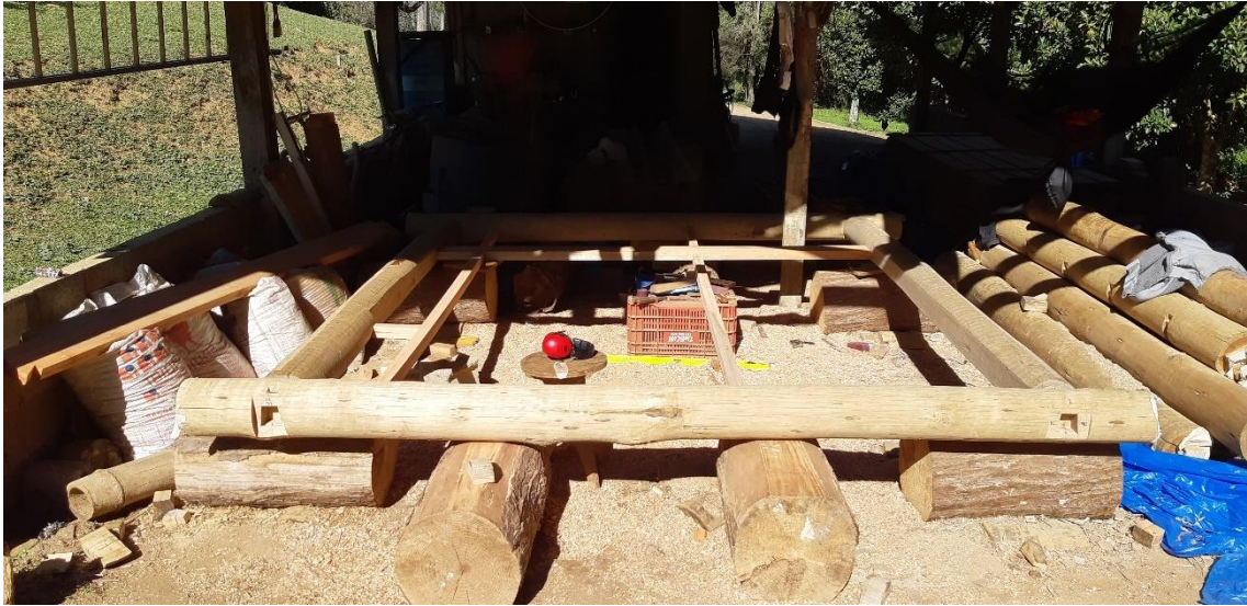
Figura 138. Teste dos encaixes das estruturas da parede do eixo 2. Fonte: Alexander Chang.
