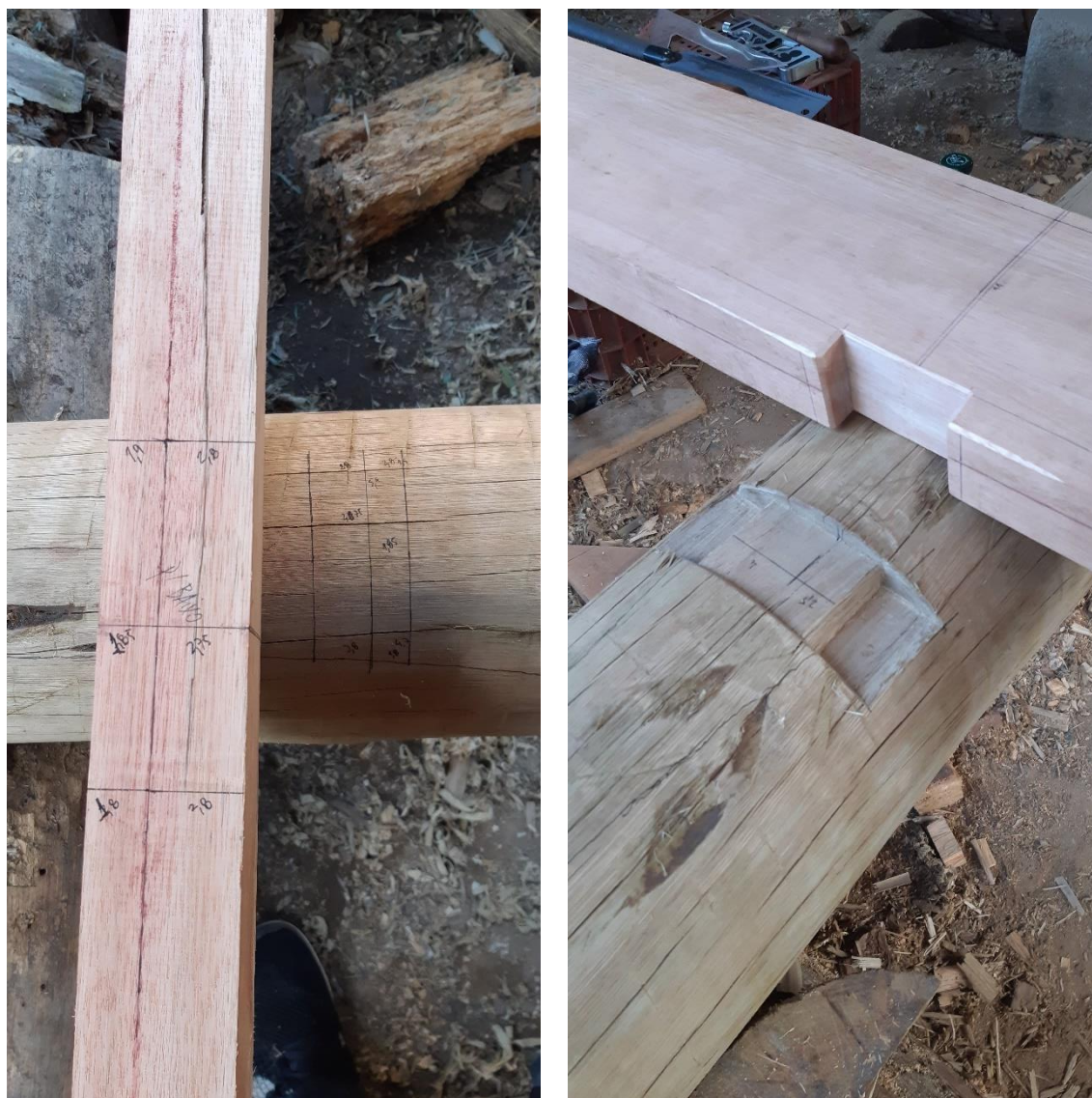
Figuras 97 e 98. Medições e execução do encaixe entre vigas do piso. Fonte: Alexander Chang.
