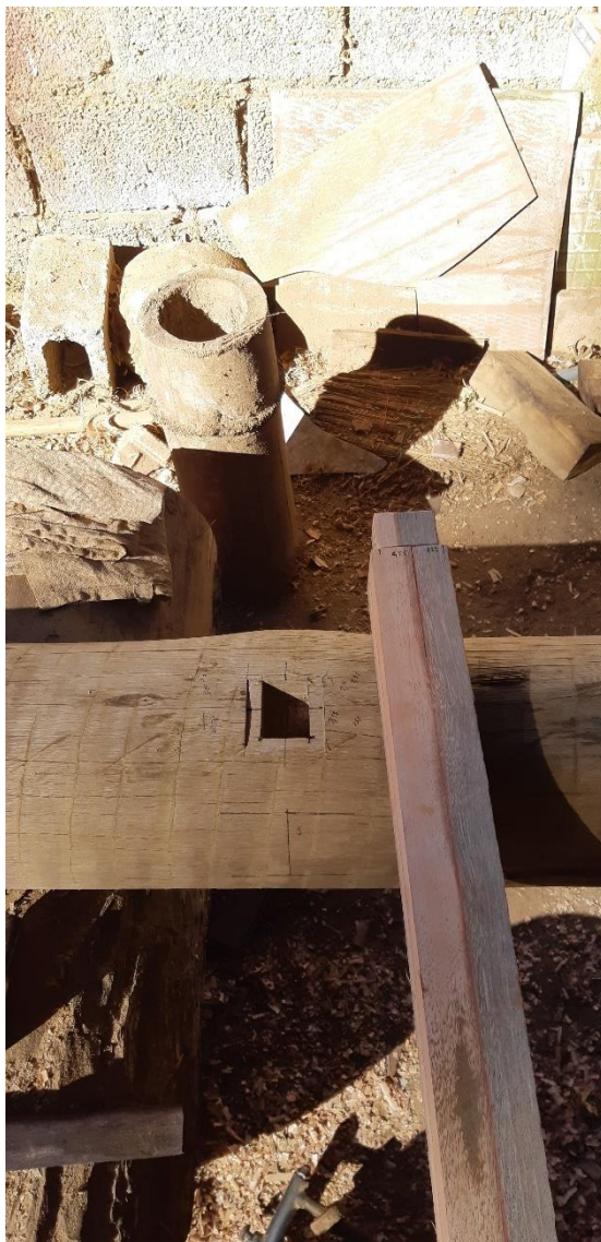
Figuras 127 e 128. Encaixes das estruturas de suporte às tábuas e às aberturas. Fonte: Alexander Chang.
