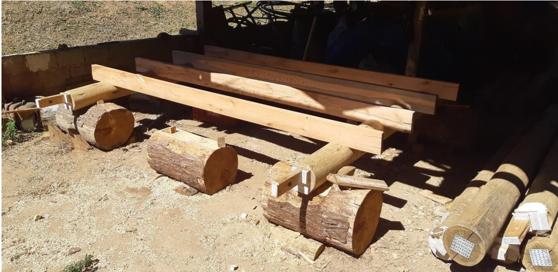
Figura 99. Encaixe das vigas inferiores da estrutura do piso. Fonte: Alexander Chang.
