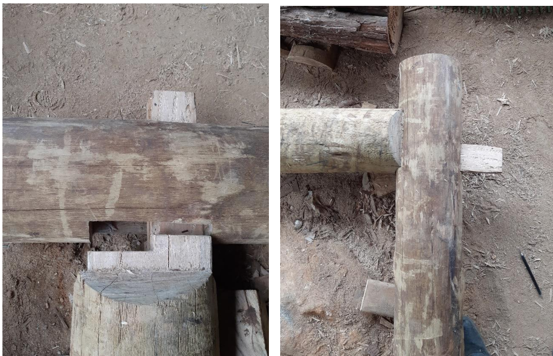
Figuras 65 e 66. Teste do encaixe entre o pilar PA3 e VA2. Fonte: Alexander Chang.
