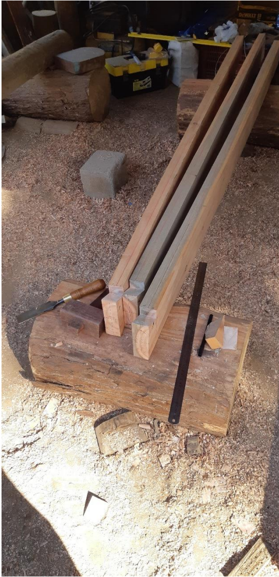
Figuras 129 e 130. Travamento entre pilares e seu respectivo encaixe. Fonte: Alexander Chang.
