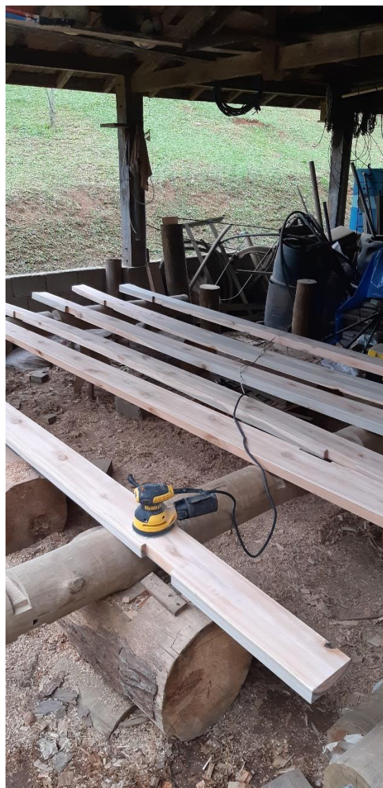
Figuras 109 e 110. Processo de acabamento das vigas do telhado. Fonte: Alexander Chang.
