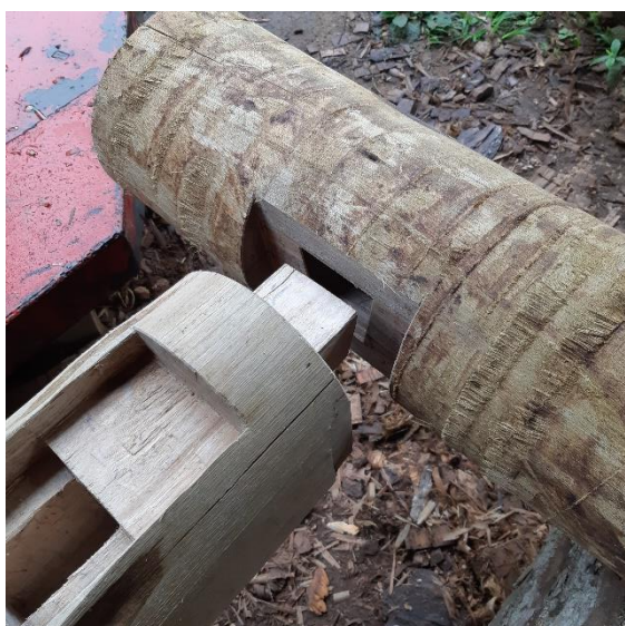
Figuras 73 e 74. Teste do encaixe entre o pila PA3 e viga V3. Fonte: Alexander Chang.
