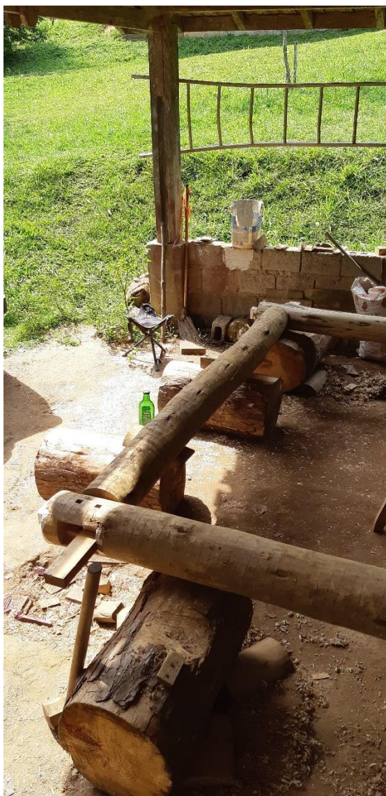
Figuras 93 e 94. Teste do encaixe dos pilares PB2 e PB3 com a viga VB2 e dos pinos de travamento de roxinho. Fonte: Alexander Chang.
