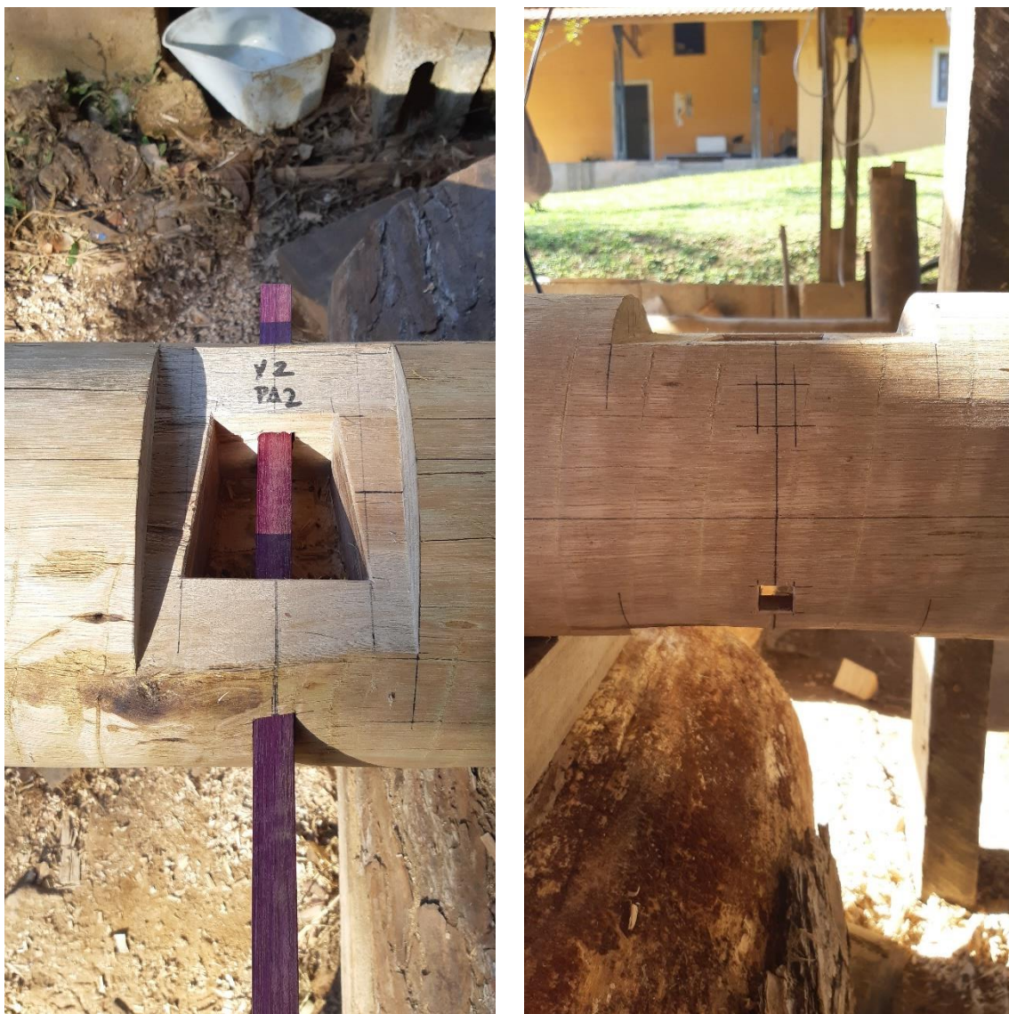
Figuras 125 e 126. Finalização de um dos encaixes e continuação da produção da viga VA2. Fonte: Alexander Chang.
