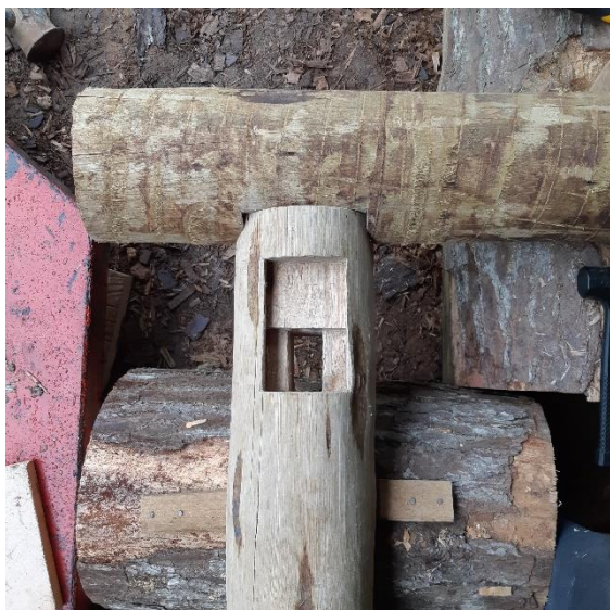
Figuras 73 e 74. Teste do encaixe entre o pila PA3 e viga V3. Fonte: Alexander Chang.
