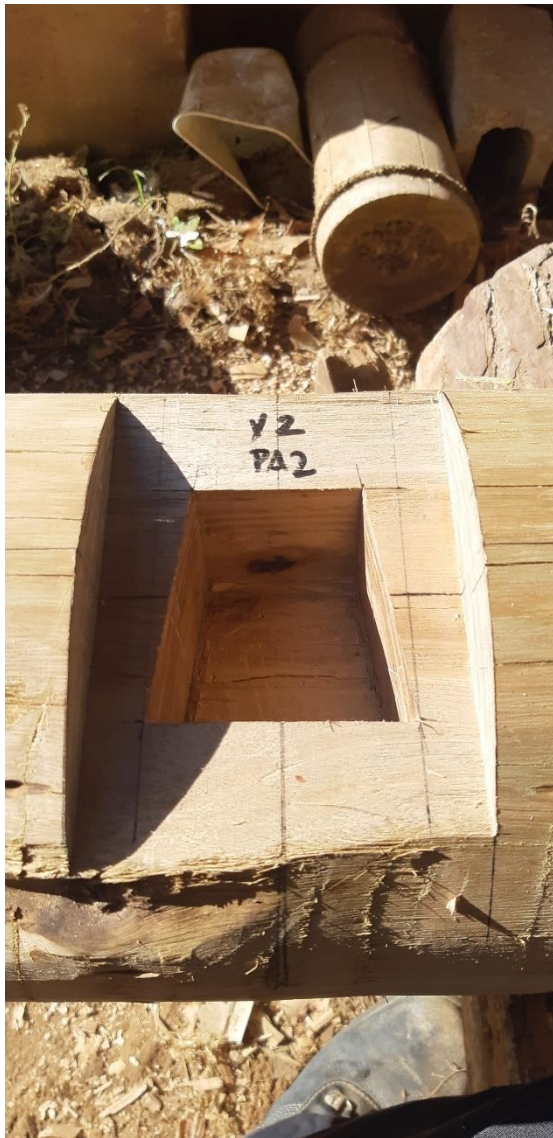
Figuras 123 e 124. Encaixe quase pronto e produção dos pinos de roxinho. Fonte: Alexander Chang.
