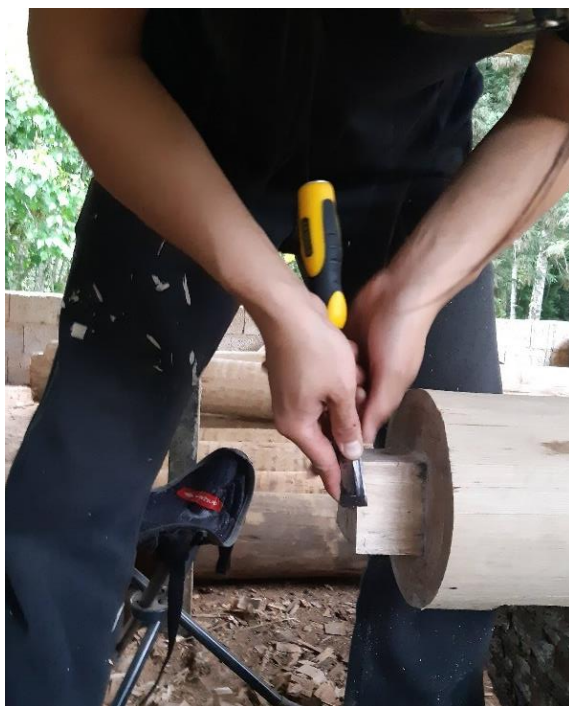
Figuras 69 e 70. Execução do encaixe na ponta do pilar PA3. Fonte: Alexander Chang.
