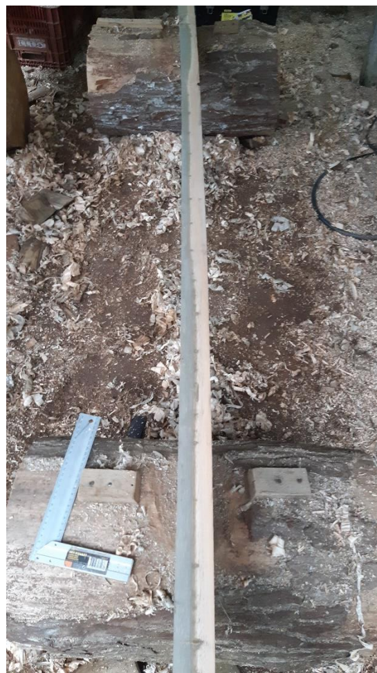
Figuras 89 e 90. Situação dos caibros e parcela de alburno de uma das vigas. Fonte: Alexander Chang.
