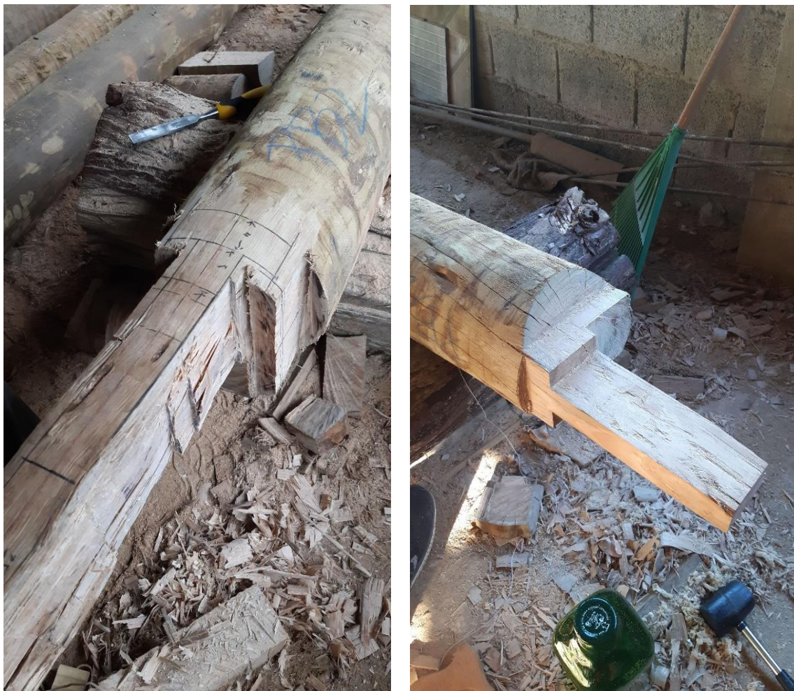
Figuras 61 e 62. Etapas executivas de uma das extremidades da viga VA2. Fonte: Alexander Chang.
