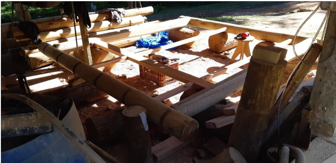
Figura 139. Teste dos encaixes do eixo 2. Fonte: Alexander Chang.
