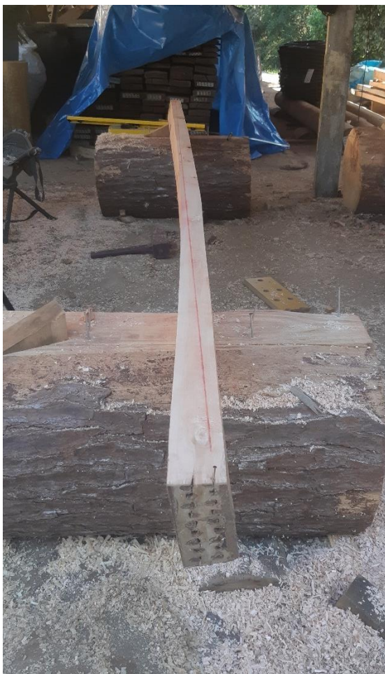
Figuras 100 e 101. Determinação do eixo da viga superior da estrutura do piso e encaixes entre vigas. Fonte: Alexander Chang.
