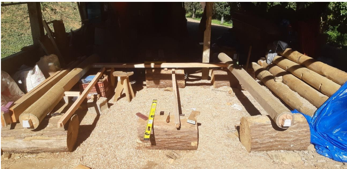
Figura 137. Teste do travamento. Fonte: Alexander Chang.
