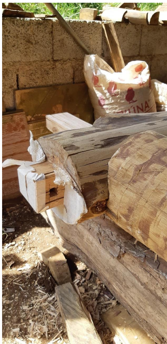
Figuras 91 e 92. Encaixe do pilar PB3 e a viga VB2. Fonte: Alexander Chang.
