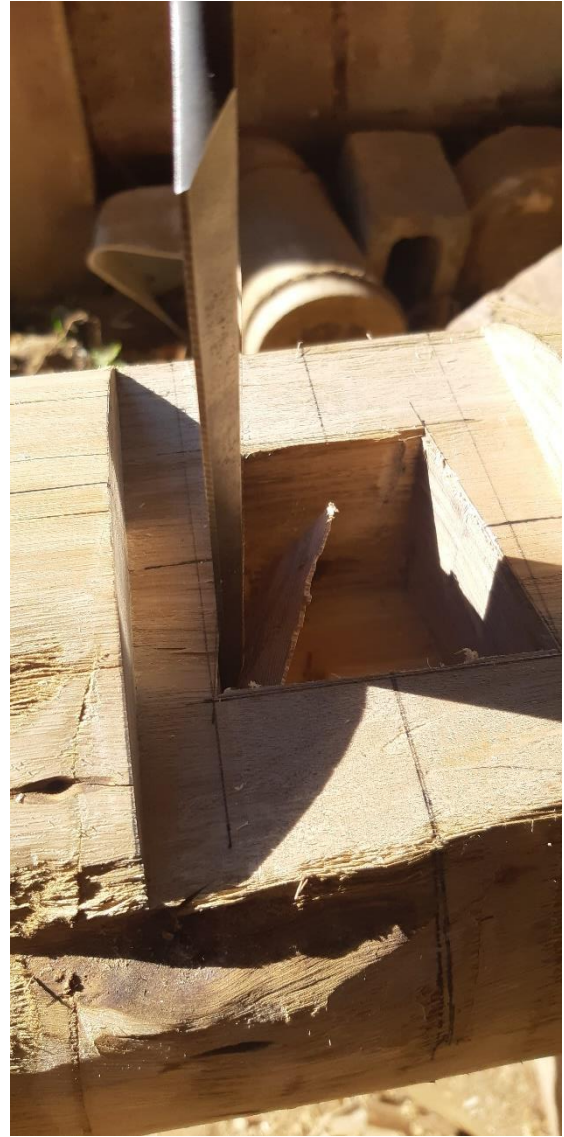
Figuras 121 e 122. Remoção do material e finalização do encaixe. Fonte: Alexander Chang.
