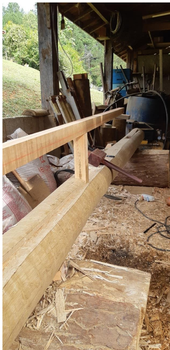
Figura 131 e 132. Produção do pilar PA2' e teste do encaixe da estrutura de suporte. Fonte: Alexander Chang.
