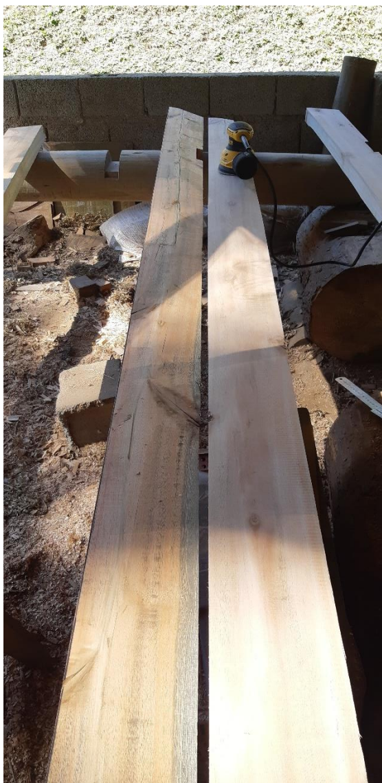
Figuras 109 e 110. Processo de acabamento das vigas do telhado. Fonte: Alexander Chang.
