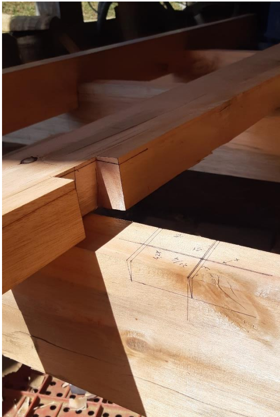
Figuras 102 e 103. Realização do encaixe entre as vigas retangulares da estrutura do piso. Fonte: Alexander Chang.
