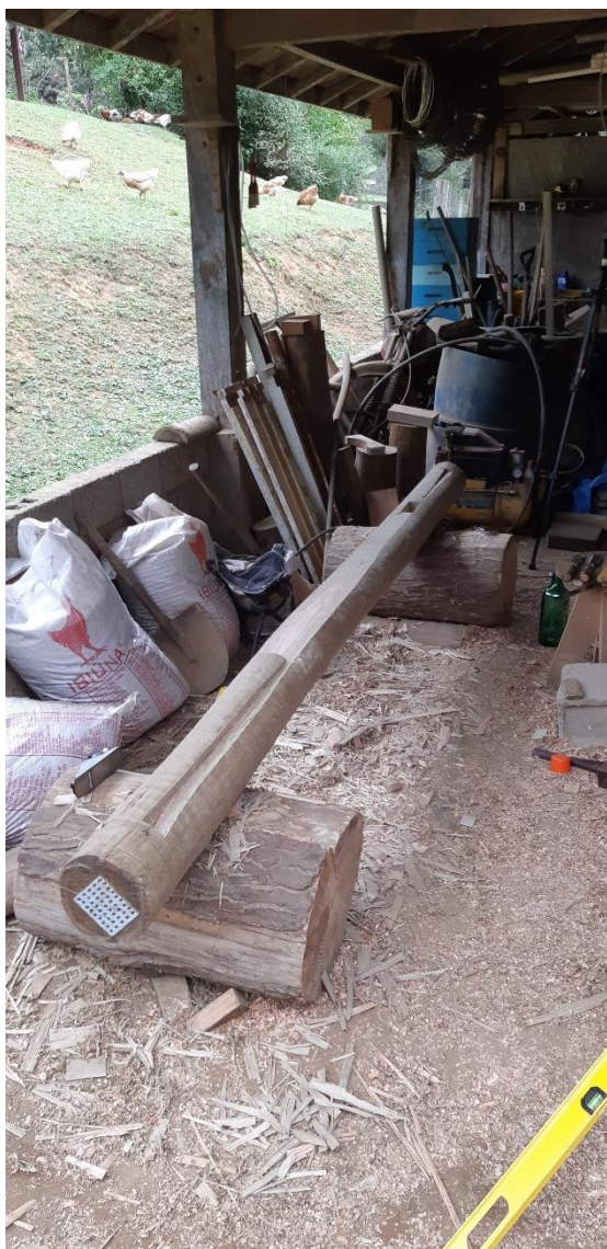
Figura 131 e 132. Produção do pilar PA2' e teste do encaixe da estrutura de suporte. Fonte: Alexander Chang.
