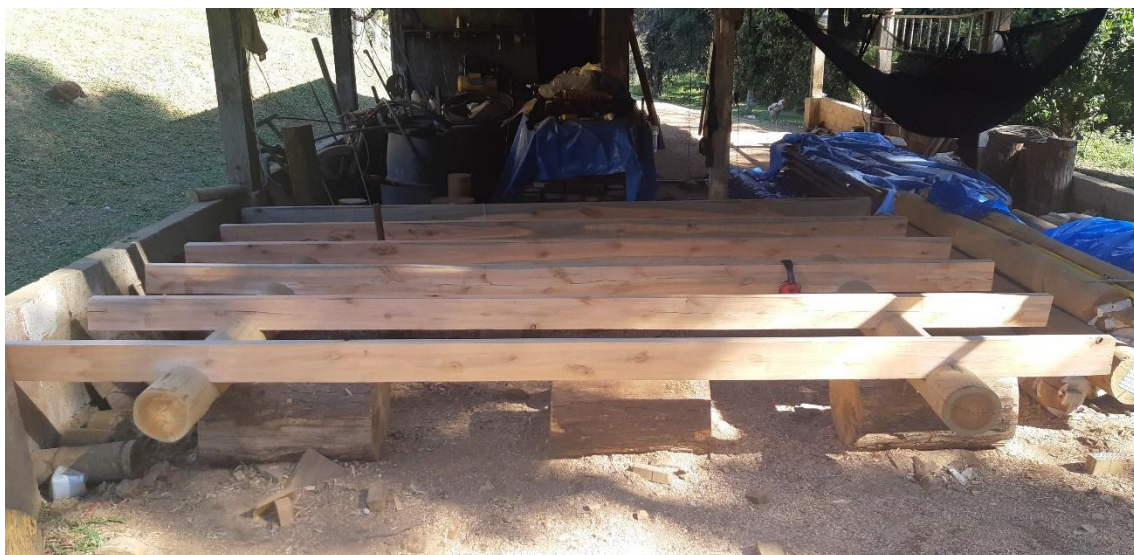
Figura 107. Teste da estrutura do telhado. Fonte: Alexander Chang.
