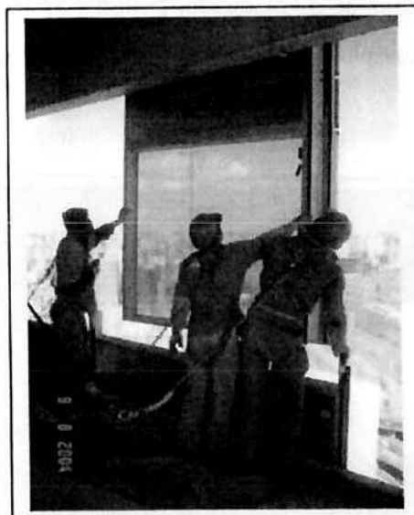
Figura 53 – Sequência da montagem – instante em que o painel é fixado
