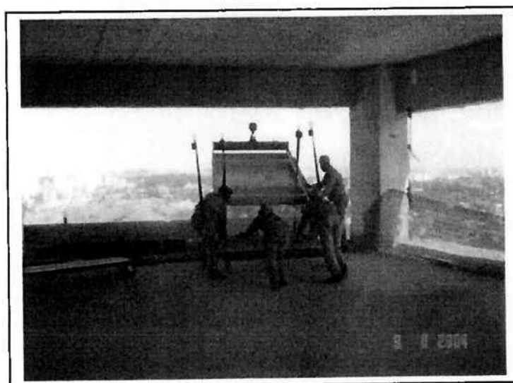
Figura 51 - Instalação de painel na fachada, vista pelo interior do prédio
