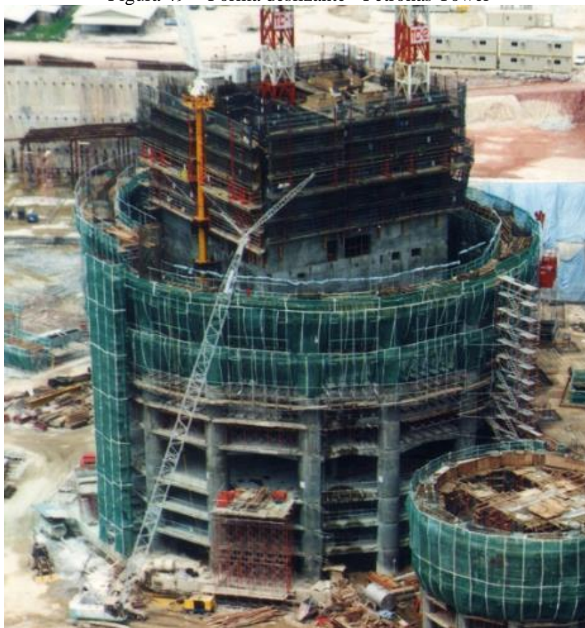
Figura 49 - Forma deslizante - Petronas Tower
