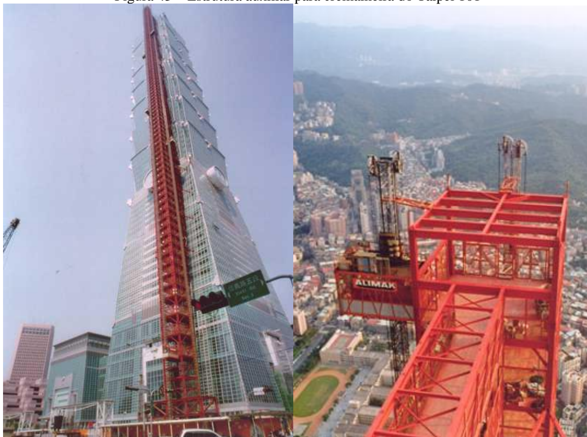
Figura 45 – Estrutura auxiliar para cremalheira do Taipei 101
