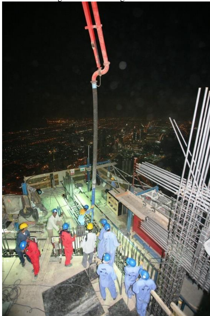
Figura 7 – Concretagem noturna
