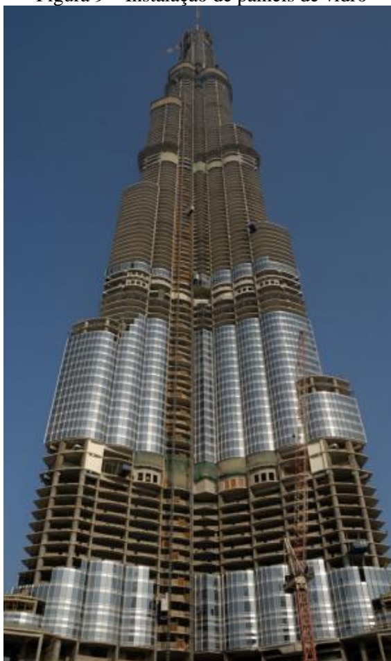
Figura 9 – Instalação de painéis de vidro
