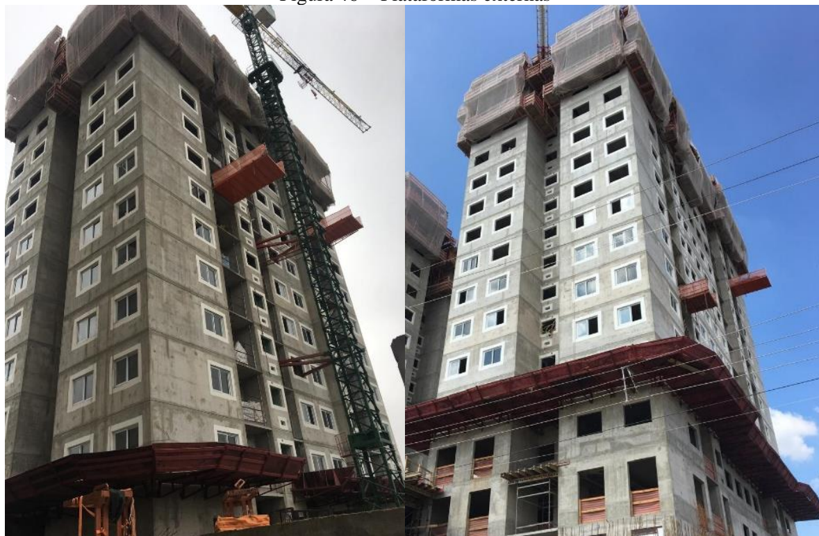
Figura 46 - Plataformas externas
