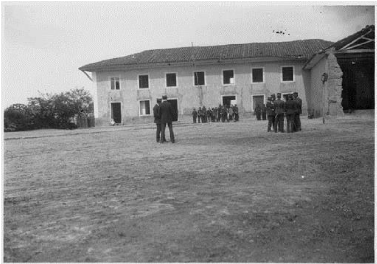
Figura 5. Antiga sede da Fazenda Santana e atual sede do CPOR
