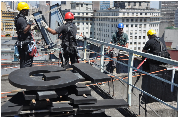
Figura 47: Procedimento remoção da remoção da placa (retirada pela parte superior) Fonte: Arquivo pessoal, 2013
