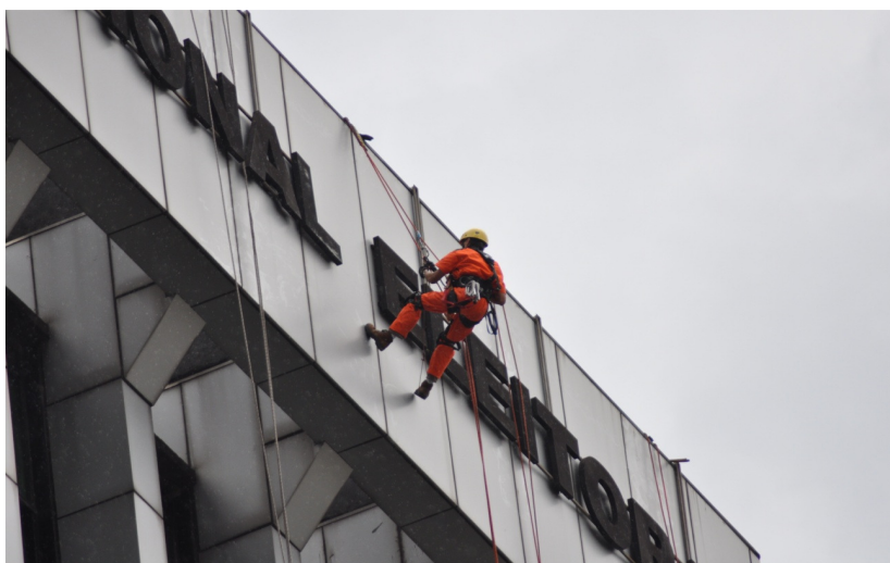
Figura 38: Profissional utilizando técnicas de acesso por corda Fonte: Arquivo pessoal, 2012
