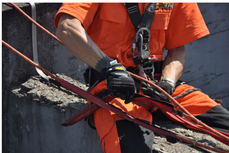
Figura 34: Instalação dos protetores de cordas em PVC Fonte: Arquivo pessoal, 2012
