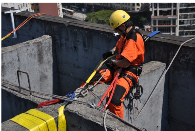
Figura 33: Utilização da viga da estrutura de concreto para criação das ancoragens Fonte: Arquivo pessoal, 2012
