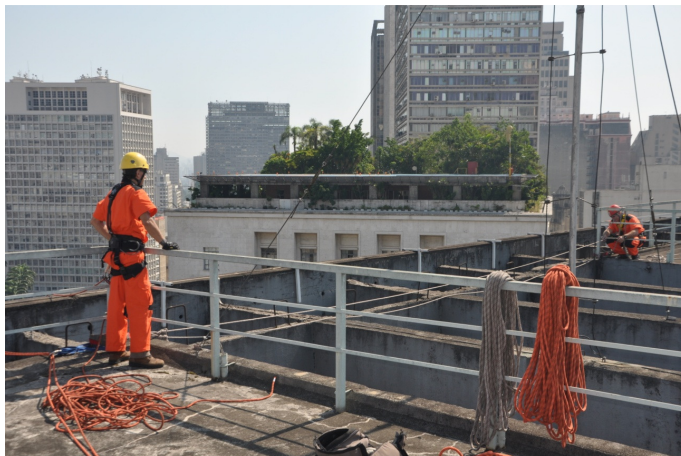
Figura 28: Criação de linha de vida dupla para conexão do talabarte Fonte: Arquivo pessoal, 2012
