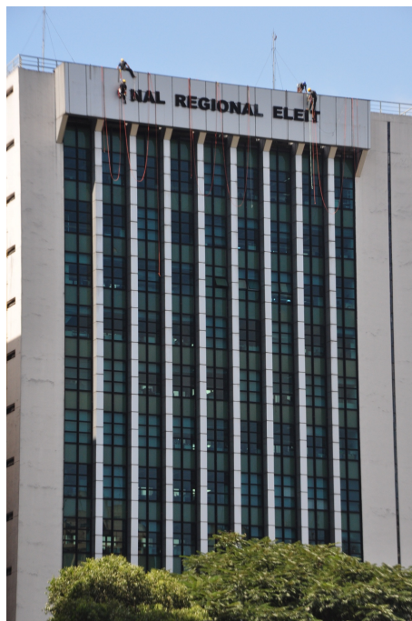
Figura 48: Vista geral do letreiro e profissionais durante o processo de remoção, utilizando-se cordas paralelas. Fonte: Arquivo pessoal, 2013
