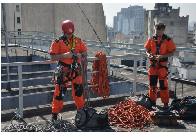
Figura 27: Inspeção e preparação dos equipamentos Fonte: Arquivo pessoal, 2012
