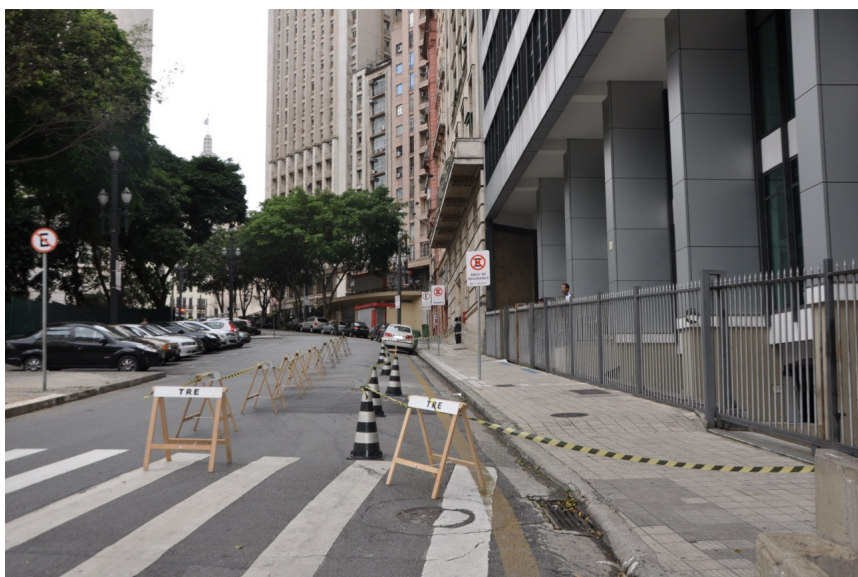
Figura 39: Isolamento da via do local de execução dos trabalhos Fonte: Arquivo pessoal, 2013
