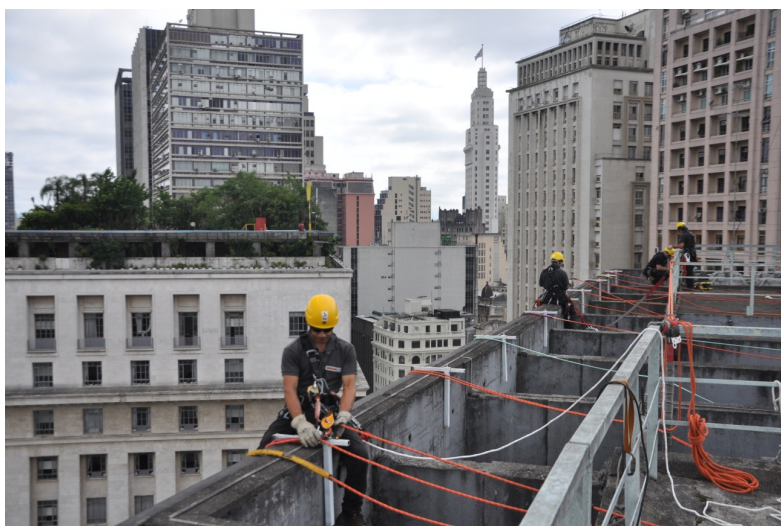
Figura 44: Criação das linhas de acesso para trabalho de remoção da placa em duas frentes concomitantes Fonte: Arquivo pessoal, 2013
