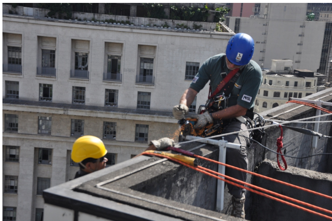
Figura 45: Fragmentação da placa - equipamento preso ao sistema contra queda Fonte: Arquivo pessoal, 2013
