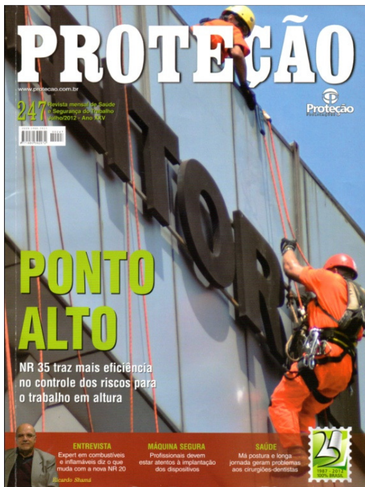
Figura 50: Foto de capa da revista Proteção (jul. 2012) sobre a NR35 traz imagem do estudo de caso registrada pelo autor do presente trabalho.
