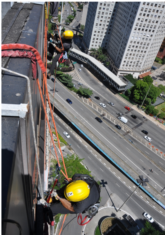
Figura 49: Profissionais utilizando técnicas de acesso por corda para realização das atividades de remoção da placa de identificação de acordo com a NBR 15595 Fonte: Arquivo pessoal, 2013
