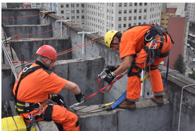
Figura 32: Profissionais durante a montagem dos pontos de ancoragem e linhas de acesso Fonte: Arquivo pessoal, 2012
