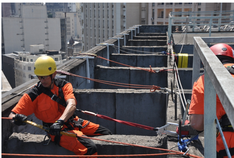
Figura 41: Foto preparação linhas de acesso por corda para inspeção Fonte: Arquivo pessoal, 2012
