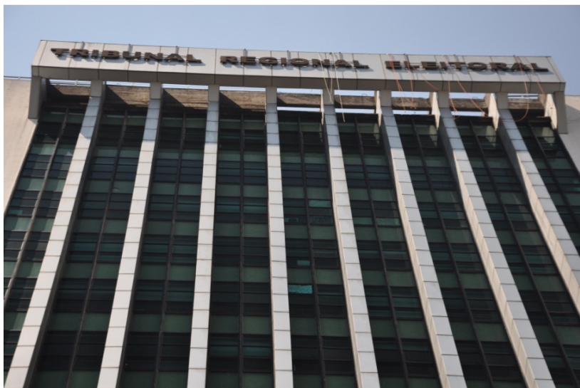
Figura 22: Vista geral do edifício e placa de identificação objeto da intervenção
