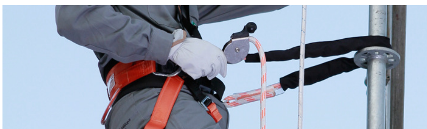
Figura 9: Utilização do talabarte regulável de posicionamento regulável
