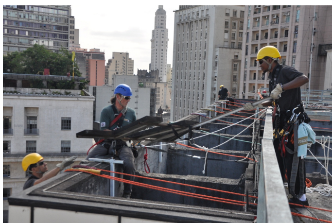
Figura 46: Procedimento remoção da remoção da placa (elementos amarrados) Fonte: Arquivo pessoal, 2013
