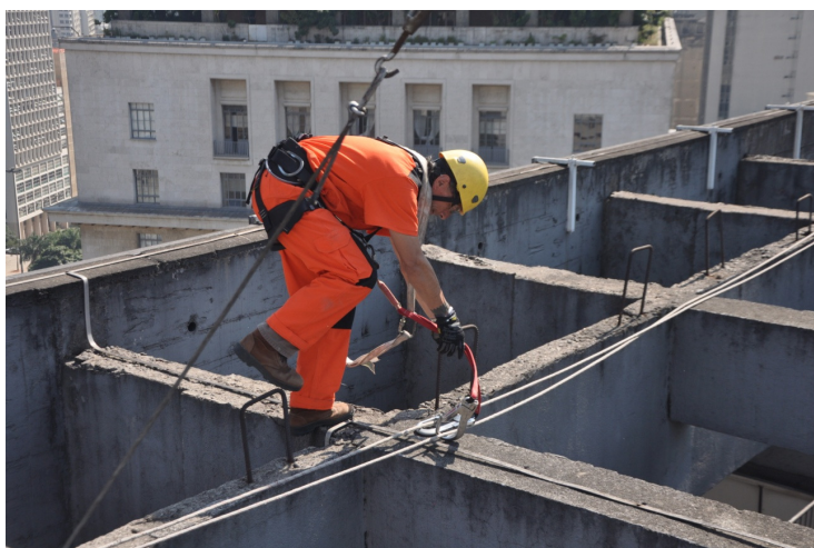
Figura 29: Talabarte duplo conectado à linha de vida Fonte: Arquivo pessoal, 2012
