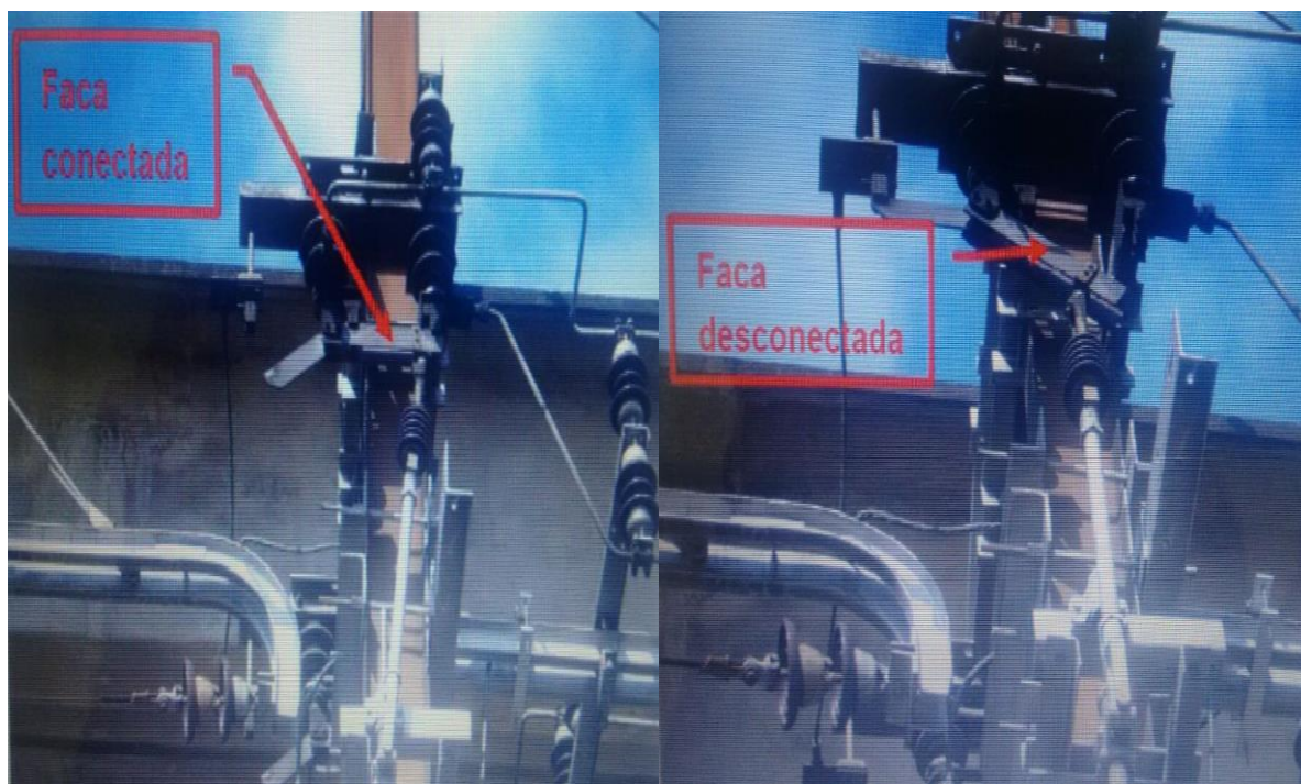
Figura 11 – Posicionamento da chave faca (conectada e desconectada)
