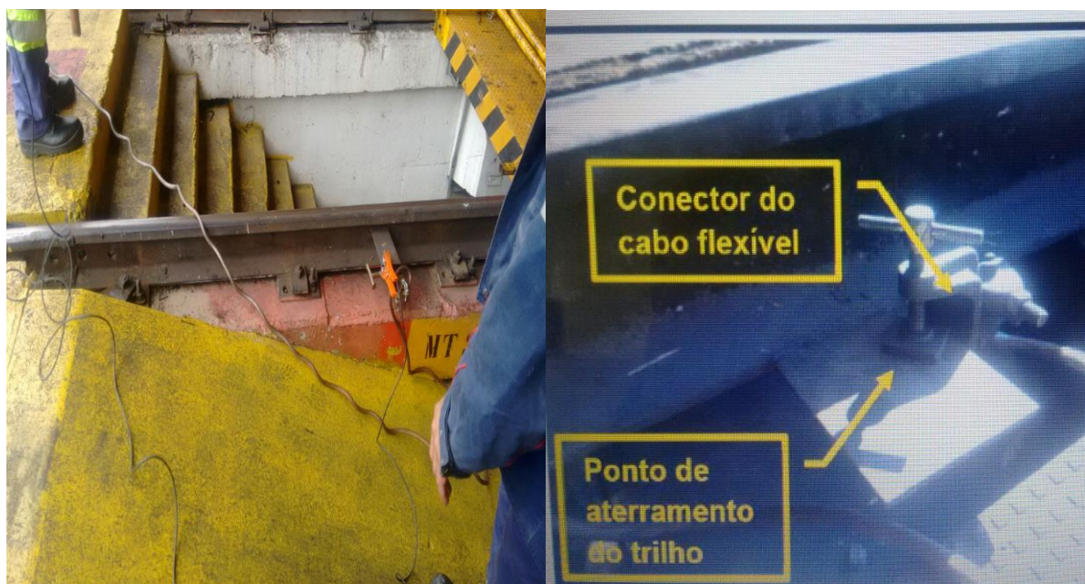
Figura 197 – Cabo de cobre e grampo sendo fixados na linha do trem para aterramento da rede aérea
