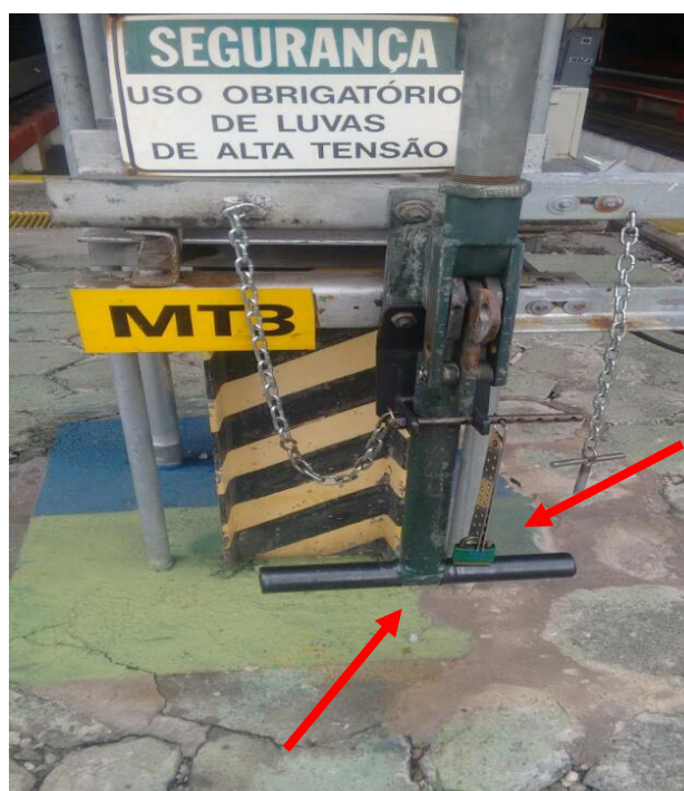
Figura 13 – Rede Aérea MT3 desligada (cadeado verde indicando o desligamento e a chave está com a alavanca para baixo)
