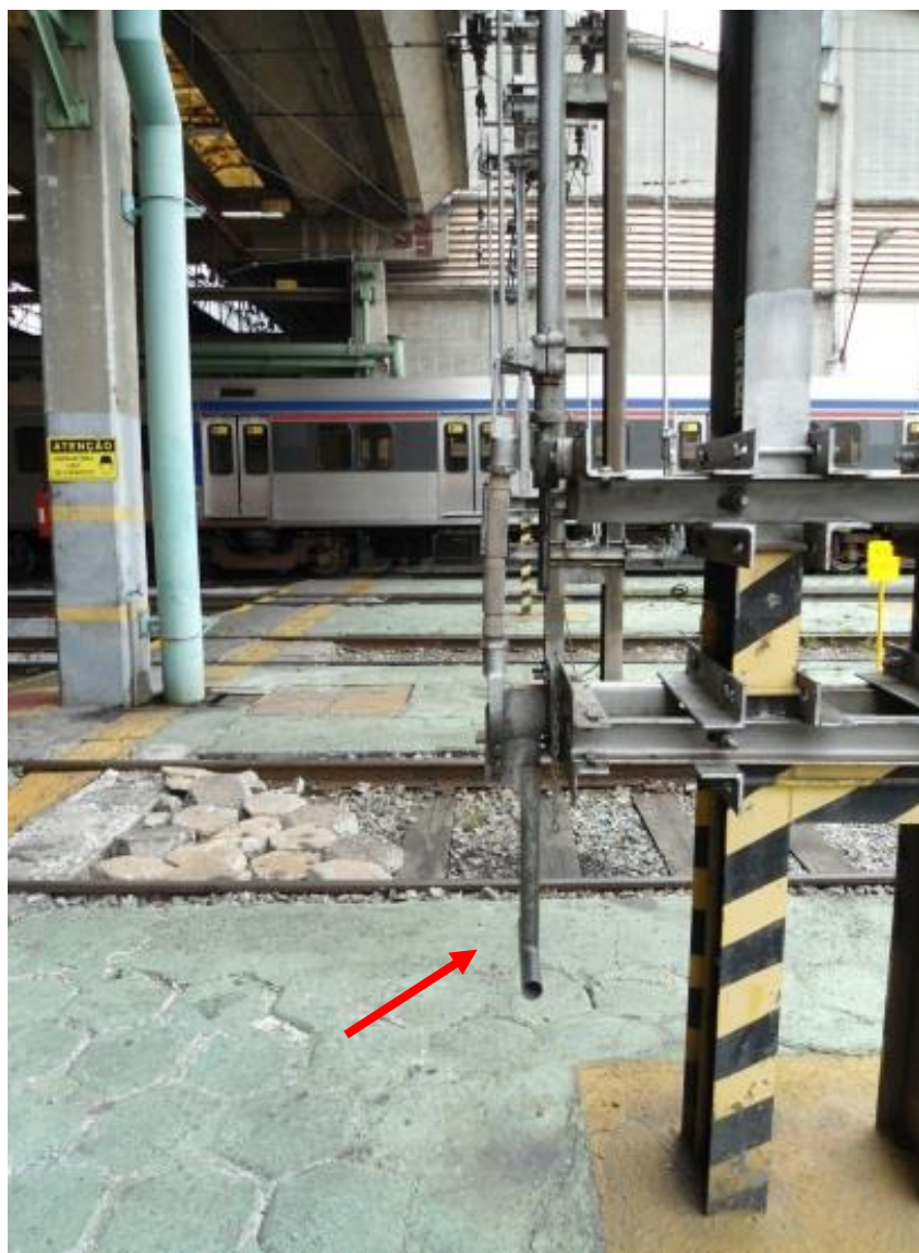
Figura 8 – Posição baixo aberta = rede aérea desenergizada ou desligada
