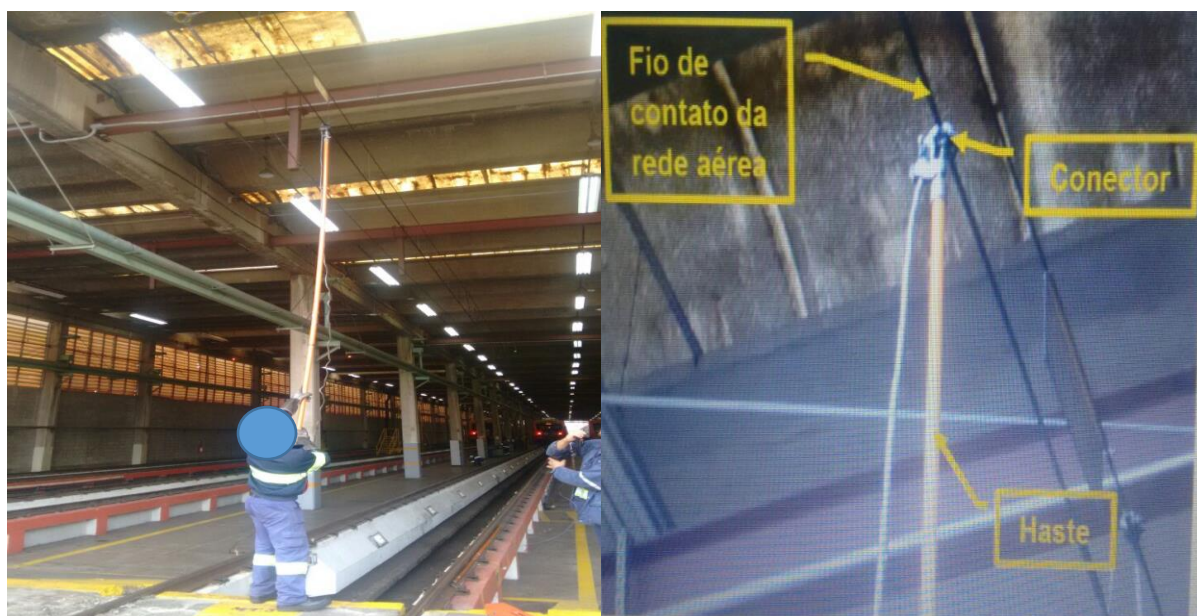
Figura 186 – Colaborador realizando o Aterramento da Rede Aérea
