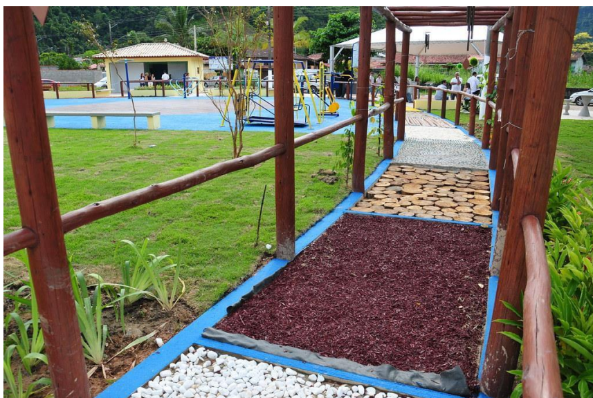
Figura 45- Exemplo de passarela tátil
