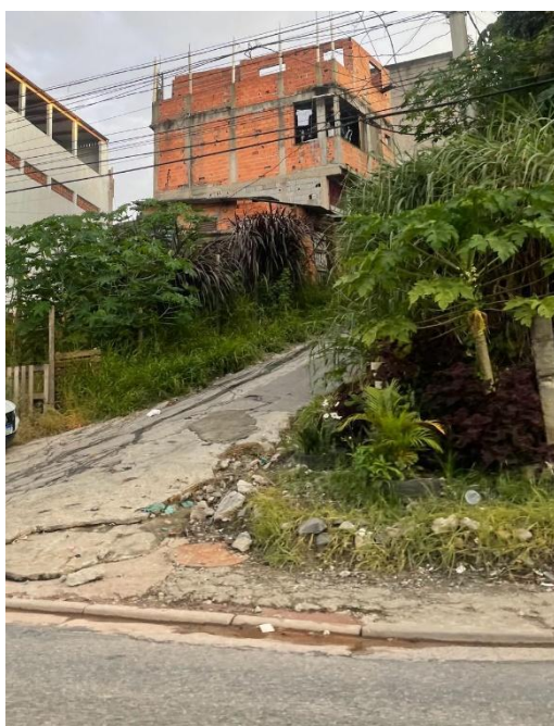
Imagem 9 - Asfalto esburacado
