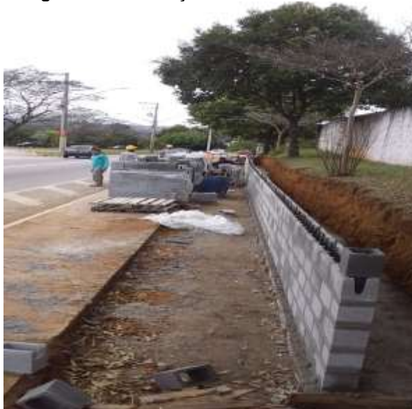
Figura 27 - Execução dos muros de arrimo
