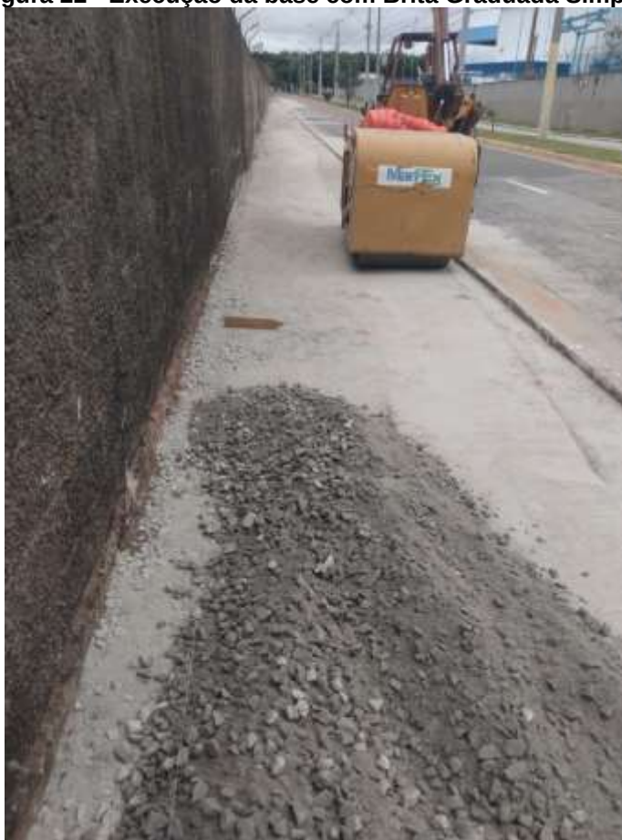
Figura 22 - Execução da base com Brita Graduada Simples
