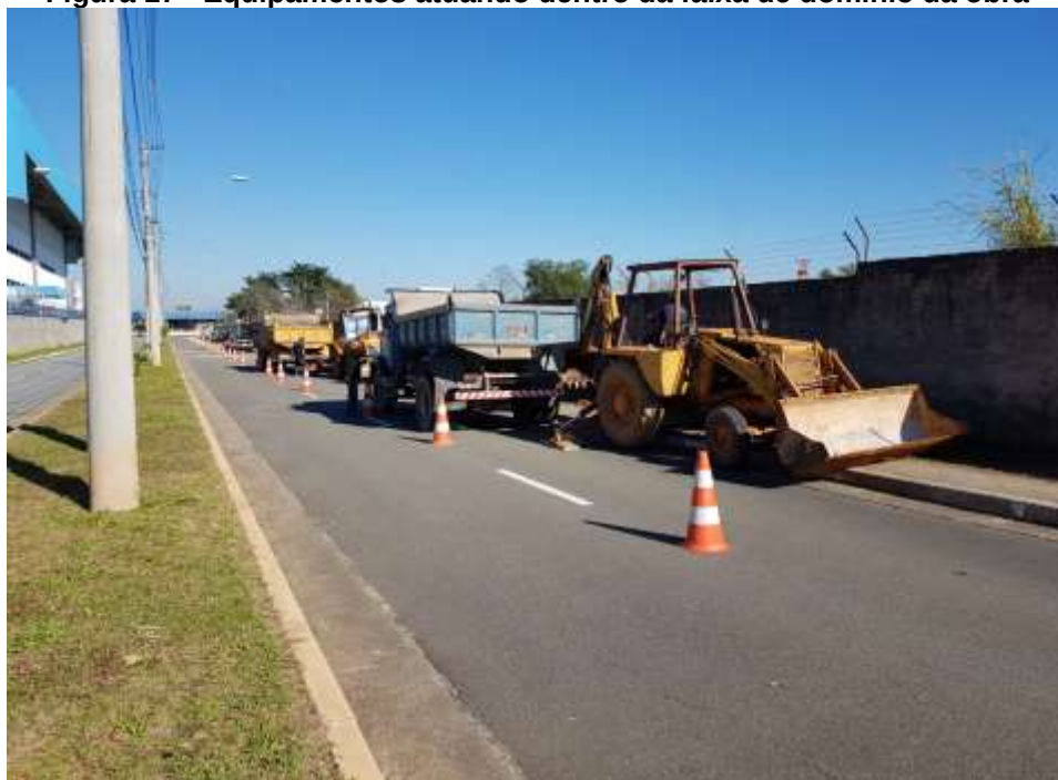
Figura 17 - Equipamentos atuando dentro da faixa de domínio da obra
