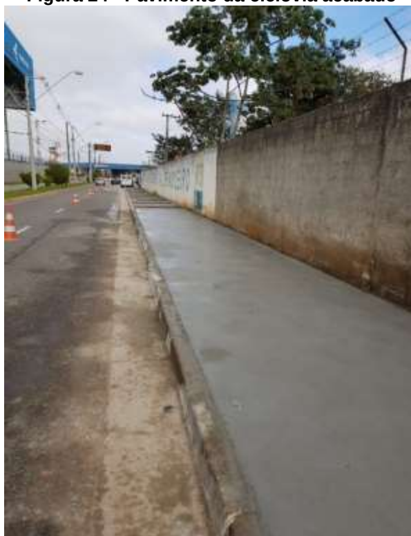
Figura 24 - Pavimento da ciclovia acabado
