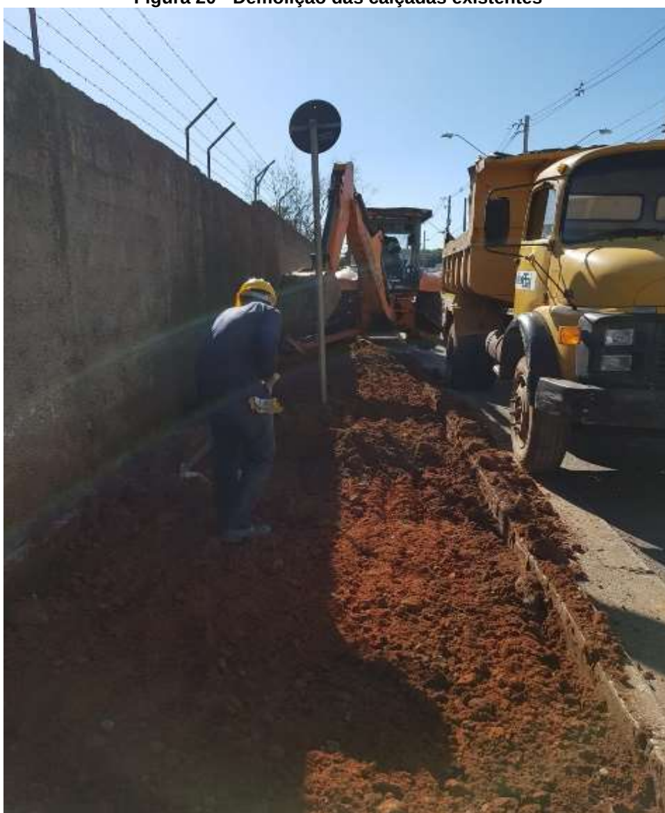
Figura 20 - Demolição das calçadas existentes
