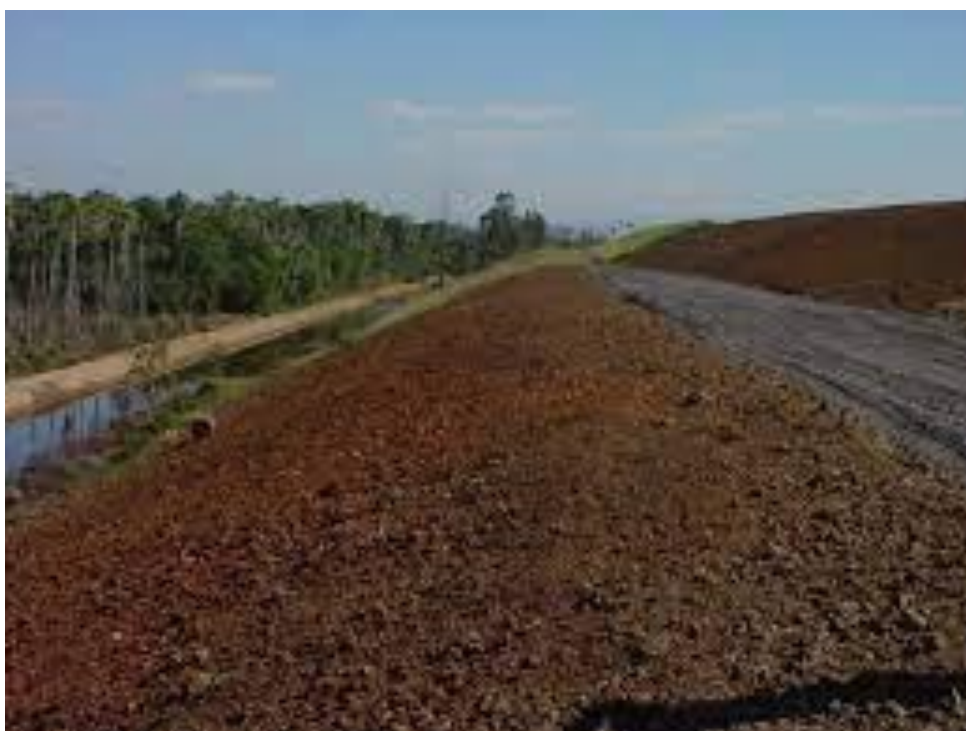
Figura 6 – Exemplo de cobertura seca em área com DAM
