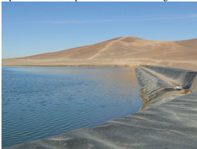
Figura 8 – Exemplo de microencapsulamento de resíduo gerador de DAM
