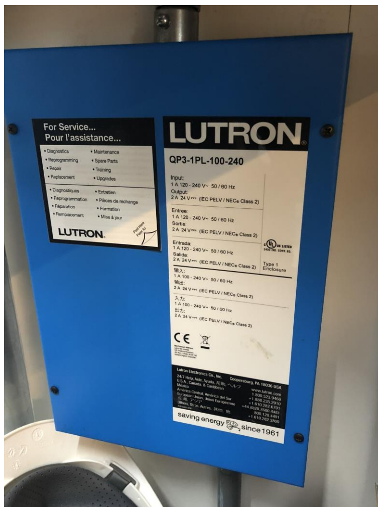
Figura 18: Central de controle de iluminação
