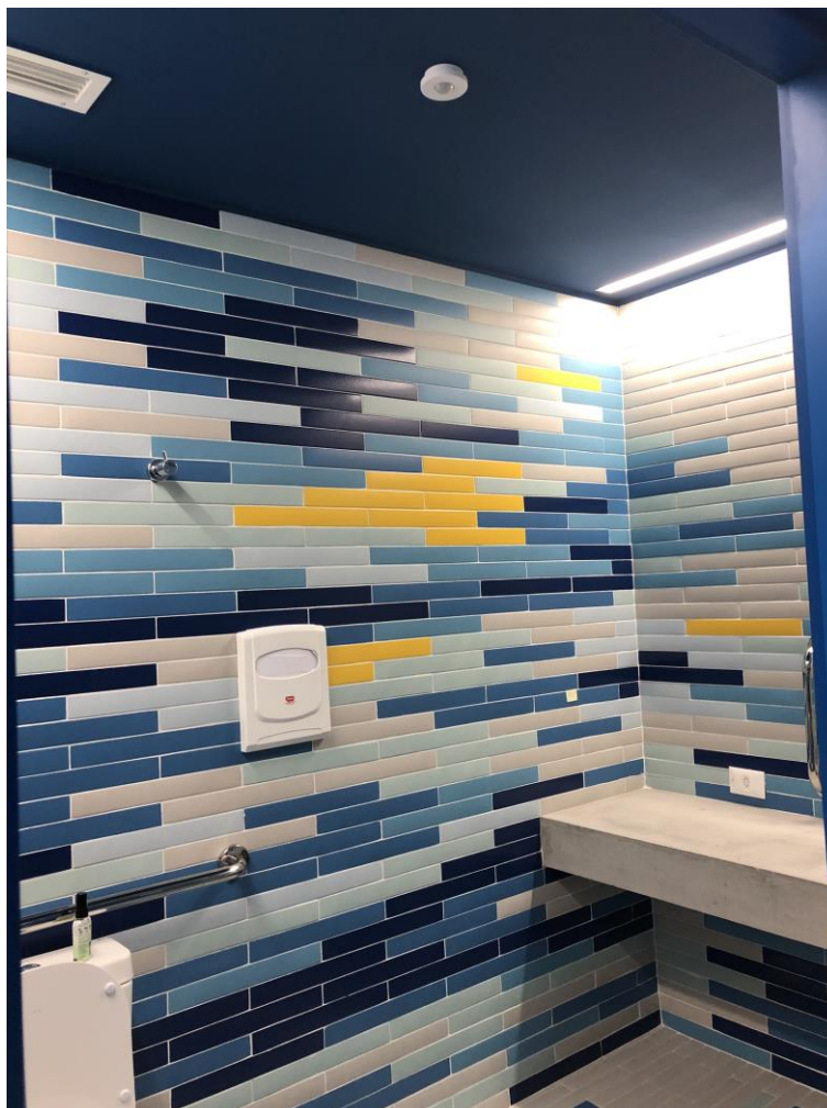
Figura 13: Sensor de presença no teto de um banheiro
