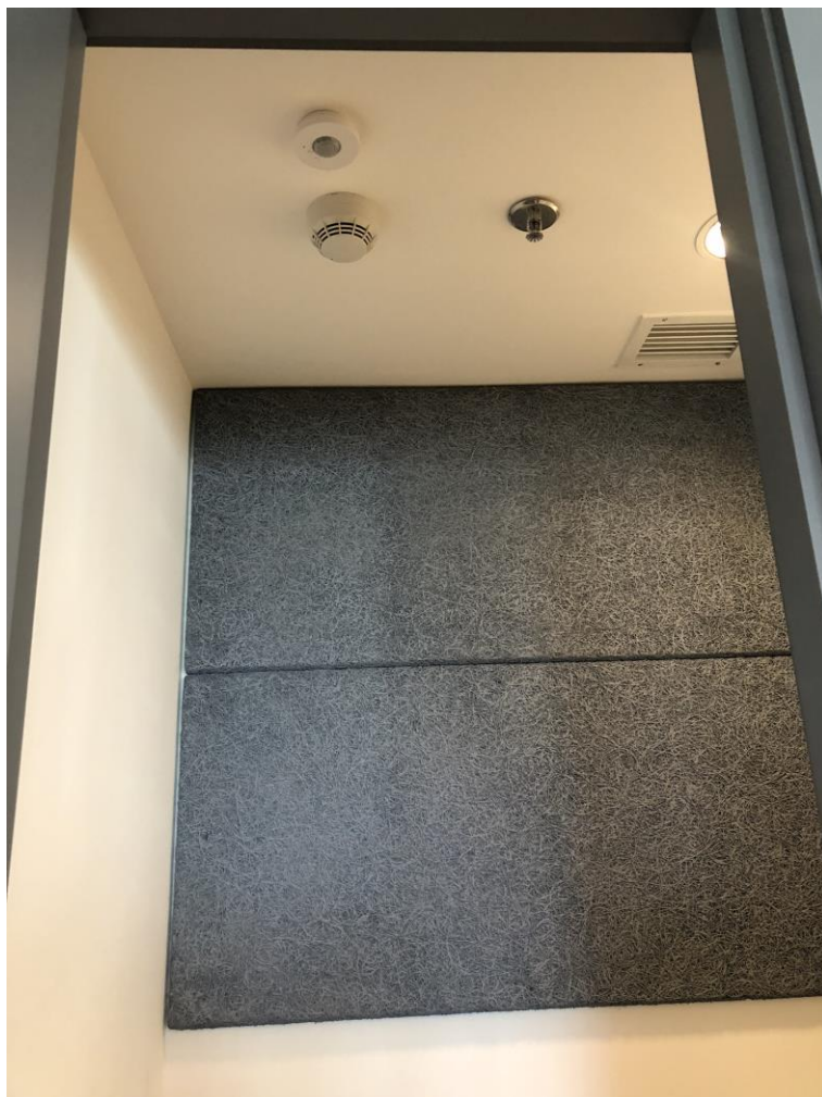
Figura 12: Sensor de presença no teto de uma sala de reunião pequena
