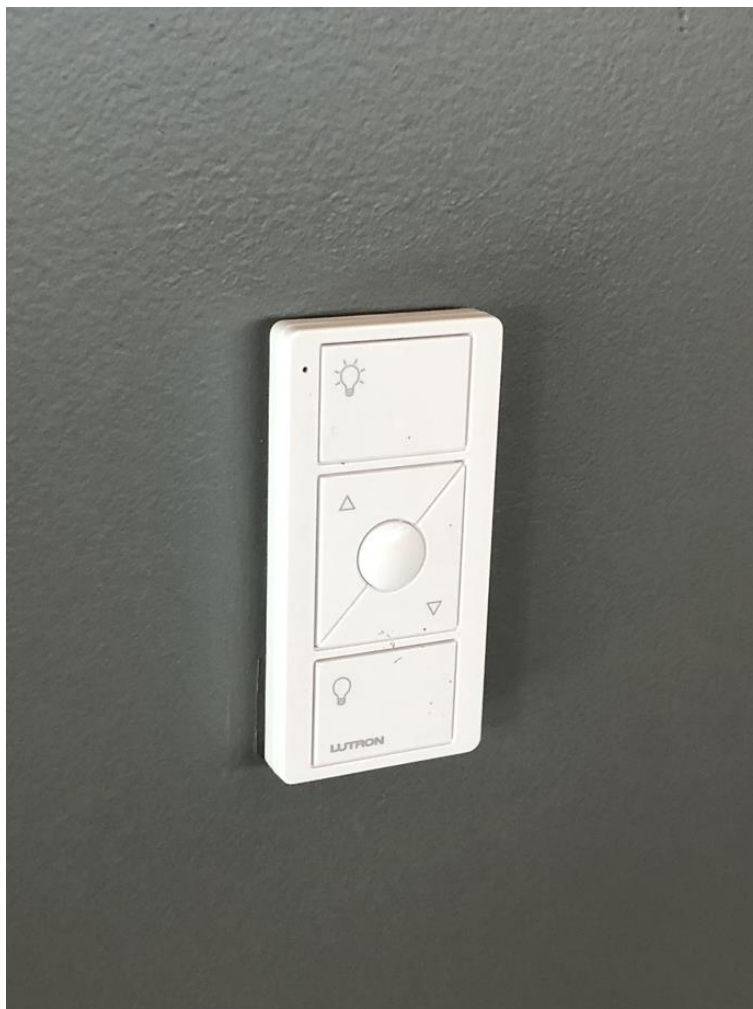
Figura 16: Controle para luminária dimerizável
