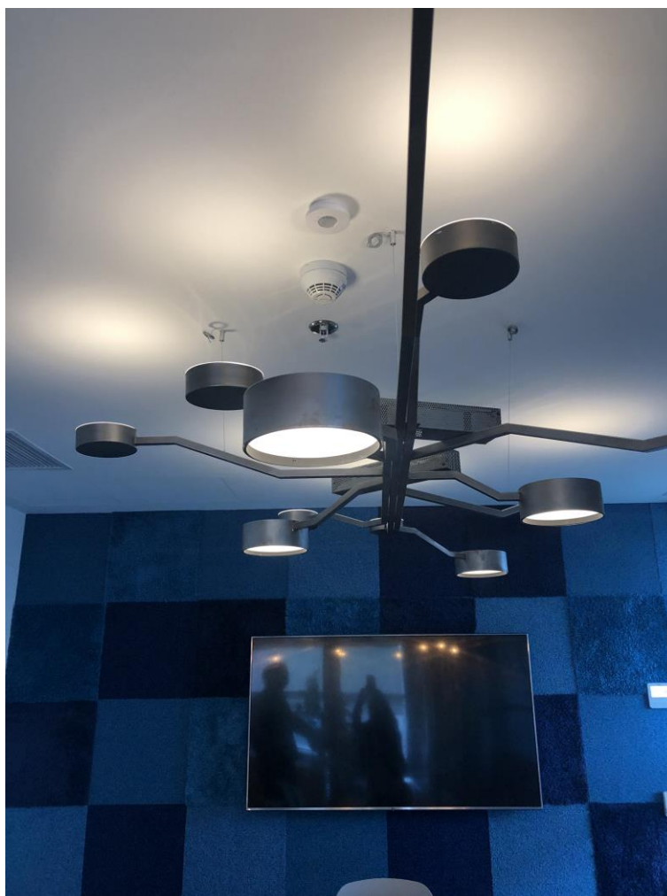
Figura 11: Sensor de presença no teto de uma sala de reunião média com dimerização
