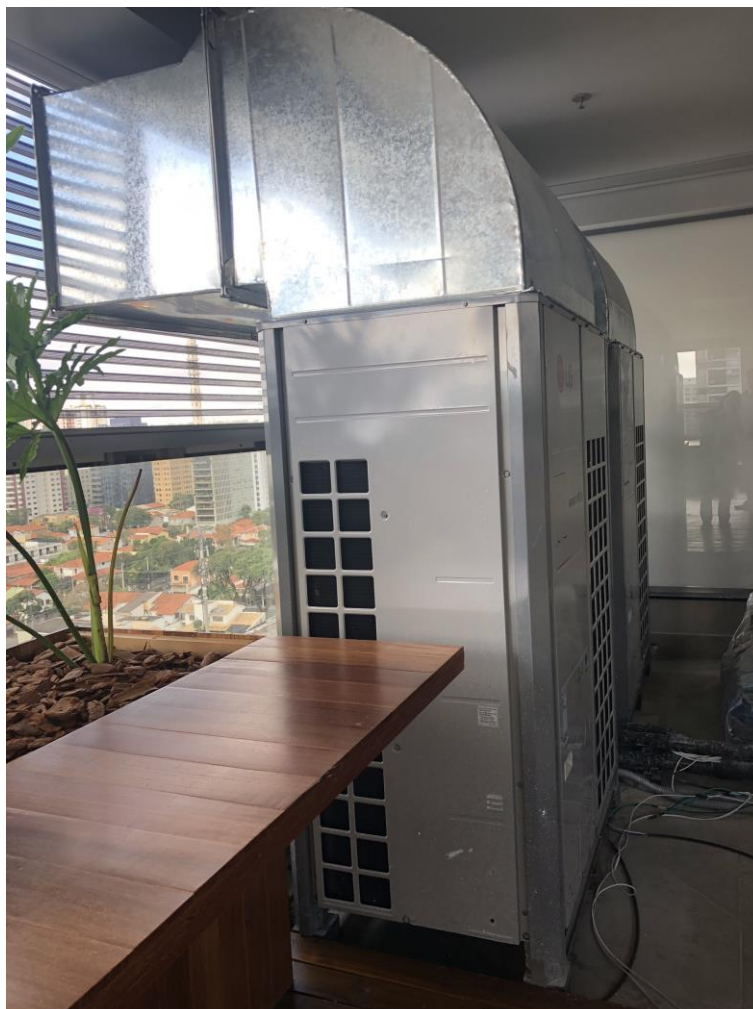
Figura 27: Unidades externas instaladas na área técnica
