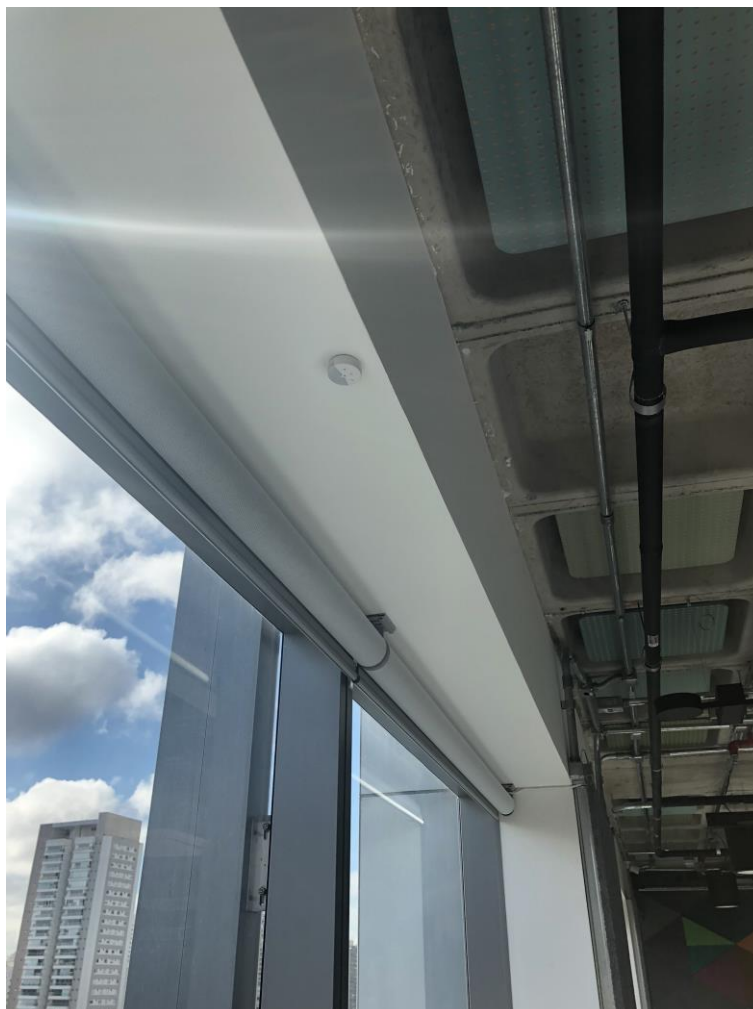
Figura 9: Sensores de luminosidade posicionados próximos à fachada
