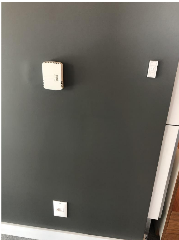
Figura 22: Medidor de CO 2 instalado em área aberta
