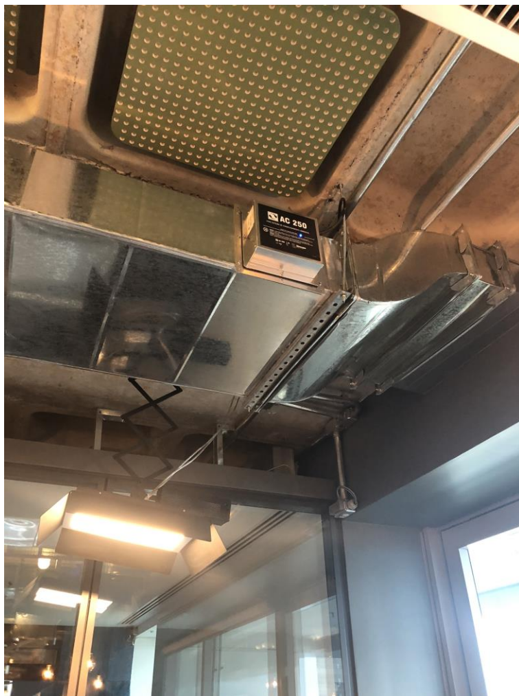
Figura 28: Ecoquest instalada no duto de ar-condicionado
