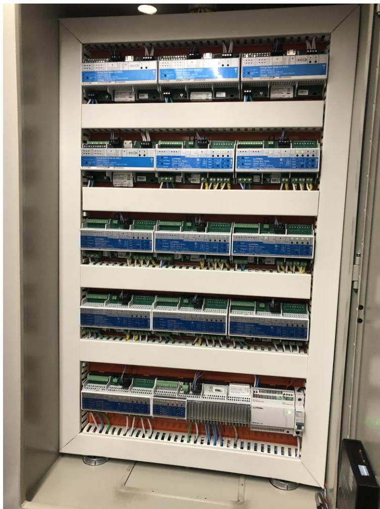
Figura 17: Painel elétrico para automação de iluminação
