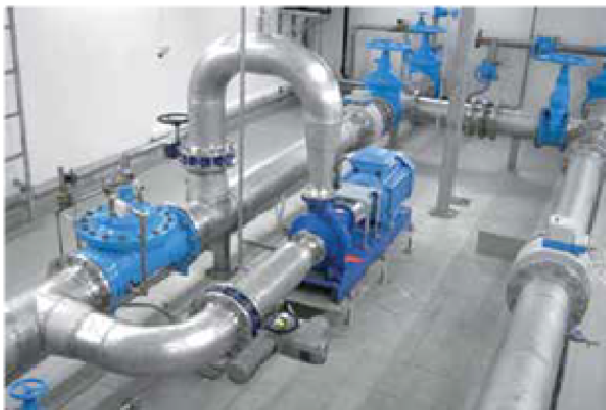
Figura 15 - Bomba, regulador e gerador de uma BFT.
