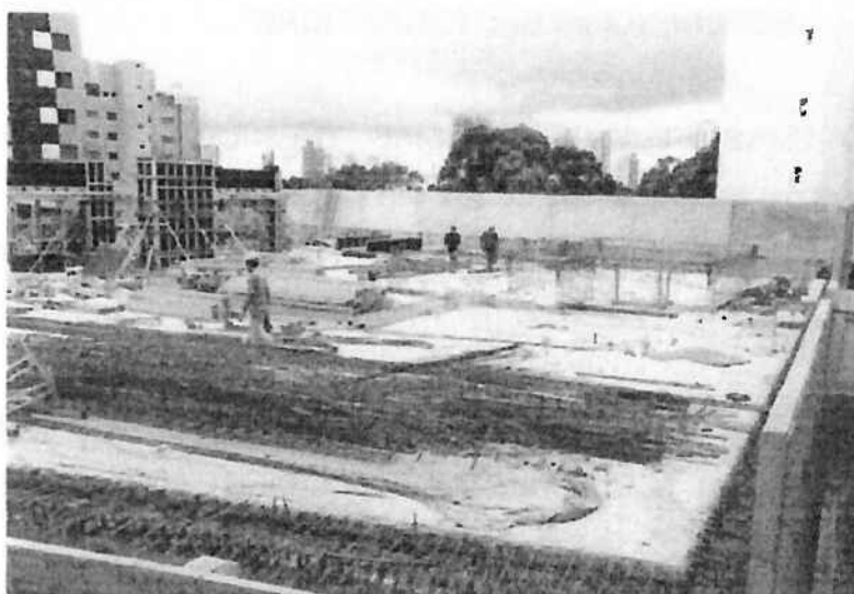
Vista do pavimento térreo com laje protendida e ferragens de consolidação com os painéis tilt-up
