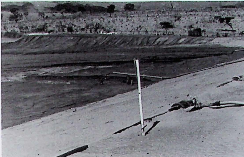
Figura 5.2c – Sistema de lançamento em vários pontos simultâneos 'spigots'.
