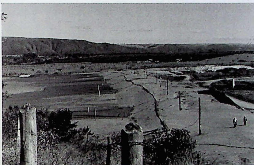
Figura 5.2b – Vista geral da barragem de rejeito da mineradora Bunge de Araxá.
