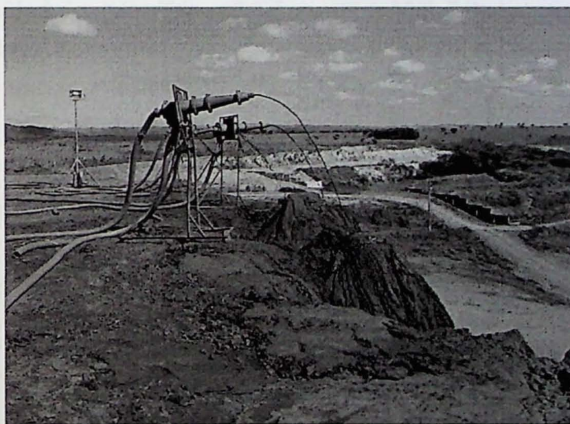
Figura 5.2f - Lançamento dos rejeitos ciclonados 'underflow', imagem detalhada da Figura 5.2e.
