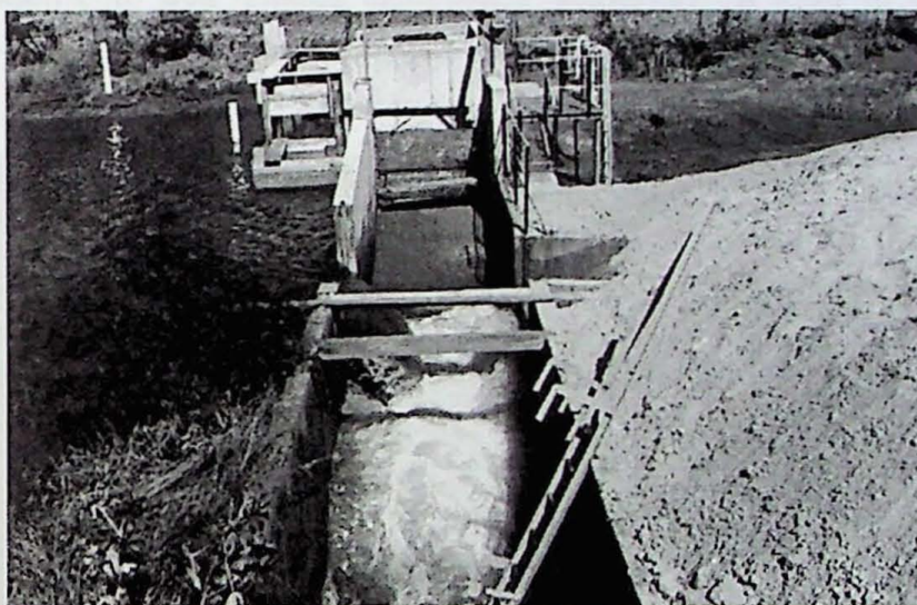
Figura 5.2d – Sistema de drenagem utilizada na barragem de rejeito Bunge Araxá.
