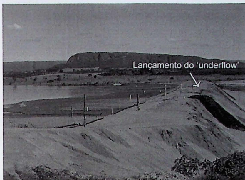
Figura 5.2e – Lançamento dos rejeitos ciclonados 'underflow' à jusante da barragem para o emprego na construção do corpo da barragem.
