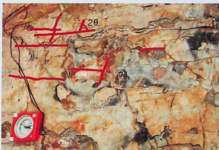
Foto 6.5 – Juntas de cisalhamento, em destaque o ângulo 20.
