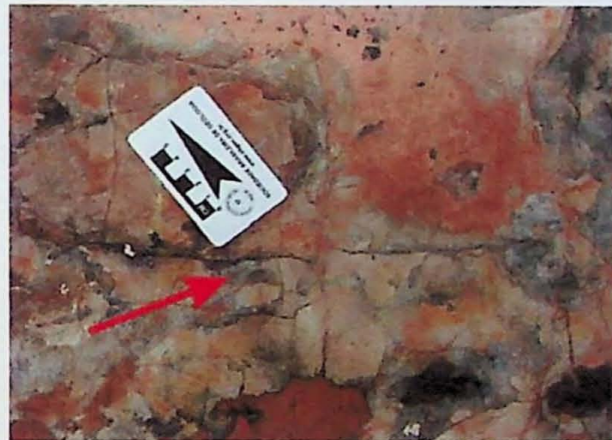
Foto 6.2 – Junta preenchida com betume
