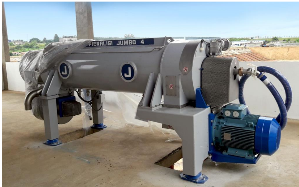
Figura 17 – Centrífuga da ETE Mário Araldo Candello (Indaiatuba).
