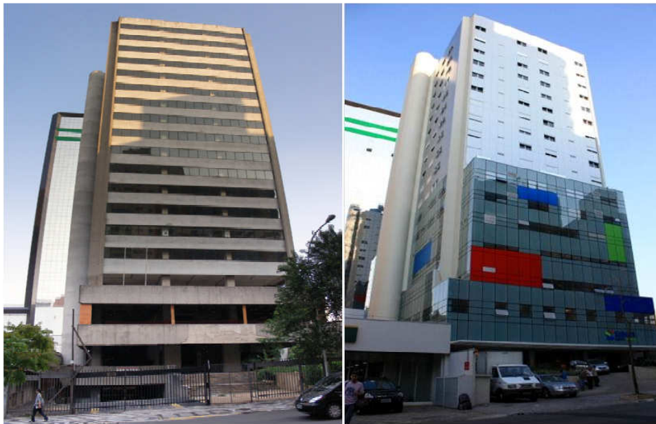
Figura 6 - Fotos antes e depois da Reforma
