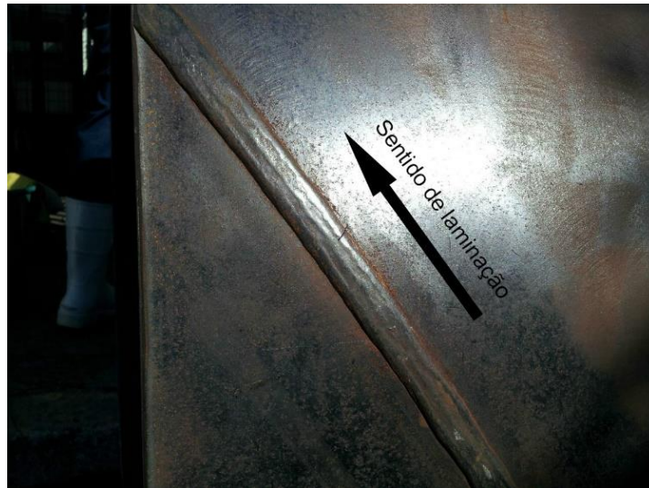
Figura 17 – Sentido de laminação da chapa de alto nióbio
