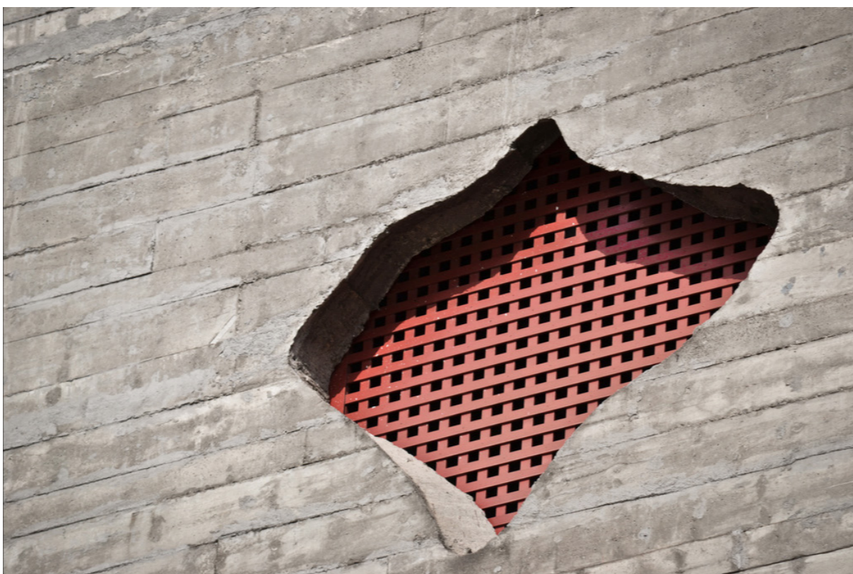
Figura 05: Janela buraco do Sesc Pompéia, de Lina Bo Bardi.
