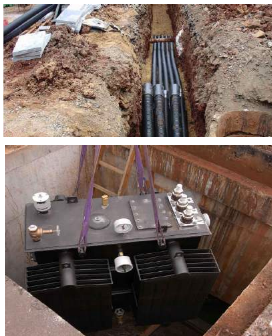
Figura 09 - Bancos de dutos e câmara para instalação de equipamentos em área de alta densidade de carga. (Fonte: COPEL, 2010)
