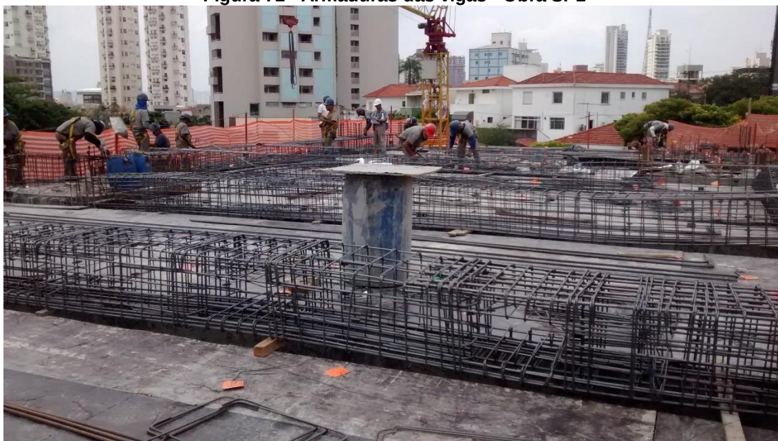
Figura 71 - Armaduras das vigas - Obra SP1
