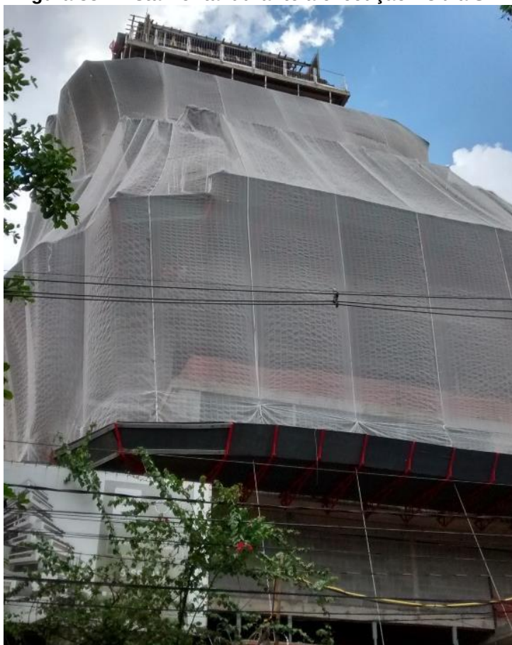
Figura 33 - Vista frontal durante a execução - Obra SP1
