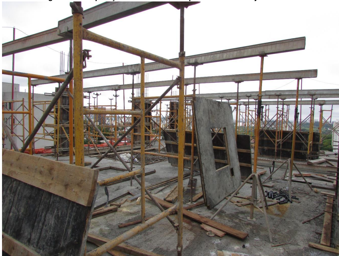
Figura 35 - Preparação do escoramento para a fôrma da laje - Obra SP1
