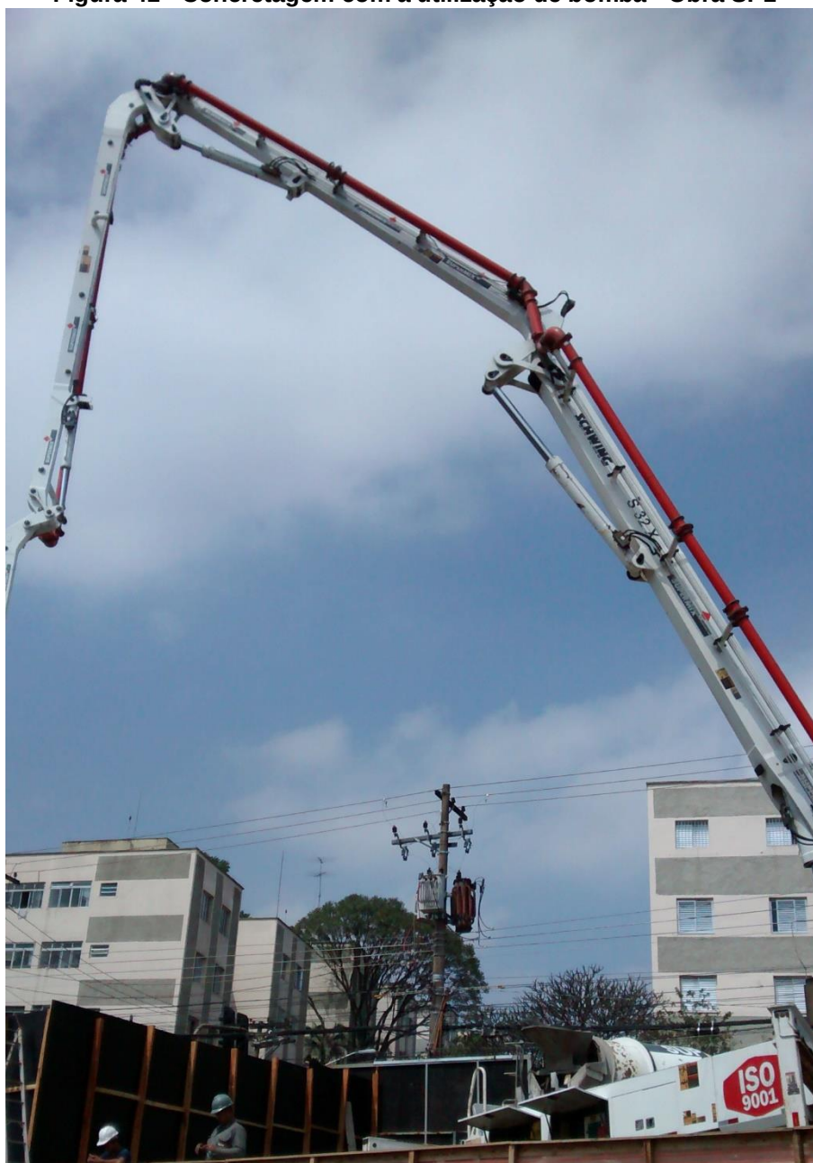
Figura 41 - Concretagem com a utilização de bomba - Obra SP1
