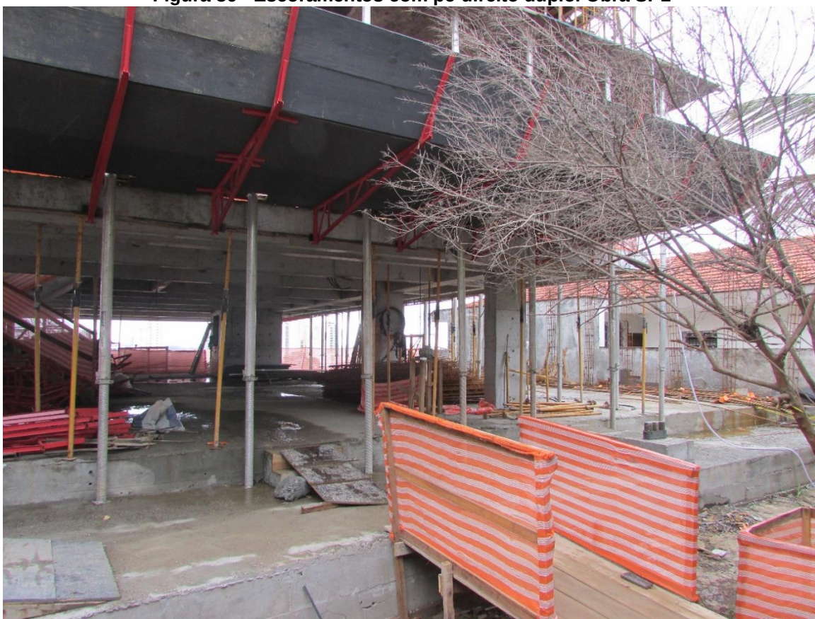
Figura 37 - Escoramento apoiado em pequenas vigas em balanço - Obra SP1
