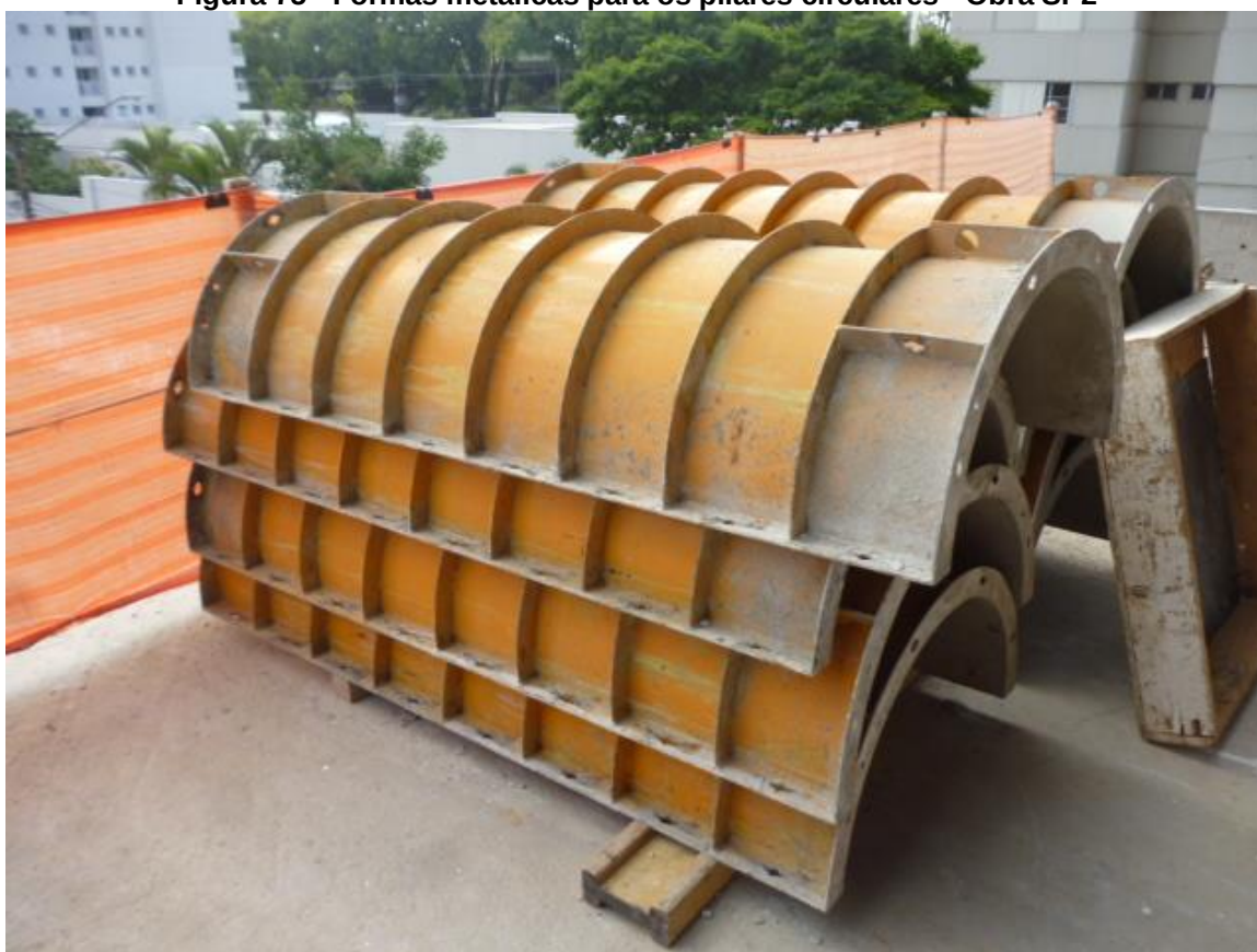
Figura 75 - Fôrmas metálicas para os pilares circulares - Obra SP2
