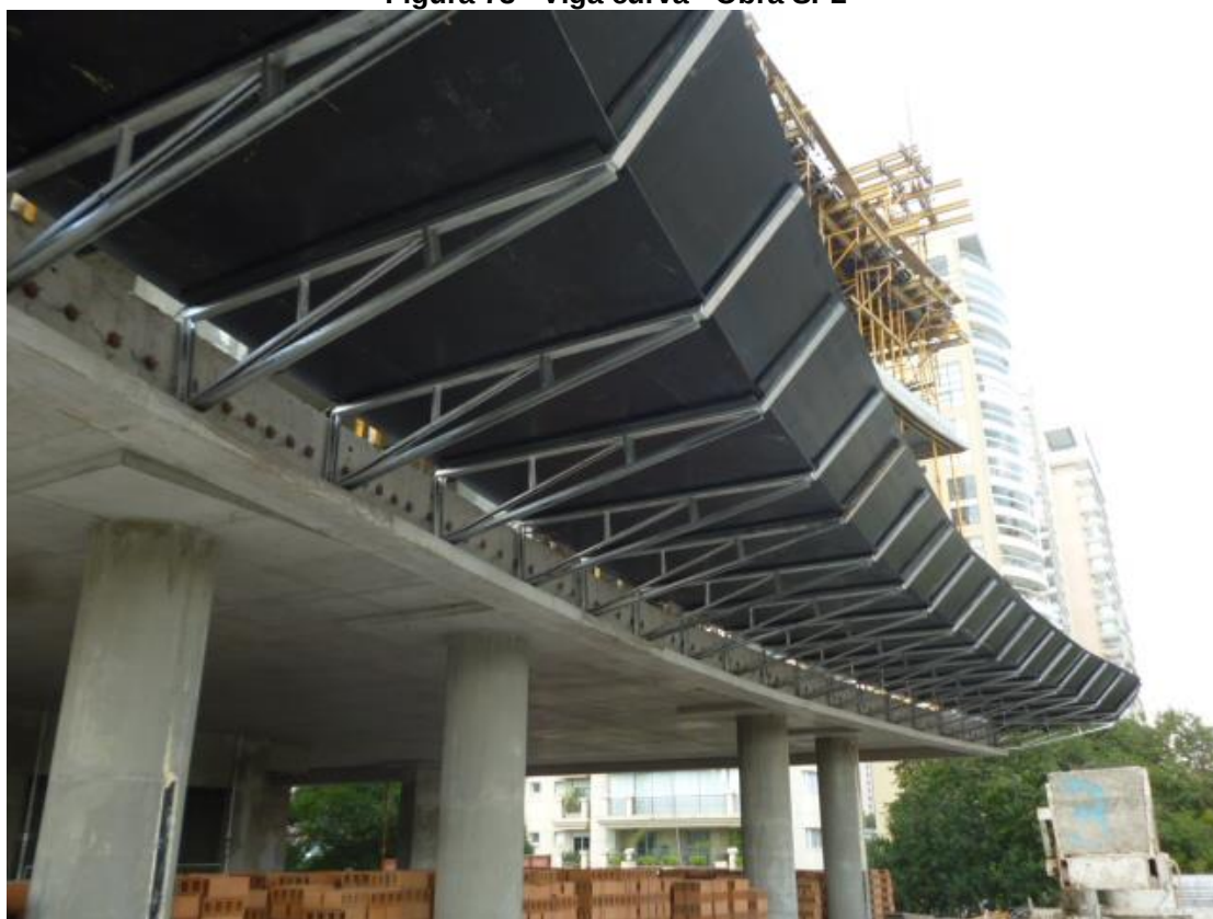
Figura 73 - Viga curva - Obra SP2
