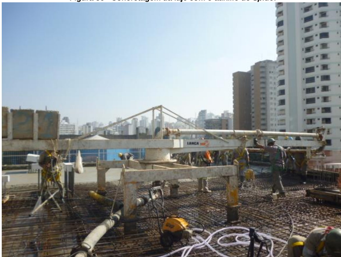
Figura 56 - Concretagem da laje com o auxílio do Spider
