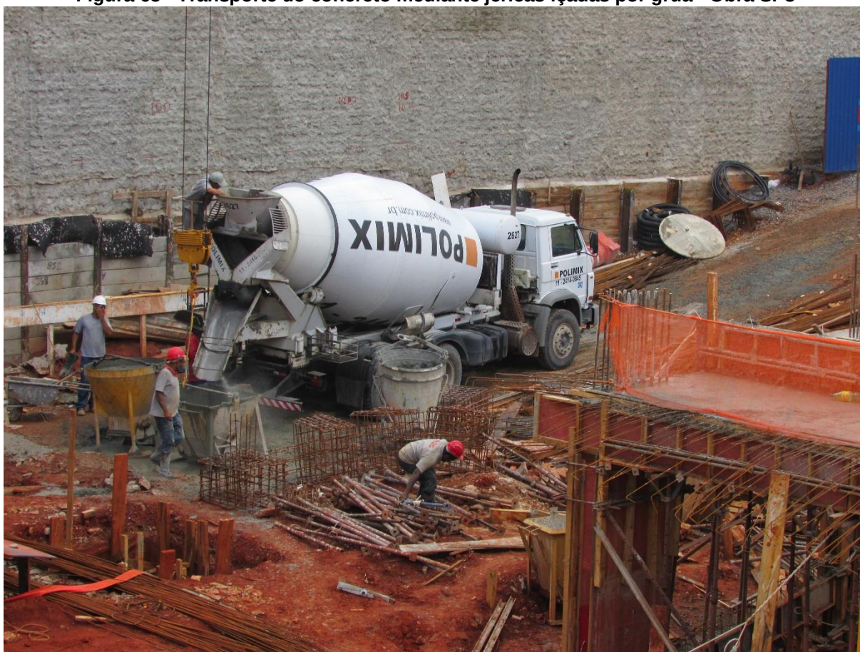
Figura 65 - Transporte do concreto mediante jericas içadas por grua - Obra SP3
