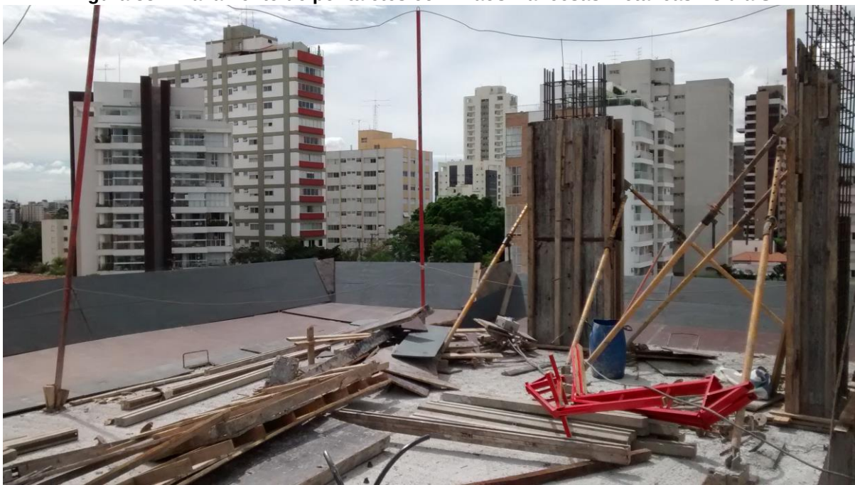
Figura 38 - Travamento de pontaletes com mãos-francesas metálicas - Obra SP1
