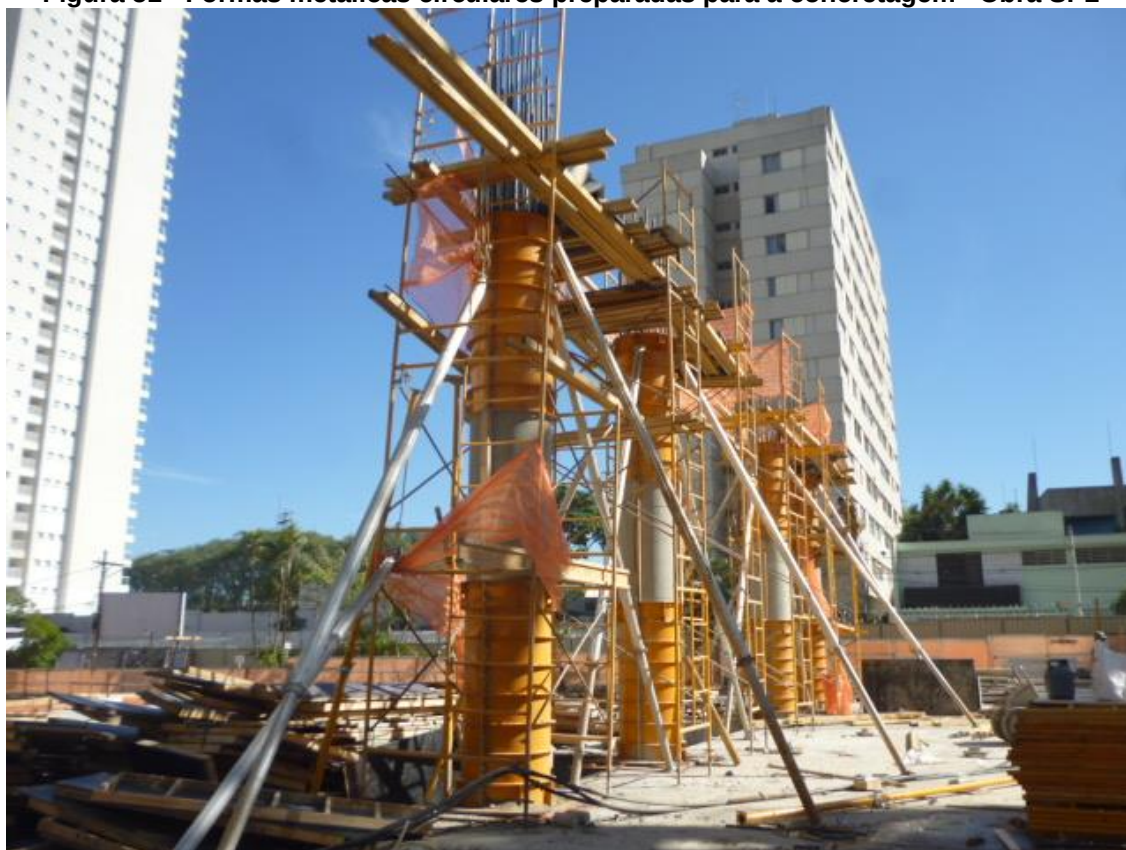
Figura 51 - Fôrmas metálicas circulares preparadas para a concretagem - Obra SP2
