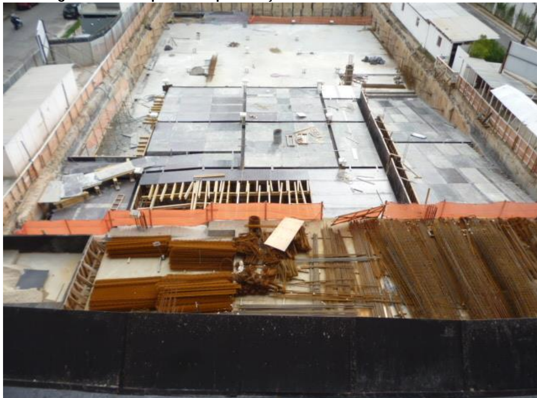
Figura 54 - Área para estoque de aço pré-cortado e pré-dobrado e armaduras montadas - Obra SP2
