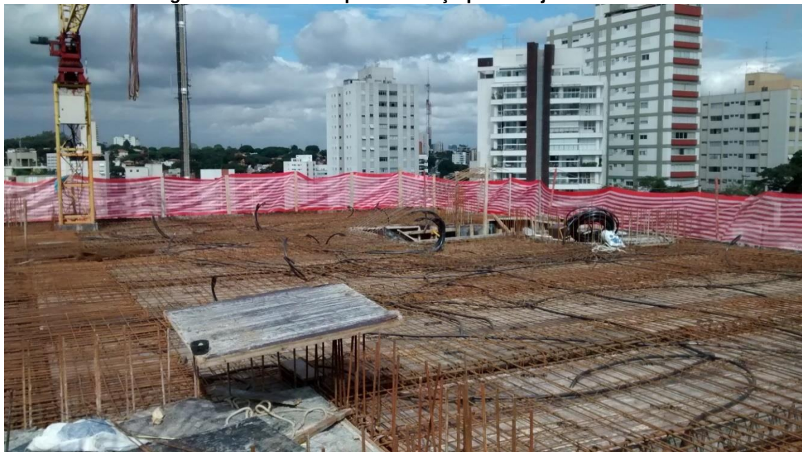
Figura 40 - Grua transportando aço para a laje – Obra SP1
