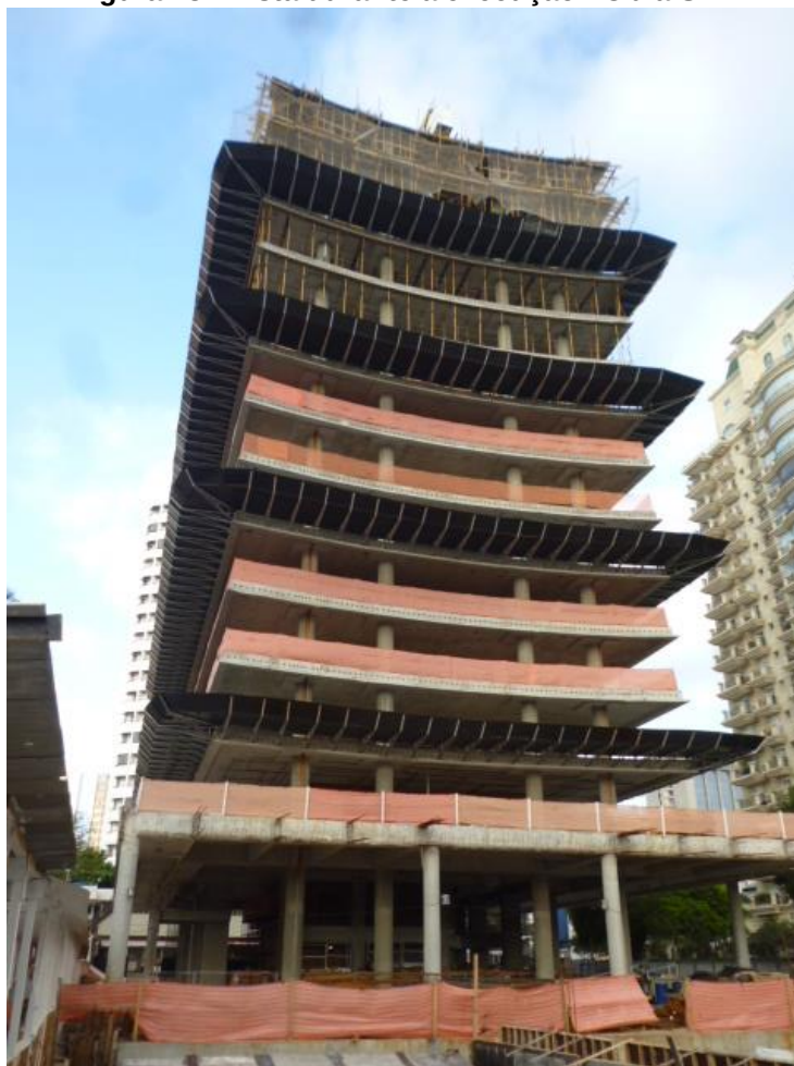
Figura 48 - Vista durante a execução - Obra SP2
