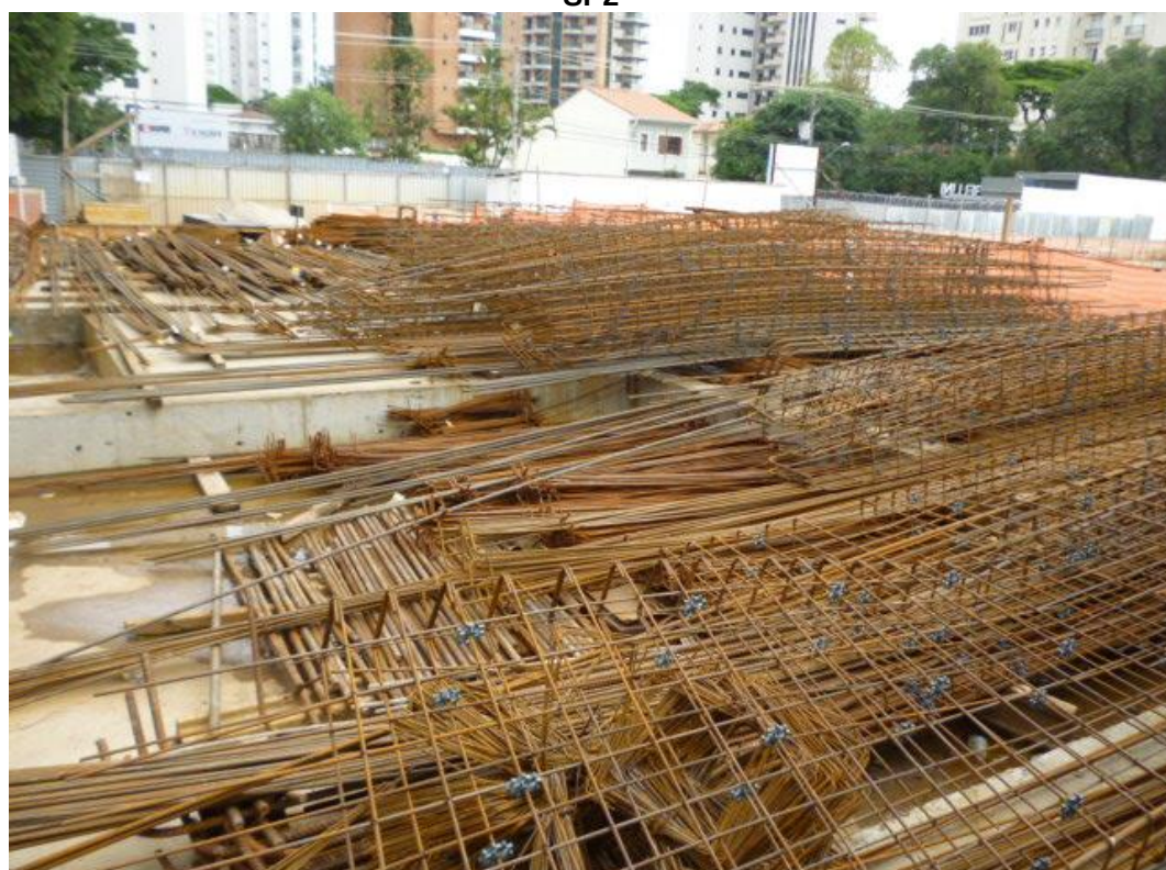
Figura 54 - Área para estoque de aço pré-cortado e pré-dobrado e armaduras montadas - Obra SP2
