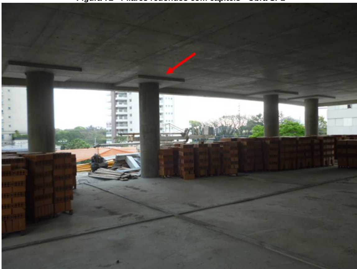
Figura 73 - Viga curva - Obra SP2
