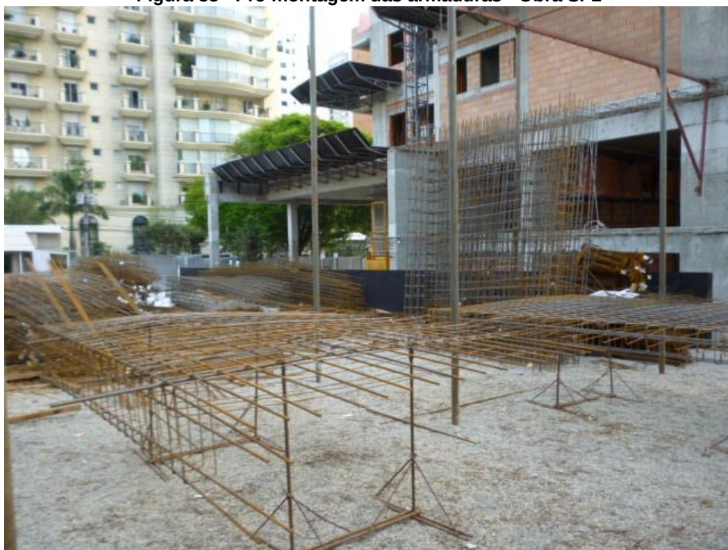
Figura 55 - Pré-montagem das armaduras - Obra SP2
