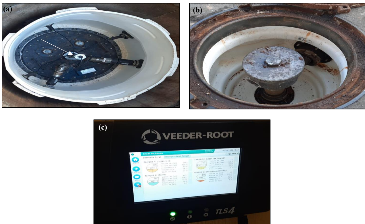
Figura 10 - Sistema de controle e detecção automática de vazamentos de combustíveis (Monitoramento intersticial): (a) Sensor de detecção de líquidos; (b) Tubo do sensor Intersticial; e (c) sistema de medição e monitoramento ambiental da Veeder-Root Modelo TLS4
