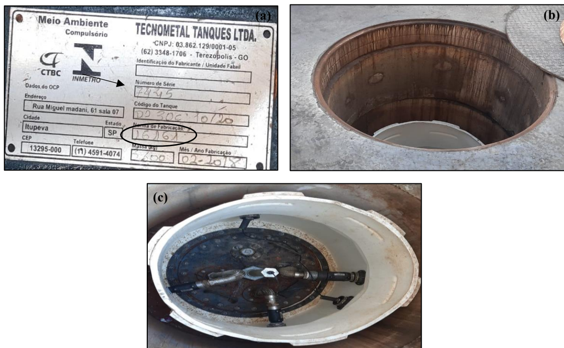
Figura 8 - (a) Especificações Técnicas de um dos tanques subterrâneos fabricado conforme a NBR 16.161; (b) Câmara de acesso à boca de visita do tanque; e (c) Câmara de contenção na boca de visita do tanque.
