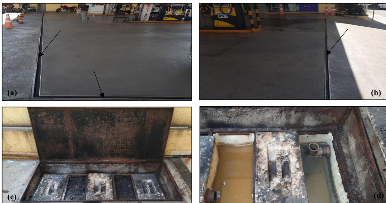
Figura 12 – (a) e (b) Sistema de drenagem de oleosos formado pelas canaletas que direcionam os efluentes gerados na pista de abastecimento para a (c) e (d) Sistema Separador de água e óleo que depois de tratado é destinado a rede coletora do DEMAEE.
