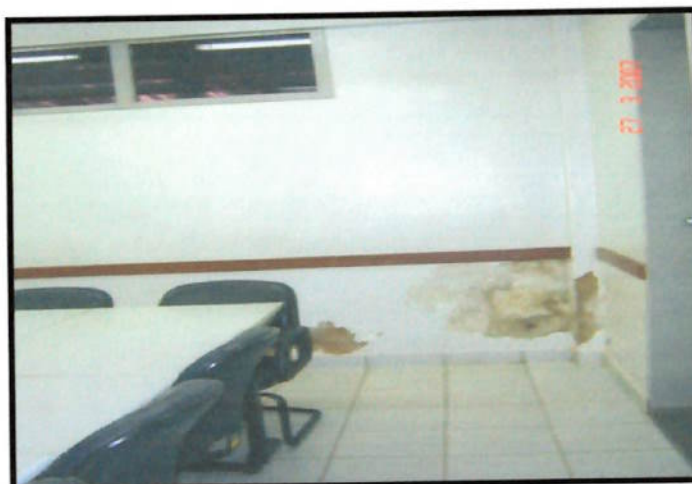
Fig. 8.3 - Infiltração em Sala de Treinamento.
