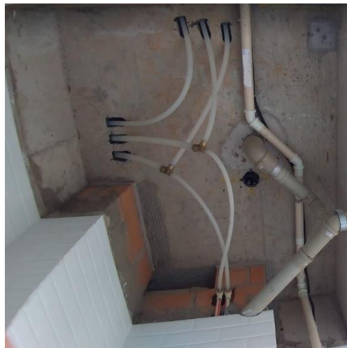
Figura 42: Conexão de ramal em PEX com sub-ramal em CPVC.
