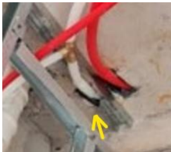
Figura 92: Perfil superior para drywall recortado.
