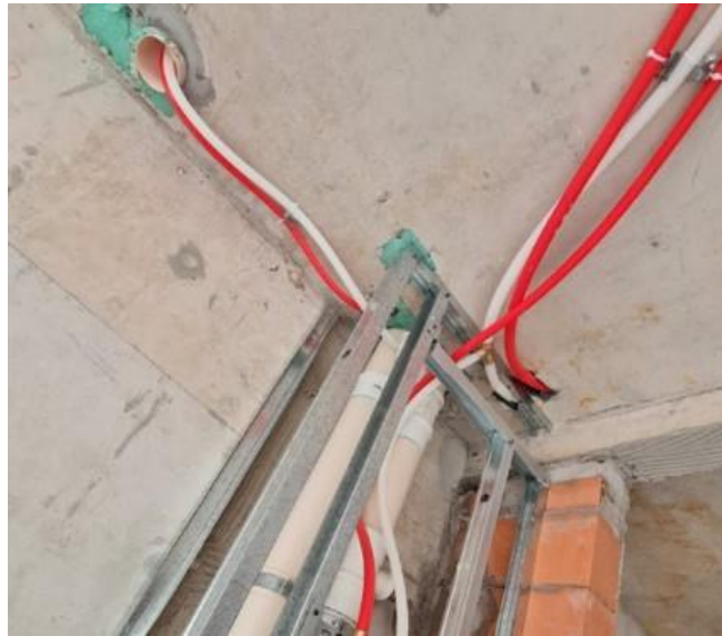
Figura 91: Primeira conexão dentro da unidade privativa.
