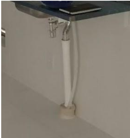
Figura 44: Tubos aparentes sob bancada.
