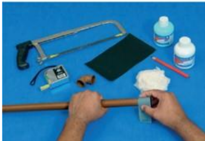
Figura 8: Corte e lixamento de PVC soldável.
