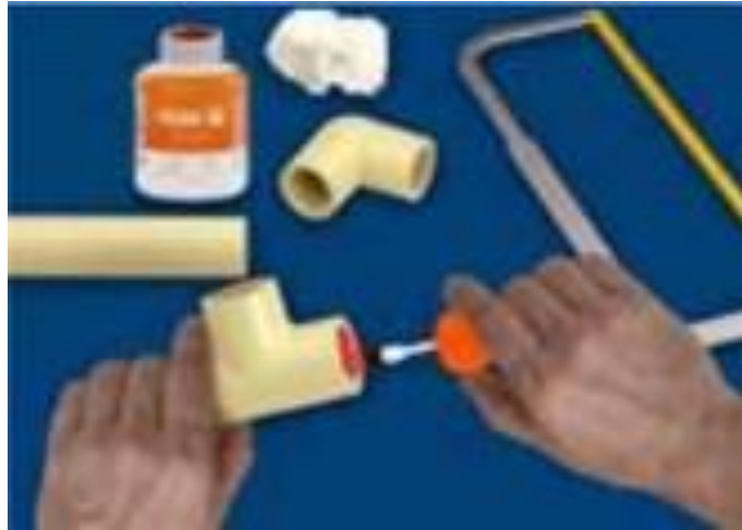
Figura 12: Corte, remoção de rebarbas e aplicação de cola.
