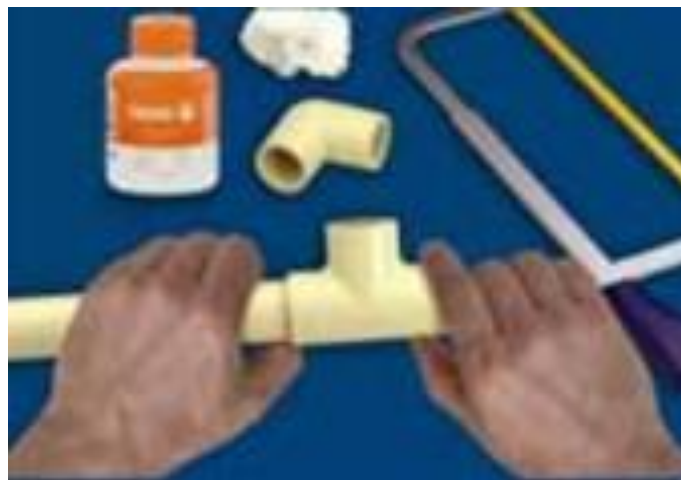
Figura 13: Encaixe, giro e estabilização por 30 segundos entre as peças.
