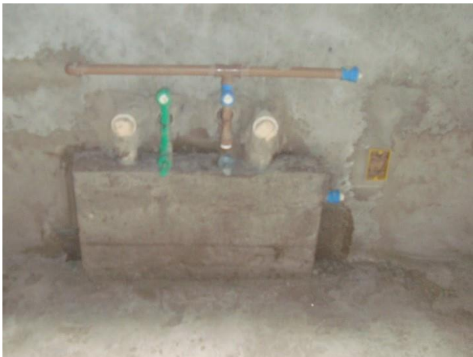
Figura 69: Enchimento em graute sob bancada de cozinha.
