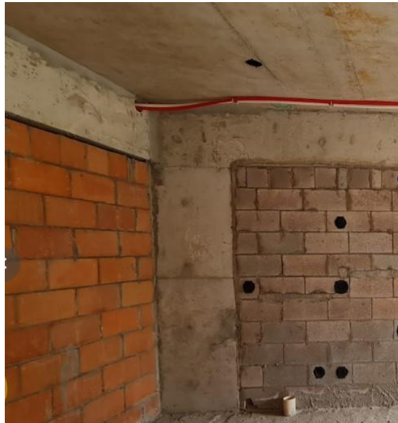
Figura 38: Ramal em PEX aparente.
