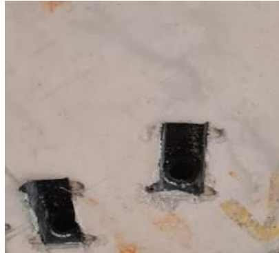
Figura 40: Tubo luva sem tubo PEX, visto por baixo da laje.
