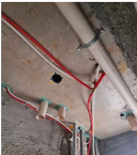
Figura 105: Sub-ramal em teto de banheiro.
