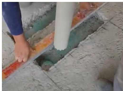
Figura 84: Furações sucessivas no passante em espuma.
