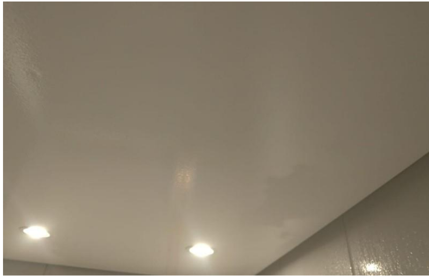
Figura 6: Forro de apartamento com molhado.
