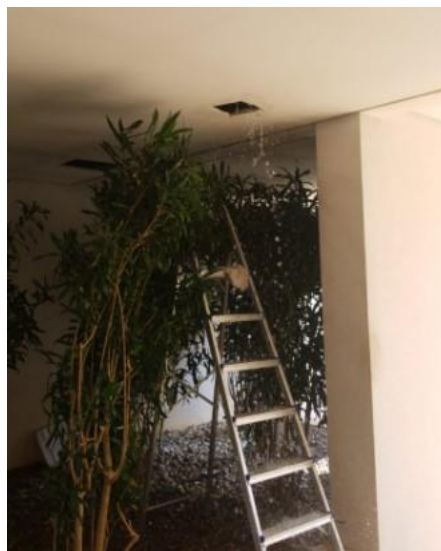
Figura 7: Vazamento sobre forro de entrada social.
