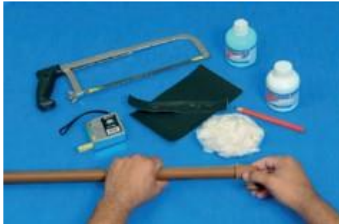
Figura 11: Encaixe e giro da conexão.
