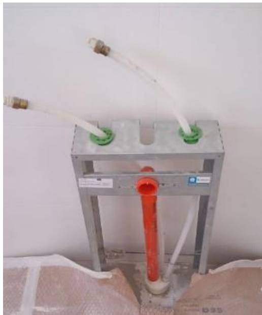
Figura 47: Kit chassi sob bancada.
