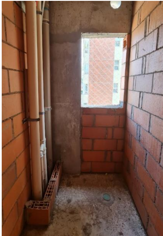
Figura 87: Elevação de alvenaria finalizada.
