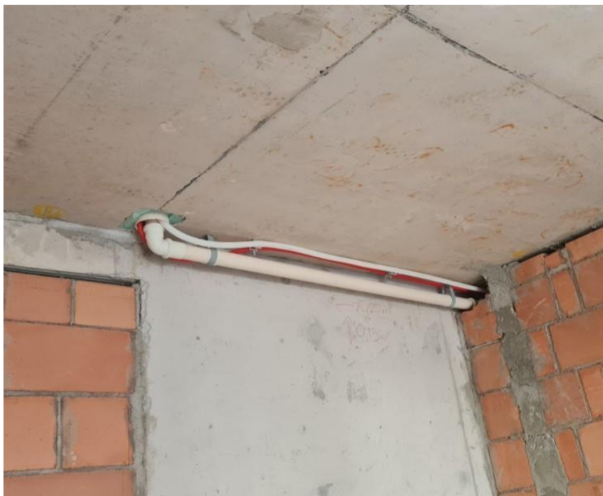
Figura 101: Tubos de alimentação e de esgoto da cozinha.
