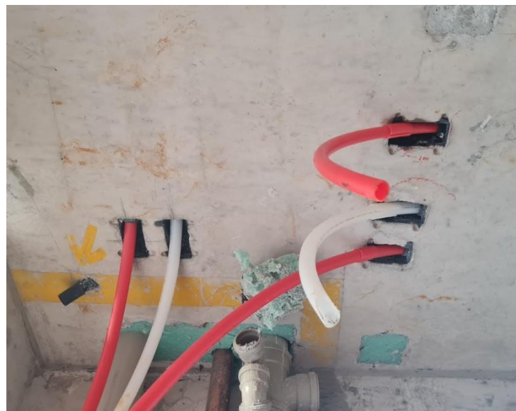
Figura 39: Ramal em PEX embutido.
