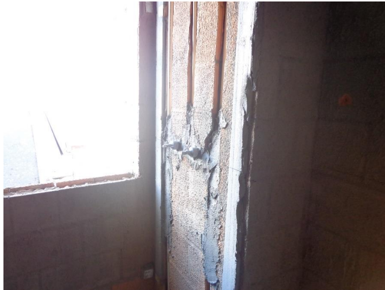
Figura 1: Cortes em alvenaria de vedação.
