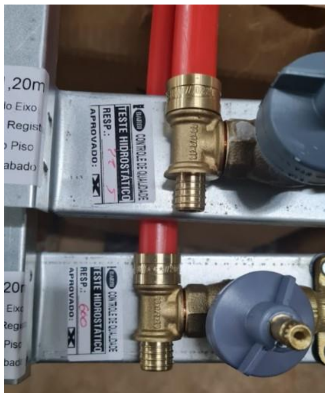
Figura 100: Conectores para extensão do sub-ramal de água quente.
