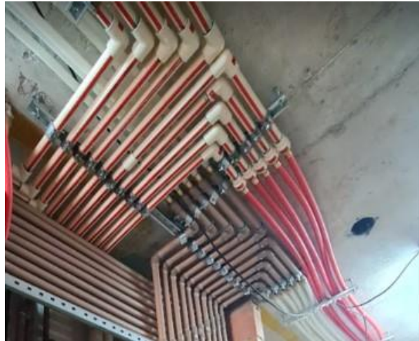
Figura 43: Adaptador entre sistema rígido e tubo PEX.
