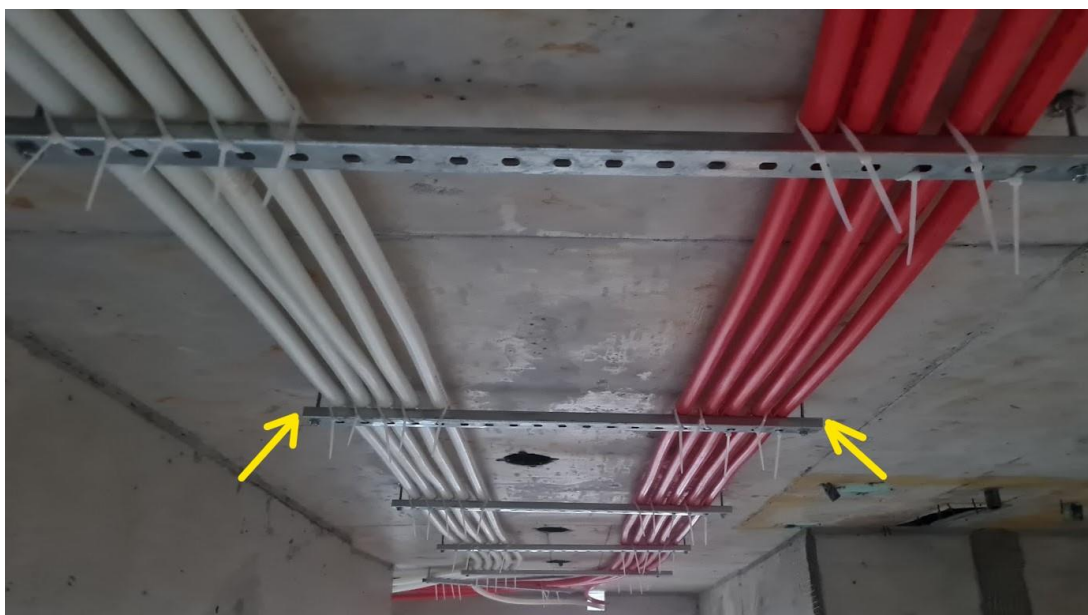
Figura 103: Fixação tubos PEX no teto da circulação.
