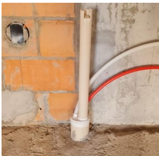
Figura 106: Situação real da coifa de acabamento sob bancada.
