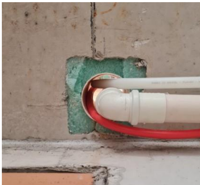
Figura 104: Tubo camisa visto por baixo da laje.
