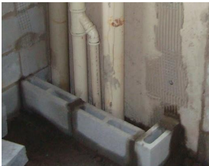
Figura 110: Bloco de concreto para 1ª fiada do shaft .
