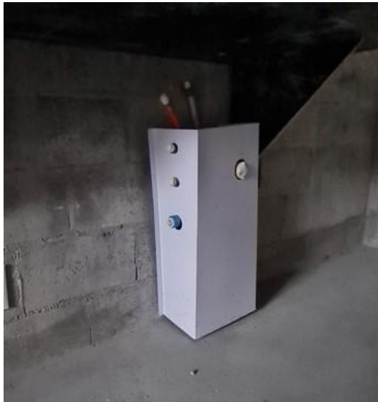
Figura 46: Carenagem simples de sobrepor.
