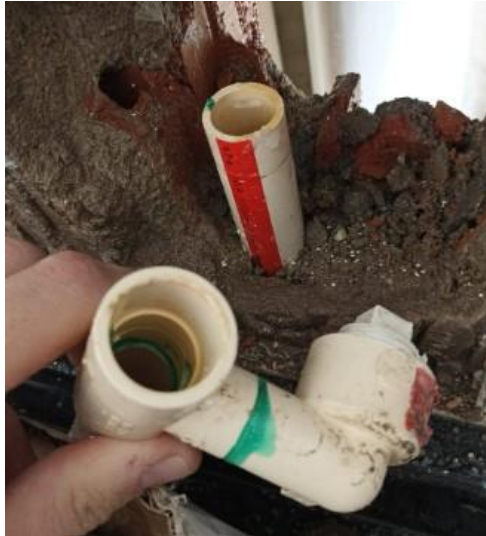
Figura 3: Conexão CPVC sem cola.
