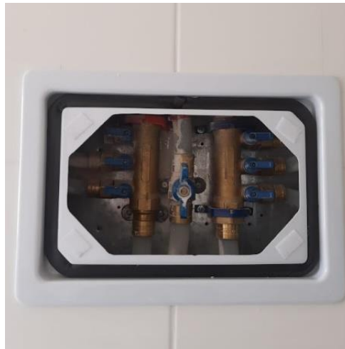
Figura 50: Caixa de inspeção para registro manifold.
