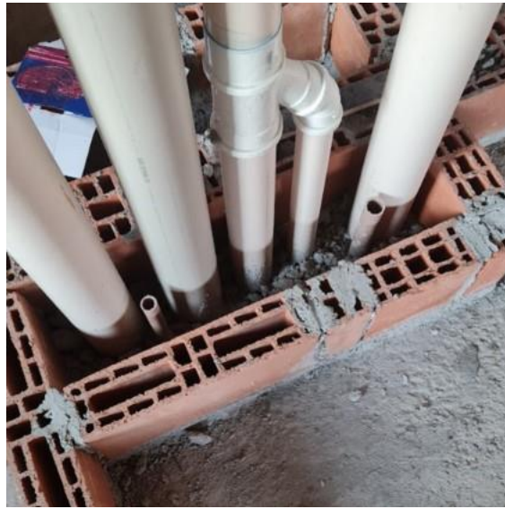
Figura 86: Marcação de 1ª fiada executada.
