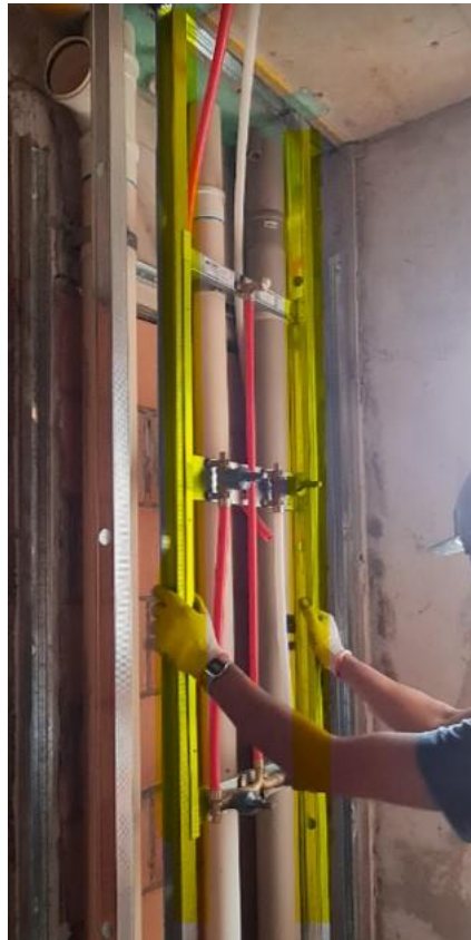
Figura 98: Perfil para ajuste e fixação do kit chuveiro.
