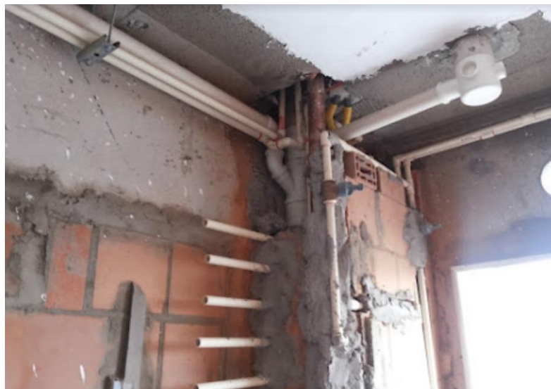
Figura 2: Ramal e sub-ramal de instalação em shaft .
