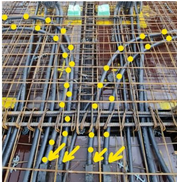
Figura 78: Laje em montagem com forma, armação e instalações.
