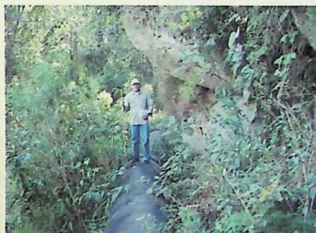
Foto 4: Bloco de rocha de corpo de tálus sobre o conduto.
