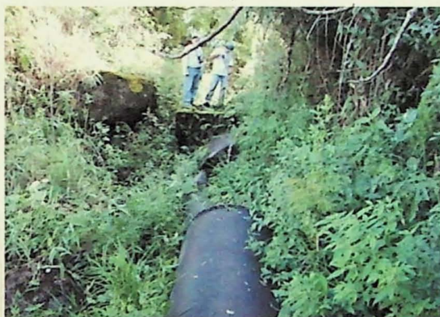
Foto 3: Conduto rompido por movimentos de massa da encosta.
