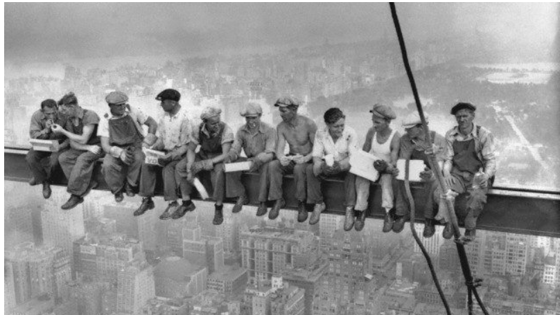
Figura 3: Icônico registro do horário de almoço no canteiro de obras do prédio da RCA no Rockefeller Center, de 1932, onde podemos ver alguns homens fumando e outros com suas marmitas
