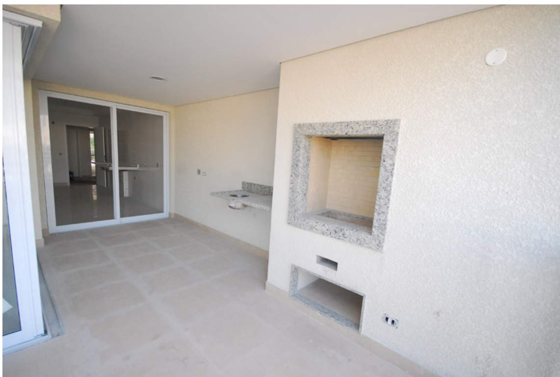
Figura 41–Terraço – Material Padrão – Empreendimento Padrão B
