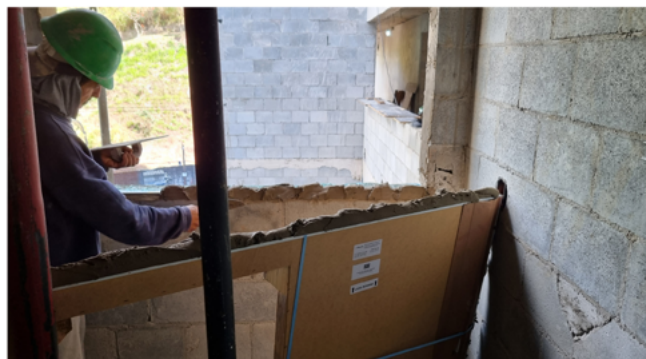
Figura 26: Montagem de fotos - Acabamentos Fonte: Acervo da autora, 2024 e 2025.
