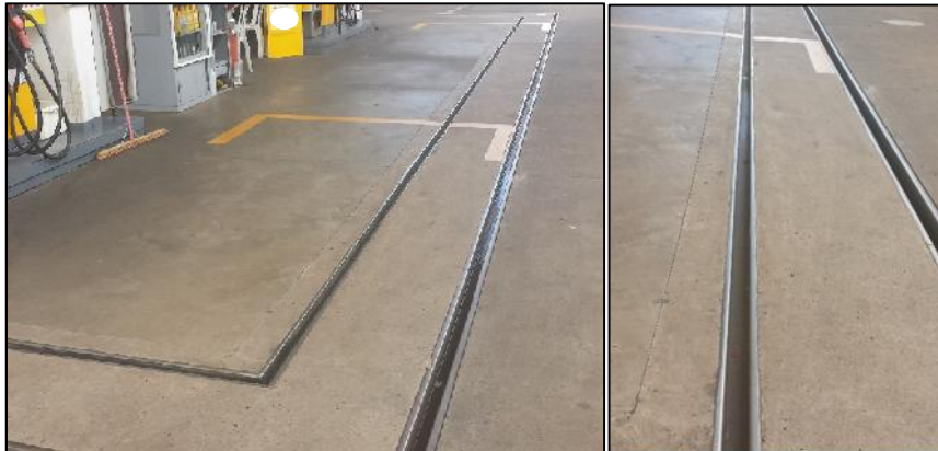
Figura 21 – Detalhe das canaletas de drenagem
