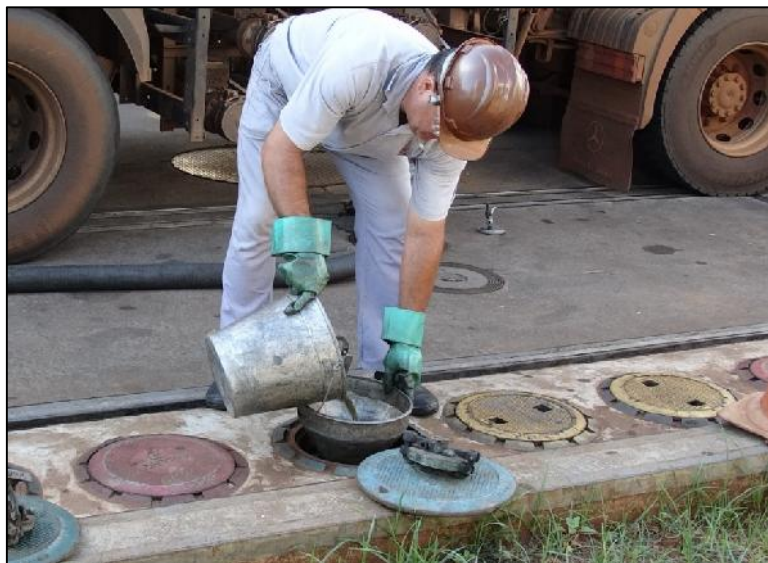
Figura 27 – Motorista transferindo o combustível do balde de alumínio para o respectivo tanque
