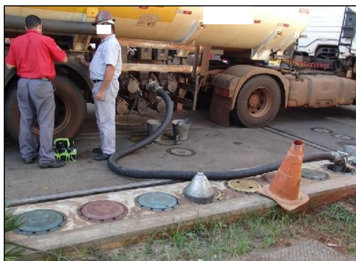
Figura 6 – Combustível sendo descarregado no tanque subterrâneo
