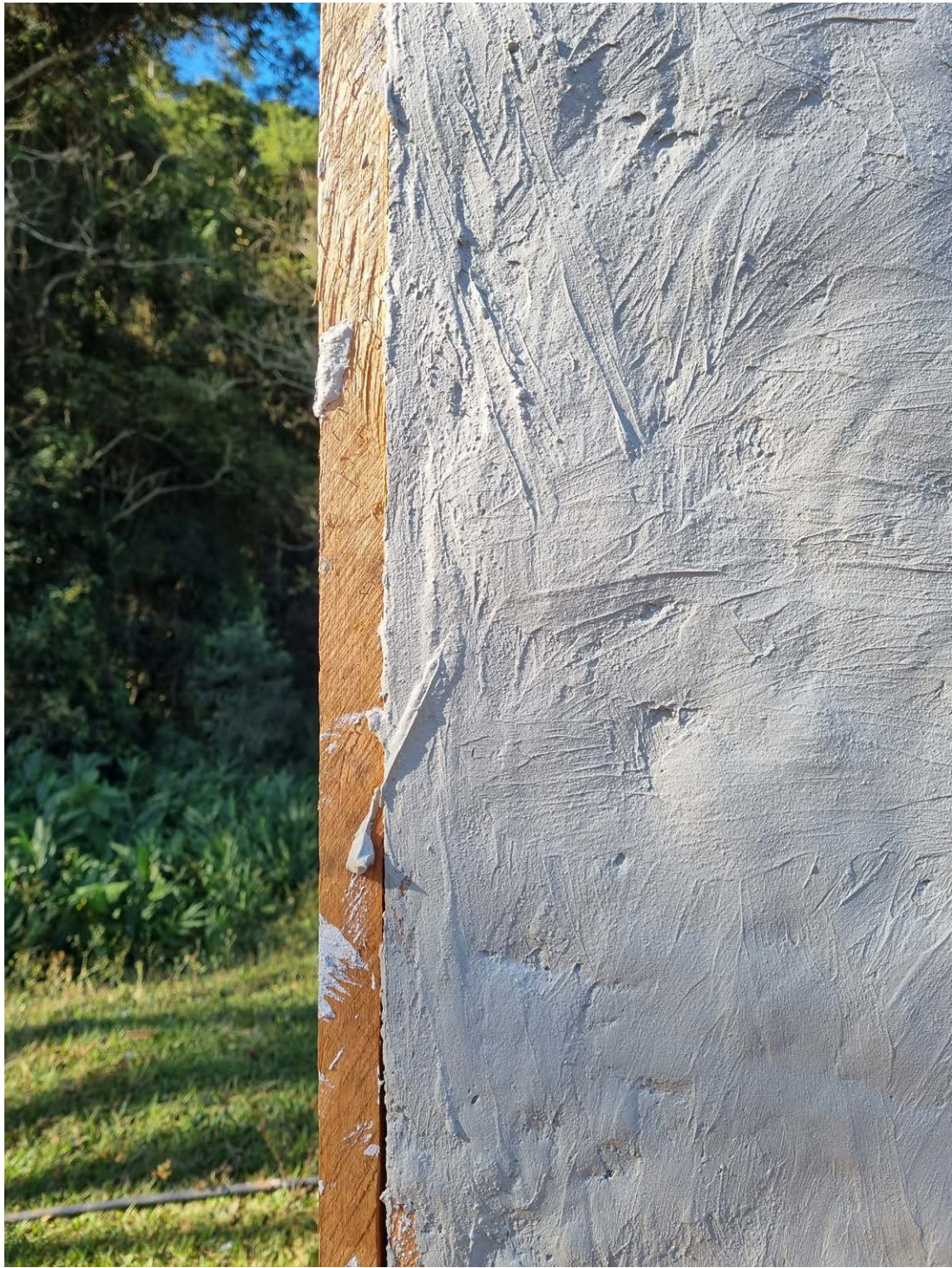
Fig. 58. Detalhe do acabamento em barro tabatinga do painel. Fonte: acervo do autor.
