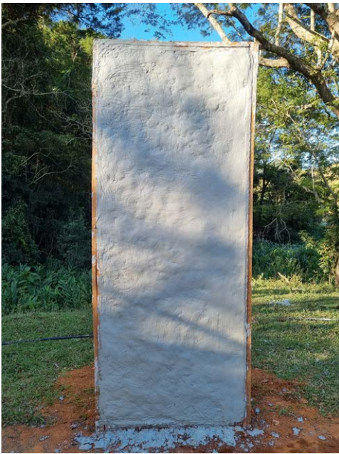
Fig. 49. Protótipo do painel finalizado com acabamento de barro tabatinga. Fonte: acervo do autor.
