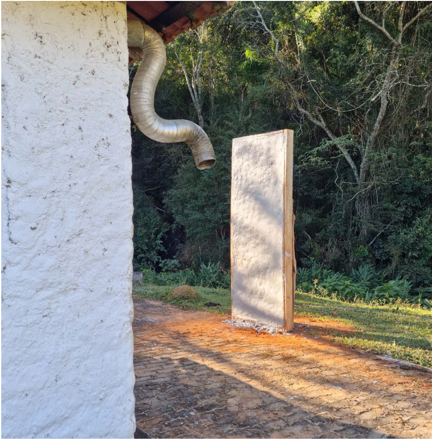
Fig. 59. Protótipo do painel modulado de taipa adaptado a Serra da Bocaina acabado. Fonte: acervo do autor.
