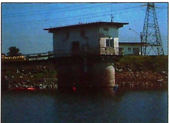
Foto 5. Vista da porção norte da represa – captação de água pela SABESP
