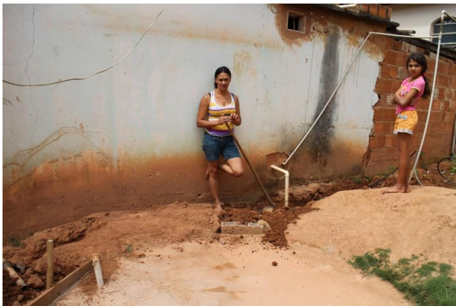
Figura 4.2.3 - Moradoras de São Luís do Meriti ao lado dos buracos cobertos que foram escavados para a instalação das fossas e que não foram concluídos.
