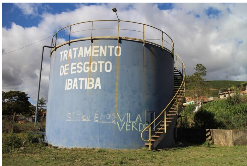
Figura 4.2.2 - Sistema de reator UASB+biofiltro da antiga estação de tratamento.
