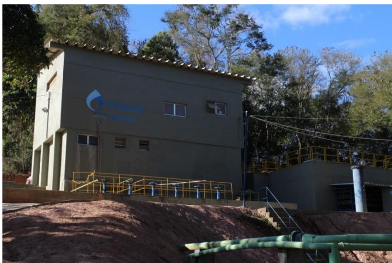
Figura 4.1.4 – Instalações ETA de Ibatiba.
