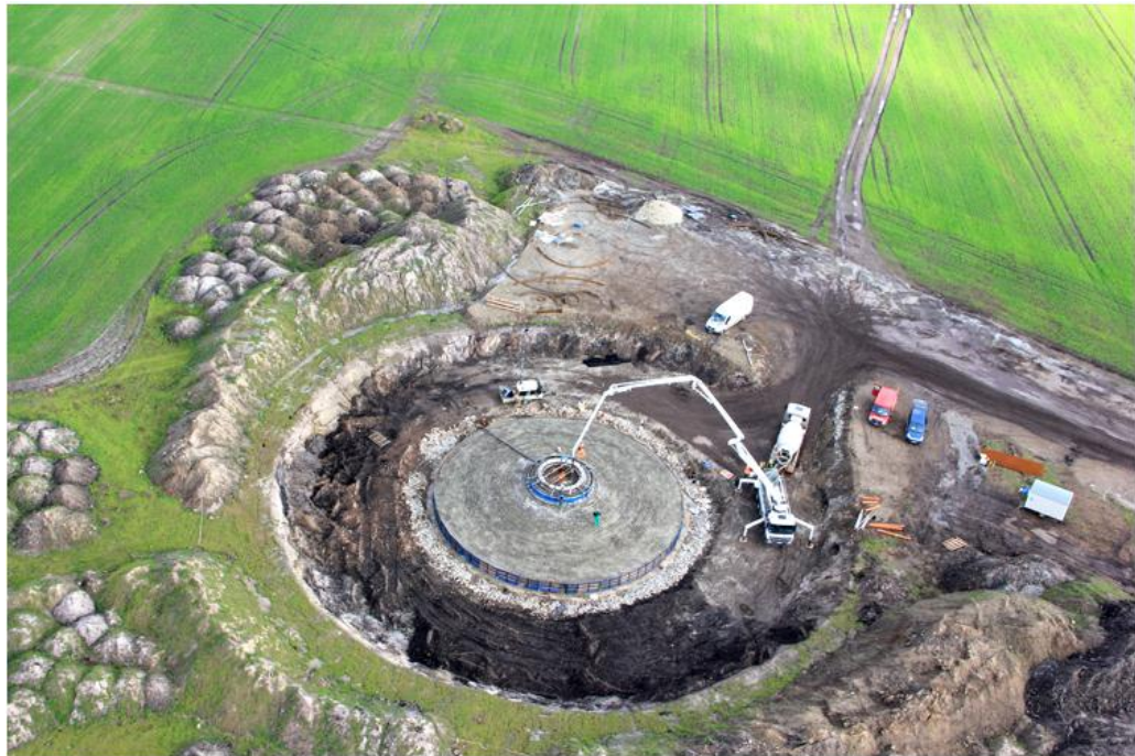
Figura 8 - Parque eólico Klettwitz na Alemanha: Fundação para as novas torres.
