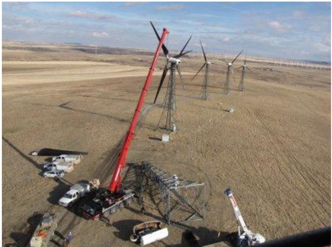
Figura 4 - Descomissionamento do parque eólico Cowley Ridge no Canadá: Remoção das torres.
