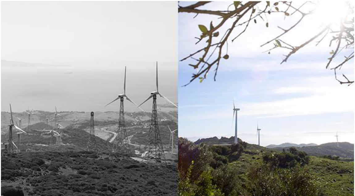
Figura 7 - Parque eólico El Cabrito na Espanha: Antes e depois da repotenciação. Fonte: https://www.acciona-energia.com/es/areas-de-actividad/eolica/instalaciones-destacadas/parque-eolico-el-cabrito/ .
