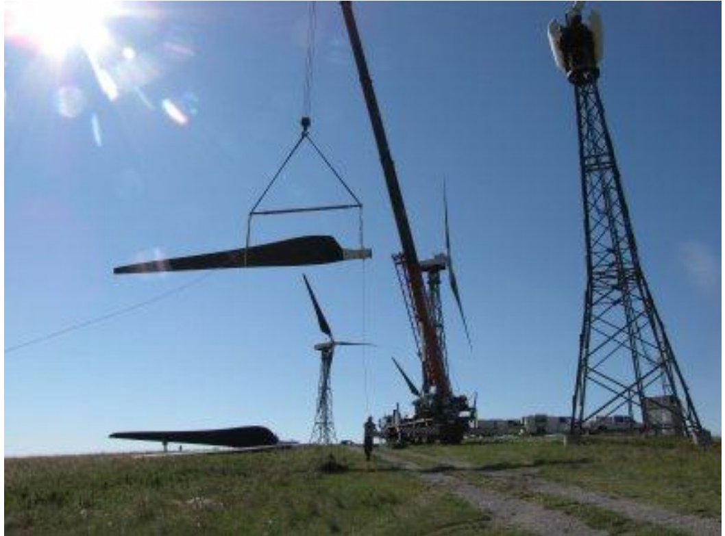
Figura 2 - Descomissionamento do parque eólico Cowley Ridge no Canadá: Remoção das pás.
