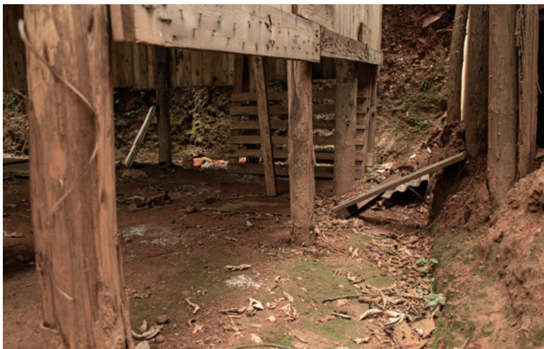
IMAGEM 28 ( Bruno Machado 02/2021) Pontaletes escavados e enterrados diretamente no solo, sem impermeabilização ou tratamento. Executa-se buraco com a cavadeira de aprox. 1,5m de profundidade na terra, inserção do pilar e reaterro. Pilares estão sujeitos à movimentação do reaterro, ao apodrecimento pela umidade do solo e ação de pragas.
