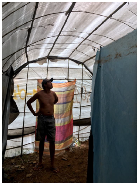
IMAGEM 17- mostra um barraco feito com lona plástica preta e bambu, na primeira semana de ocupação, em 2019. Com os bambus em forma de arco foi possível chegar em um pé direito de quase 3 metros. Os bambus que fazem esse arco foram enterrados no solo. O caimento da cobertura é de alta inclinação, por isso a água em pouco acumulava na lona. No entanto, a lona é fina e apresenta frestas para a infiltração da chuva. As ripas de bambu estavam travadas entre si, numa espécie de costura com as terças, sem precisar serem amarradas por um outro elemento construtivo. Ao lado direito da imagem nota-se uma divisória feita de forma independente da cobertura, é um espécie de painel de bambu coberto com lona. Não há janelas. A porta e entrada única do barraco é um pano preso a a trama de bambu e lona que vedam o ambiente. (foto da autora 09/2019)
