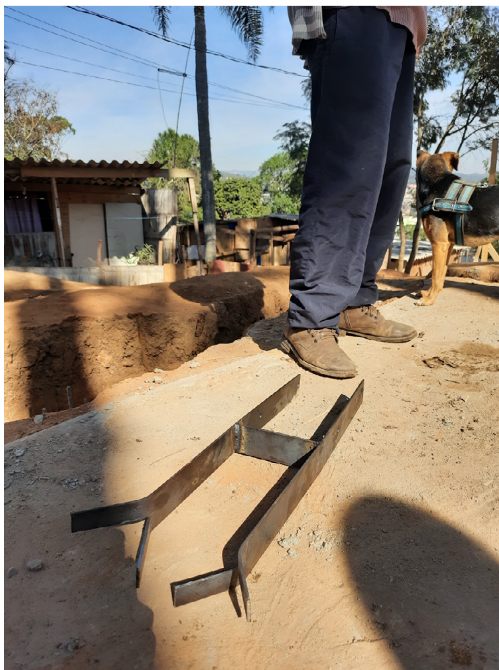
IMAGEM 49 - Espera metálica finalizada. ( autoria Ariel Ferrari )
