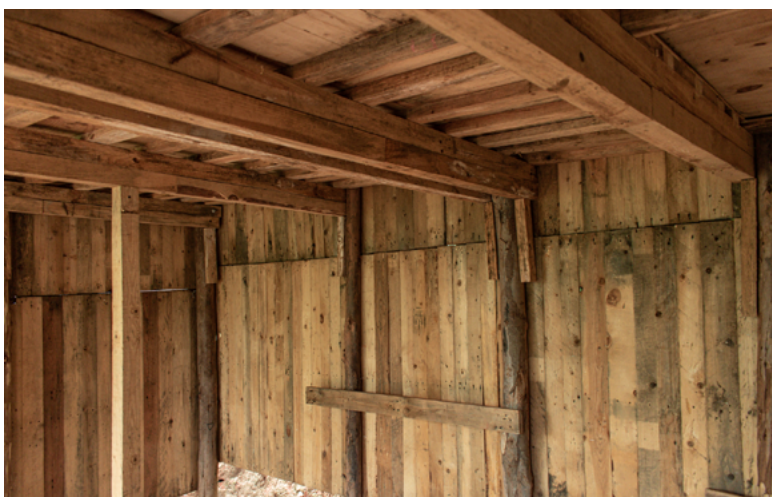
IMAGEM 29 (Bruno Machado 02/2021) Caibros pregadas um em cima do outro compõe as vigas de sustentação do assoalho. O encontro entre essas vigas e os pilares se dá por transmissão indireta, sendo os pregos os elementos intermediários do caminho de forças. É possível que haja deformação desses pregos por flexão, já estão resistindo a muito peso. O ato de pregar pode provocar fendas e enfraquecer a seção do retalho de sarrafo que está sustentando o peso da viga.
