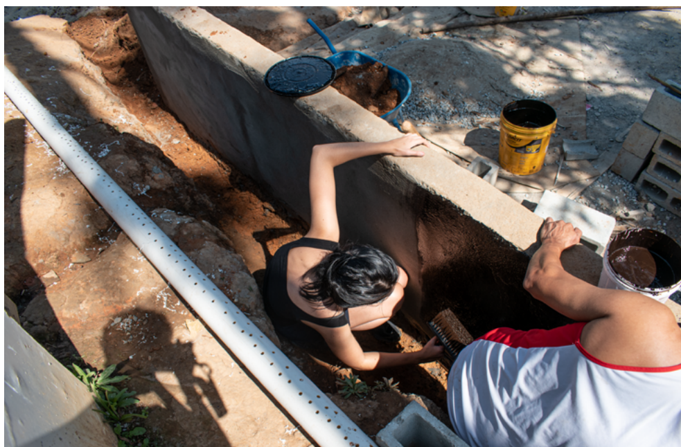
IMAGEM 53- Processo de impermeabilização dos muros de arrimo. Instalação do sistema drenante. ( autoria Ariel Ferrari)
