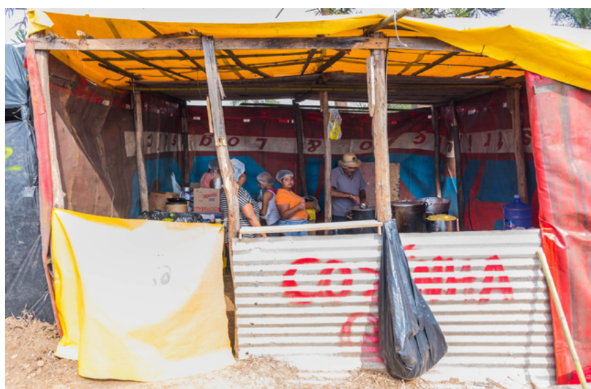
IMAGEM 18 e 19 - mostram respectivamente o barracão coletivo a a cozinha coletiva. Adota-se o sistema viga, pilar e fundação em madeira. O vão é muito pequeno entre os pilares de madeira e de forma geral interfere nas atividades coletivas. Vedação e cobertura em lona de caminhão. Esses são os primeiros espaços com aberturas e ventilação entre interno e externo.
