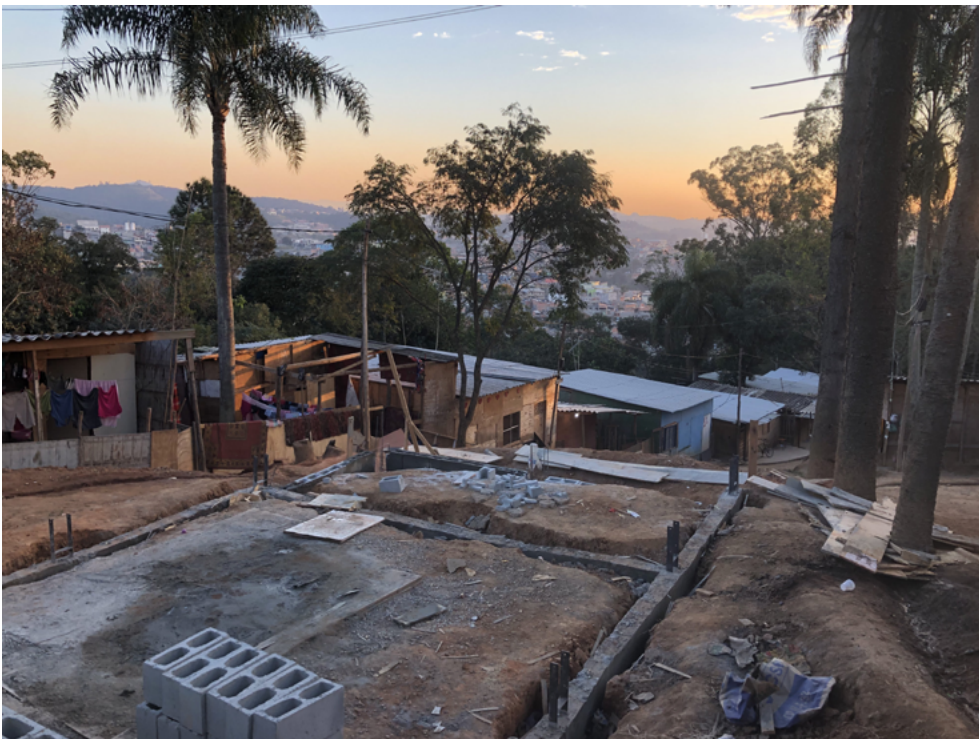
IMAGEM 50 e 51- Espera metálicas chumbadas no baldrame. ( autoria Daniella Motta)
