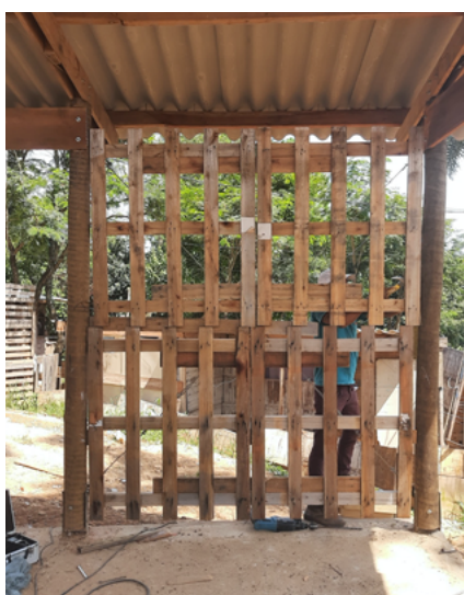
IMAGEM 65 - fotos montagem do esqueleto de vedação em paletê ( autoria Ariel Ferrari)
