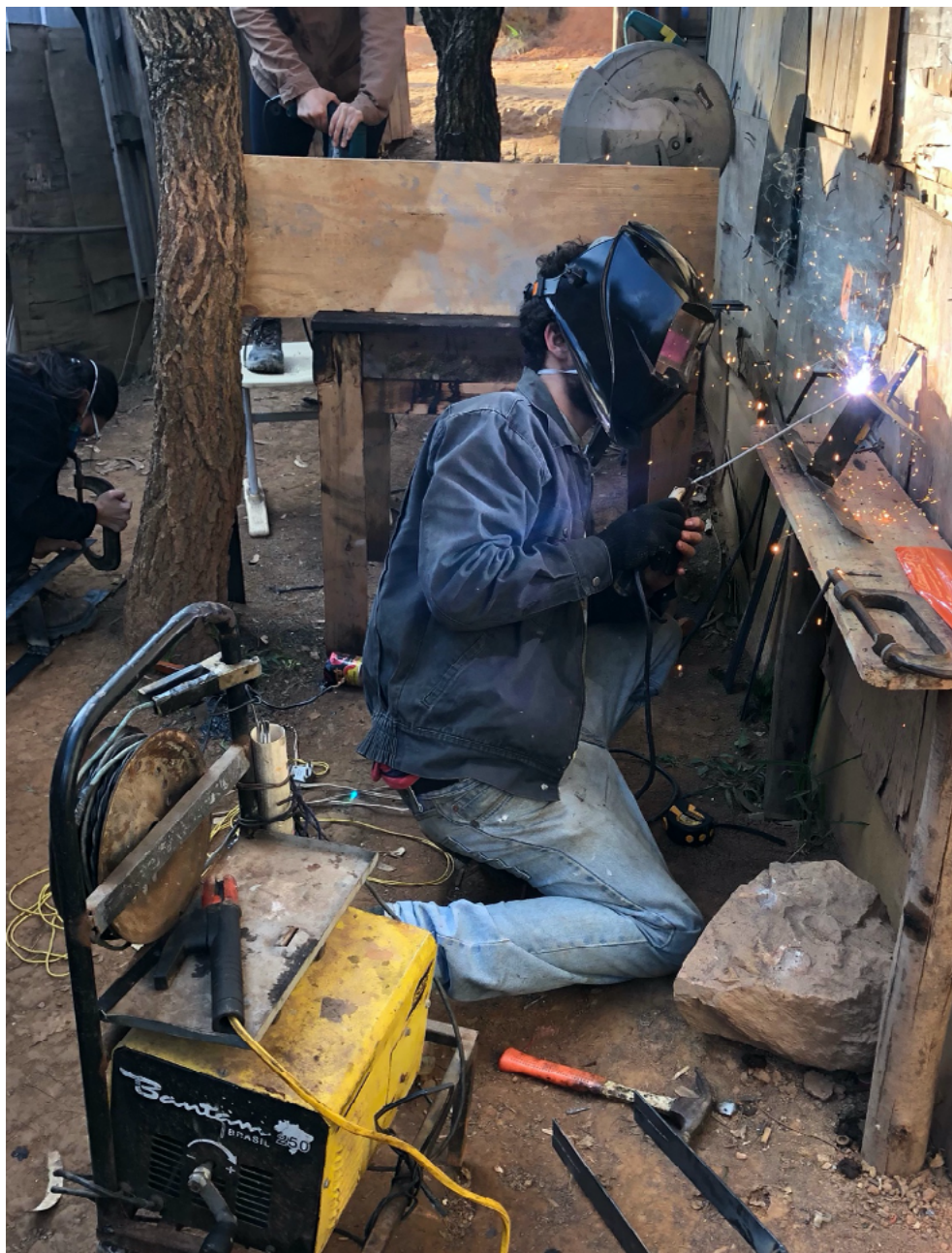
IMAGEM 48 - Fotos do Processo de solda e realização das peças metálicas. Imagem 4.8 ( autoria Daniella Motta)
