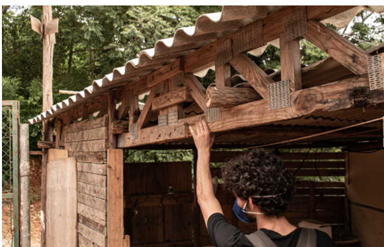
IMAGEM 30 (Bruno Machado 02/2021) Associação de peças de sarrafos formam uma treliça plana. Essa associação mostra-se eficiente pois, os sarrafos tendem a receber somente esforços de tração ou compressão. O uso de chapa prego é um conector interessante para esse tipo de estrutura.
