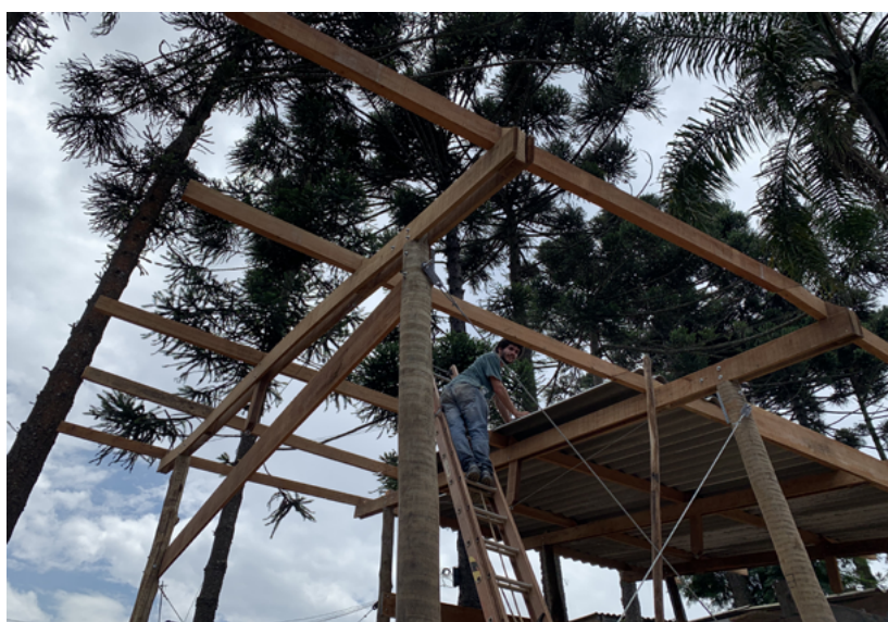
IMAGEM 62, 63, 64 - colocação das vigas e terças ( autoria Daniella Motta).
