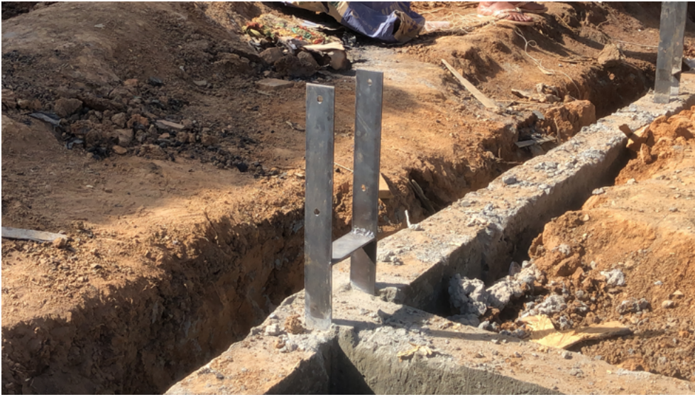
IMAGEM 50 e 51- Espera metálicas chumbadas no baldrame. ( autoria Daniella Motta)
