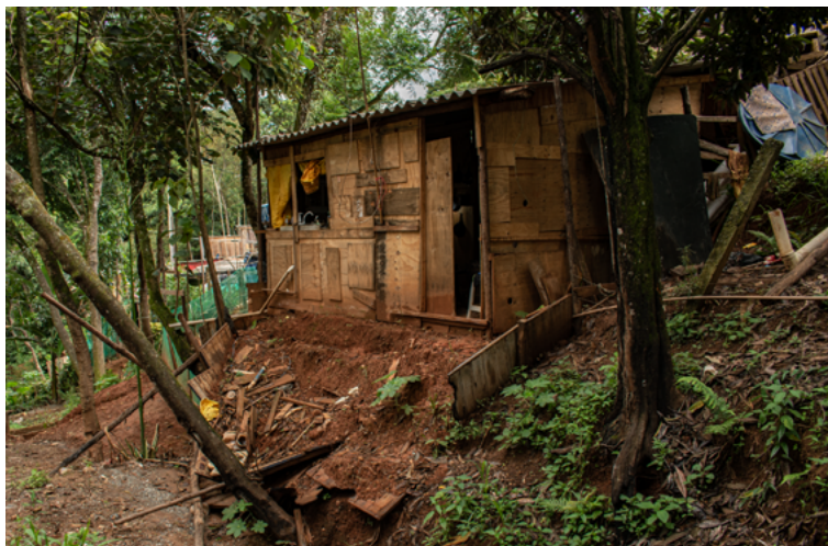
IMAGEM 22 (Bruno Machado 02/2021) Barraco (22) construído em pilares de pontalete. Vigas compostas de retalhos de sarrafos pregados seguram a cobertura. Vedação de chapas de compensado sobrepostas entre si e conectadas por pregos. Muro de arrimo feito de compensado (contenção ineficiente e risco de deslizamento). O beiral do telhado é curto e a madeira está em contato direto com o chão. Exposição à umidade do solo e das chuvas.
