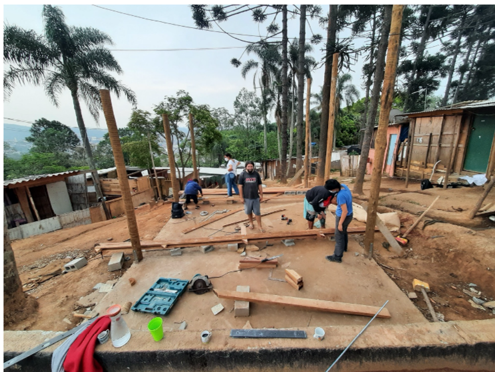
IMAGEM 59 e 60 - fotos montagem viga vagão ( autoria Daniella Motta)
