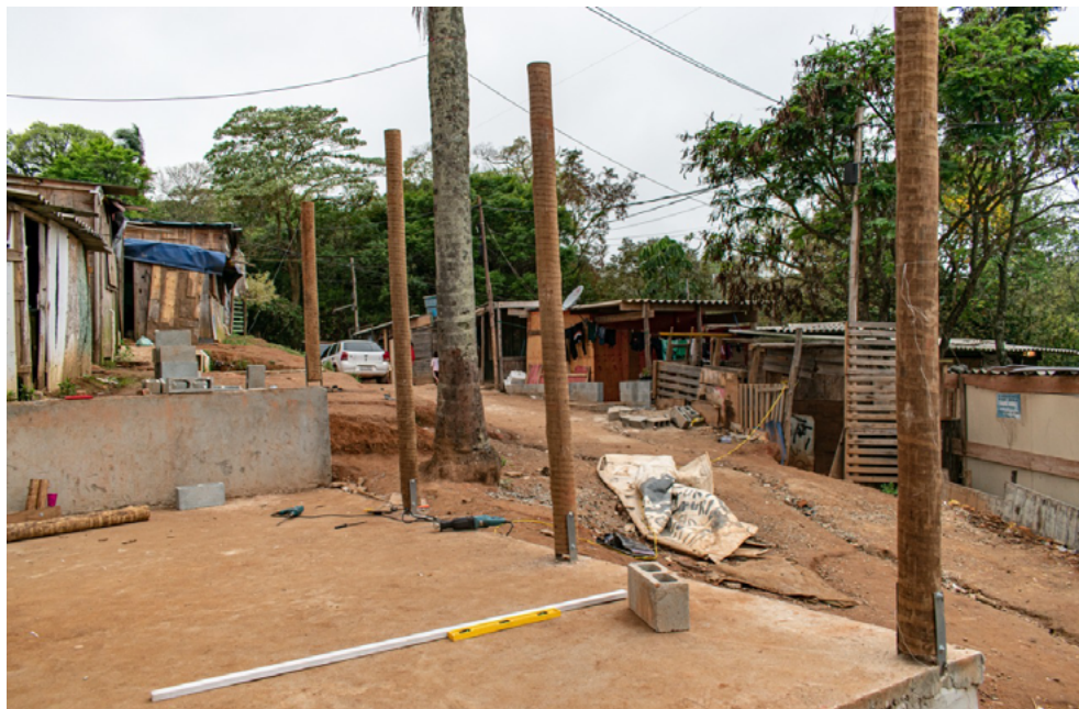
Imagem 55- colocação de pilar em espera metálica ( autoria Daniella Motta)
