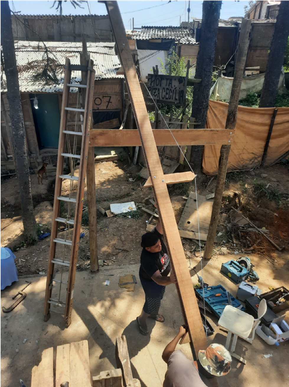
IMAGEM 61 - fotos montagem viga vagão ( autoria Ariel Ferrari)
