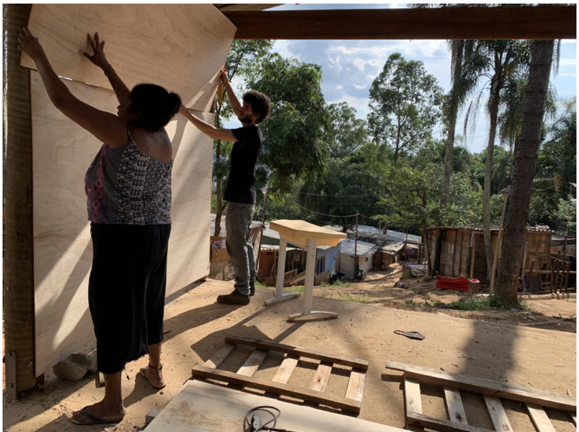
IMAGENS 66 e 67 - colocação das chapas de compensado sob o esqueleto de palete ( autoria Daniella Motta)
