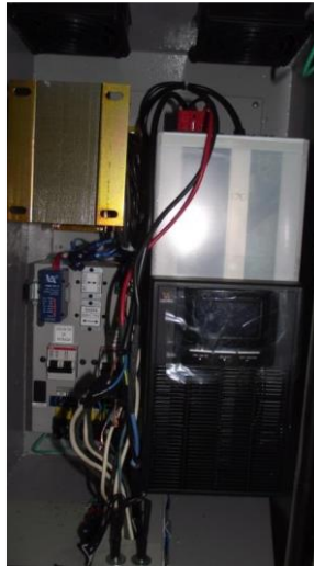
Figura 4 - UPS semafórica internamente.
