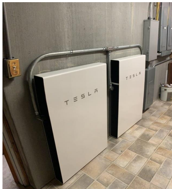
Figura 17 - Bateria PW2 instalada.
