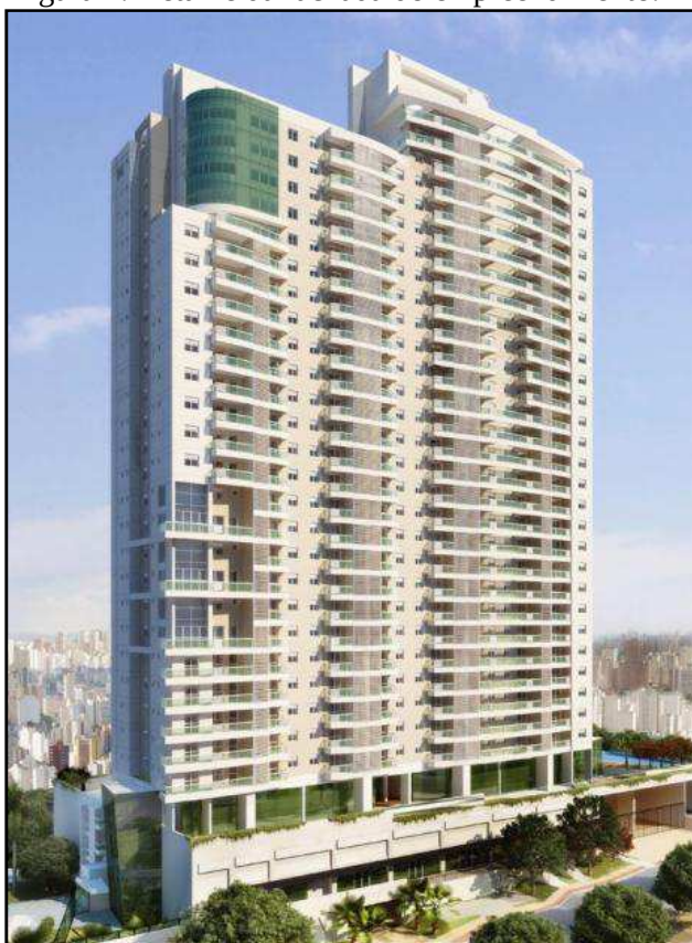
Figura 7: Detalhe da fachada do empreendimento.
