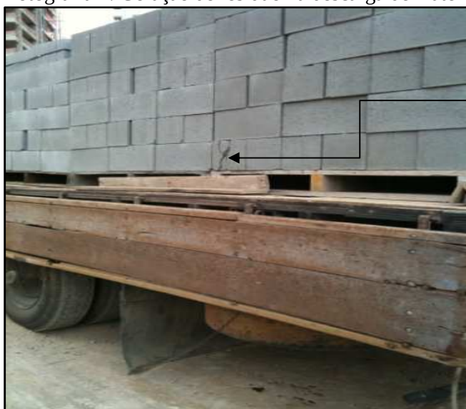
Fotografia 4: Geração de resíduo na descarga de material.
