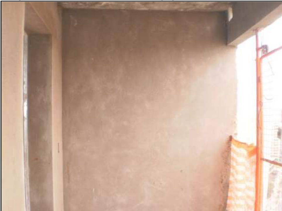
Fotografia 14: Revestimento executado com agregado reciclado.
