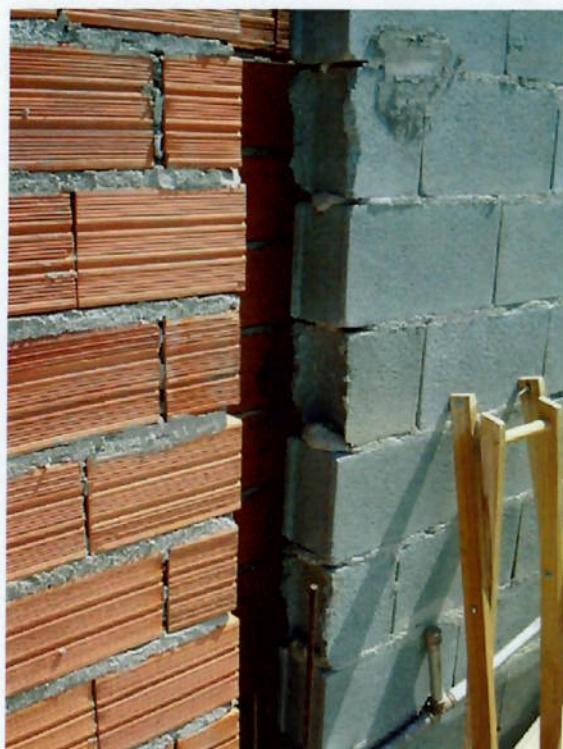
Figura 56 – Vão entre paredes (acúmulo de água)
