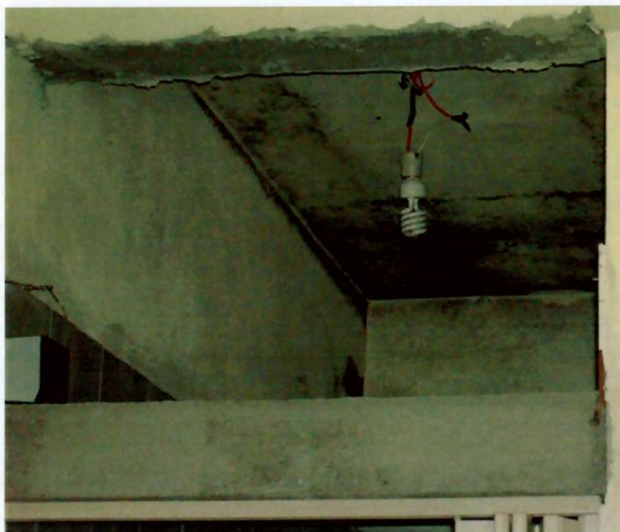
Figura 43 – Umidade no banheiro
