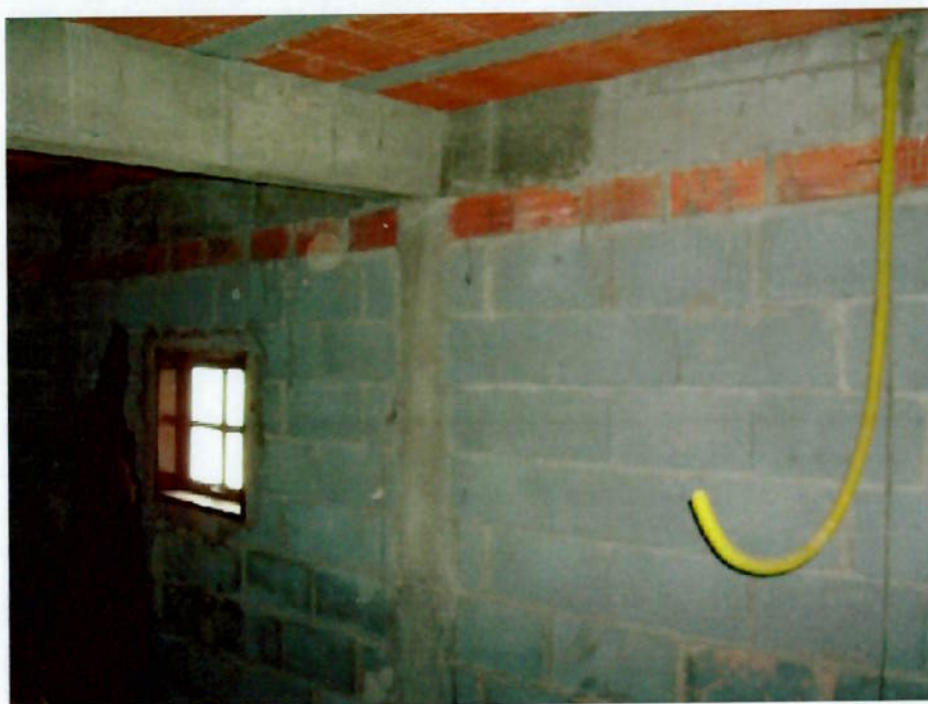
Figura 33 – Janela de tamanho insuficiente para o cômodo
