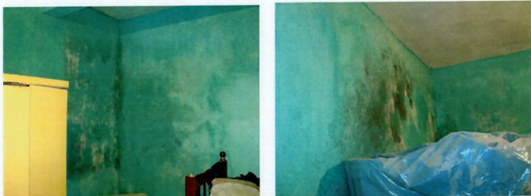
Figura 50 – Problemas de umidade principalmente no quarto do fundo.
