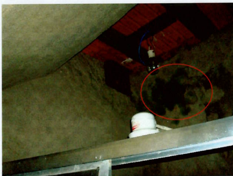
Figura 38 – Bolor na parede do banheiro
