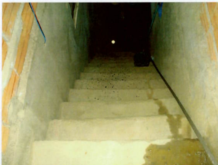
Figura 80 – Água descendo para porão
