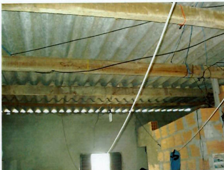
Figura 82 – Más condições da instalação elétrica
