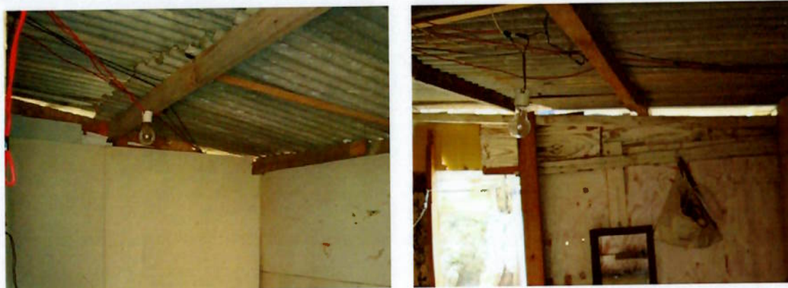
Figura 72 – Instalações elétricas precárias e perigosas.
