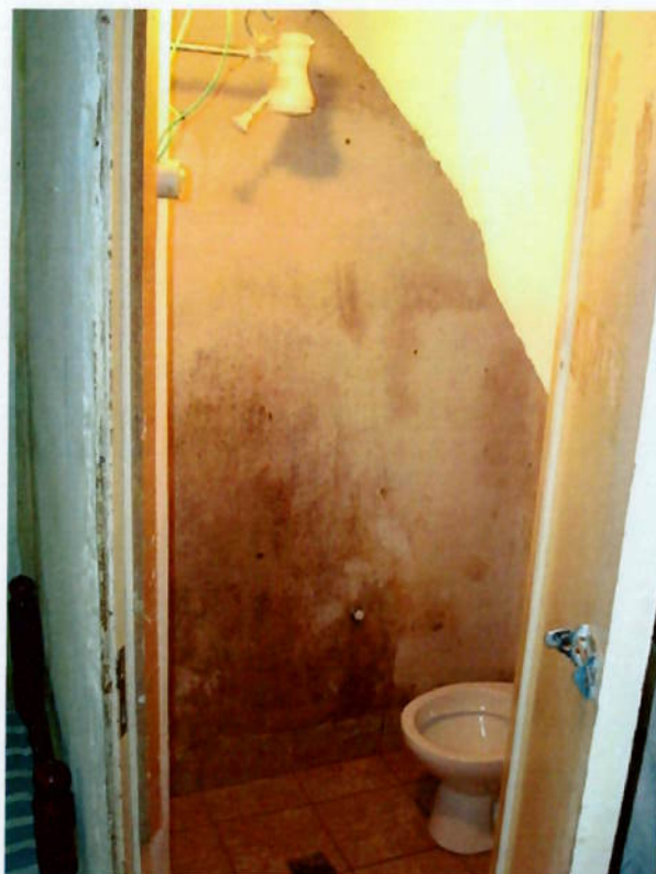
Figura 47 - Umidade no banheiro
