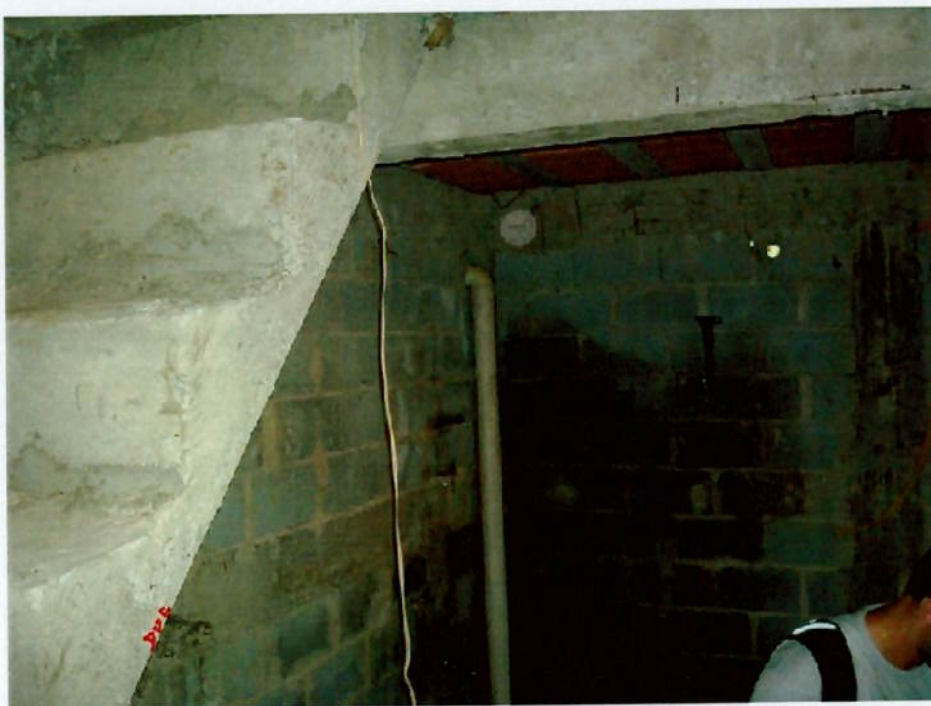
Figura 32 – Umidade na parede
