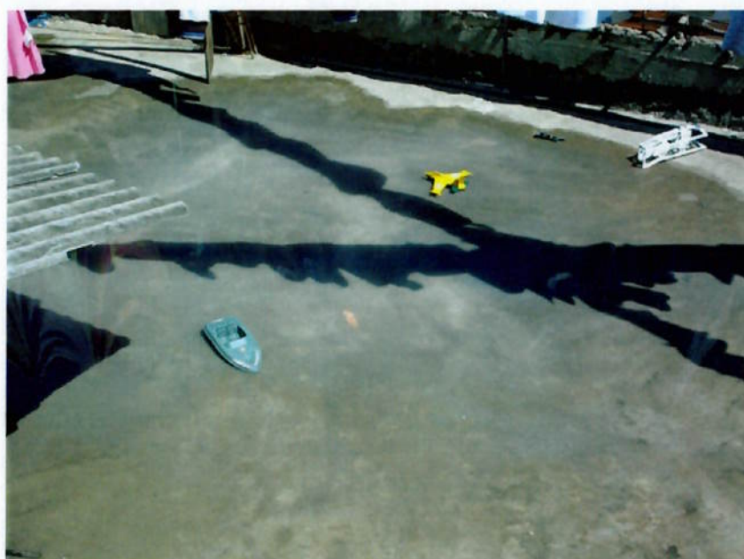
Figura 66 – Empoçamento de água na laje
