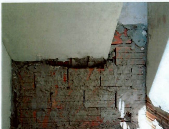
Figura 63 – Chegada da laje na parede.
