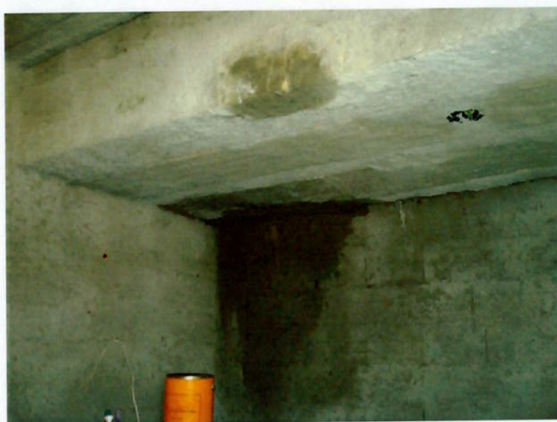
Figura 74 – Umidade no porão.
