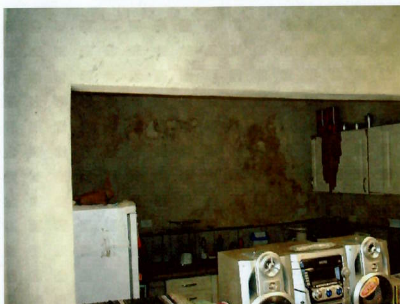
Figura 39 – Umidade na parede da cozinha
