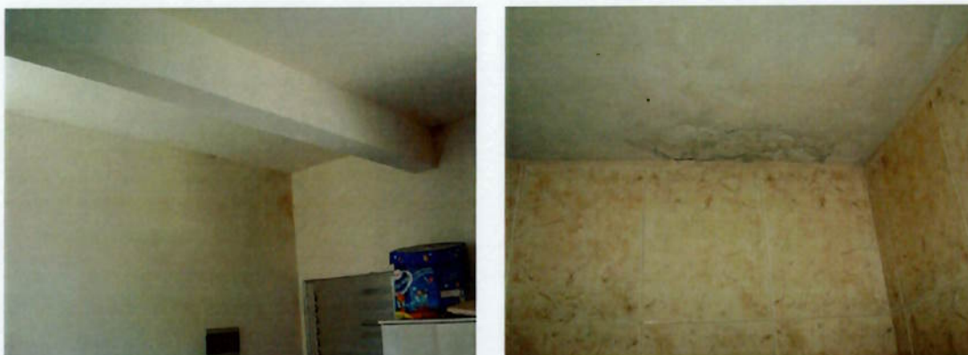
Figura 61 – Problema de umidade maior nas lajes, trincas e áreas molhadas bem-executadas.
