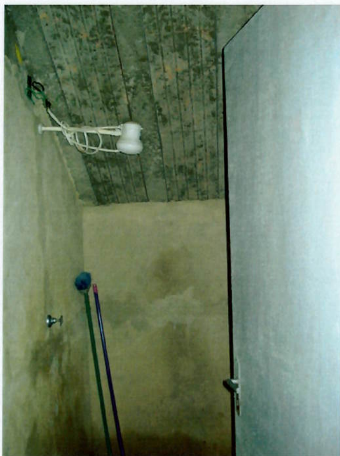
Figura 65 – Umidade no banheiro
