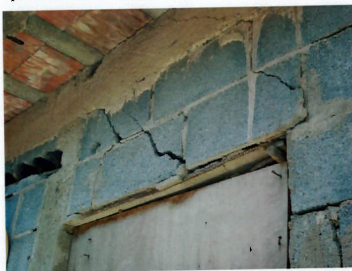
Figura 76 – Trincas por falta de verga
