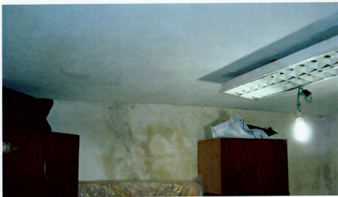
Figura 46 - Manchas de umidade na parede do fundo
