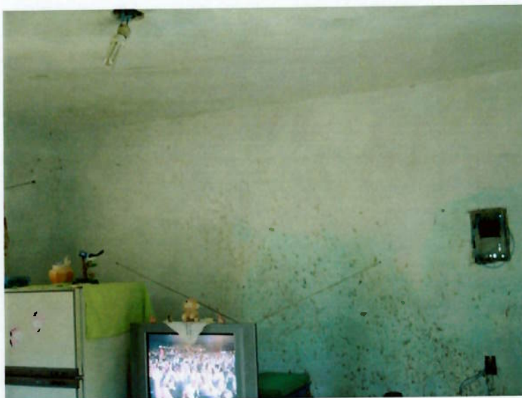
Figura 73 – Umidade nas paredes.
