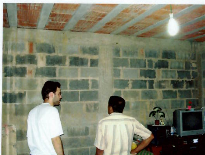
Figura 53 – Excesso de umidade
