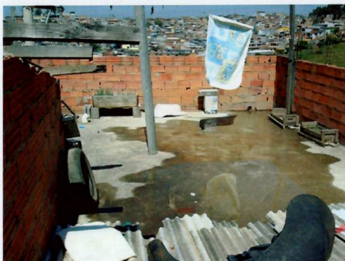
Figura 62 – Acúmulo de água nas lajes.
