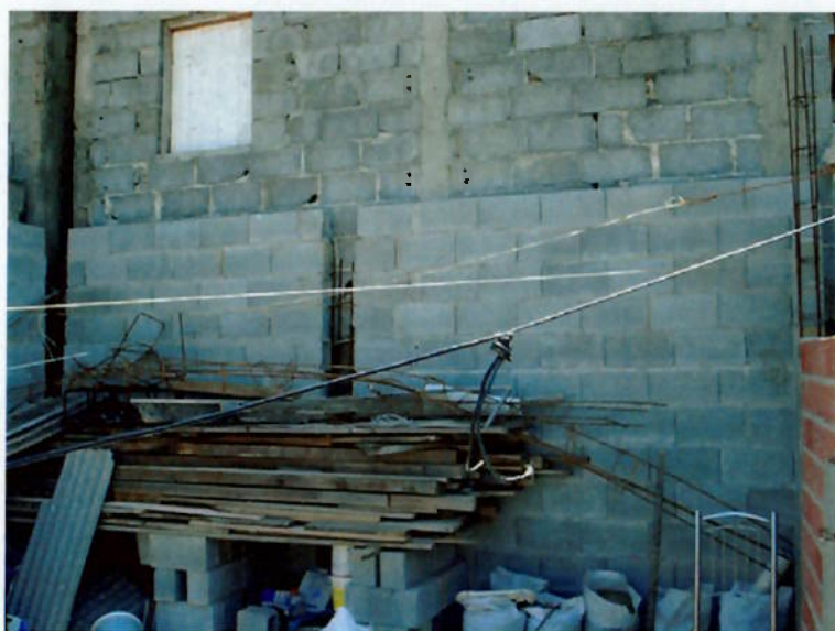
Figura 57 - Vão entre paredes (acúmulo de água)
