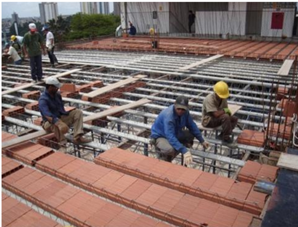
Figura 4-23 – Montagem das vigotas e encaixe das lajotas
