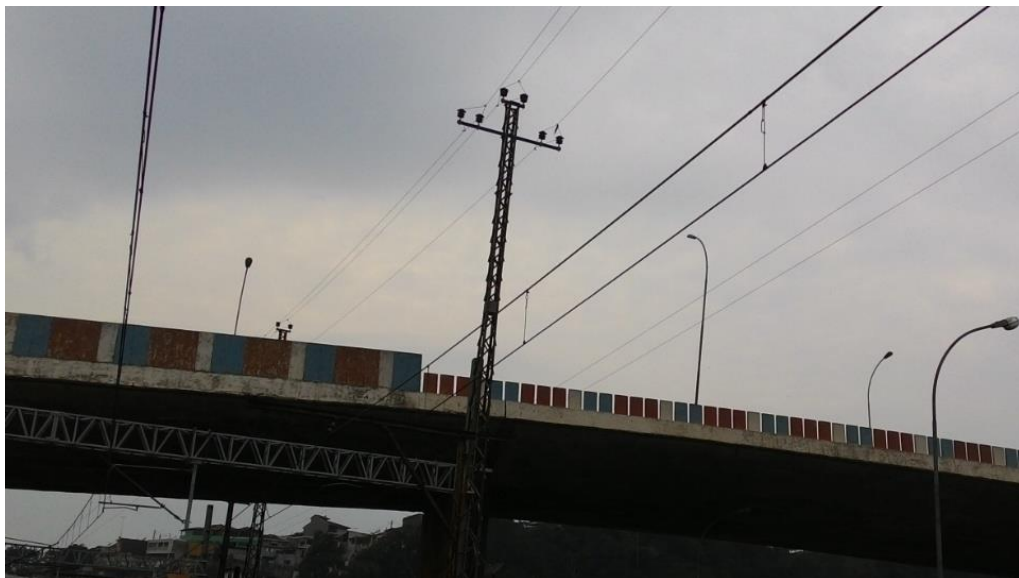
Figura 2.2 - Torre para desvio das linhas de 34,5\text{ kV}_{ca} sobre um viaduto
