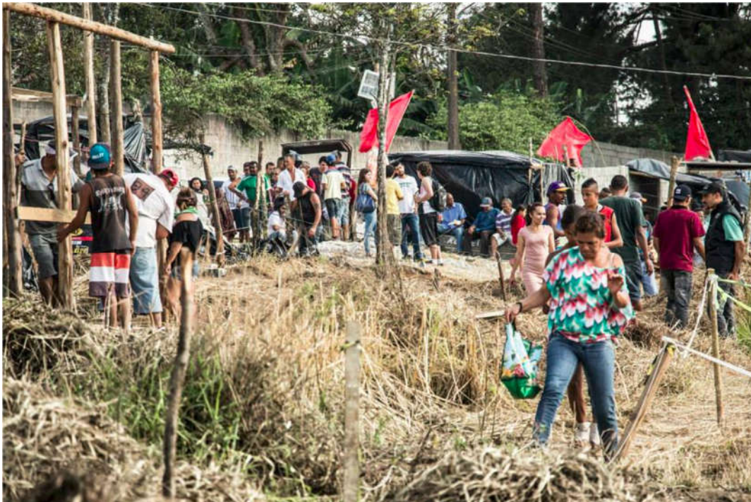
Figura 6: Construção dos barracos na ocupação Plínio de Arruda Sampaio
