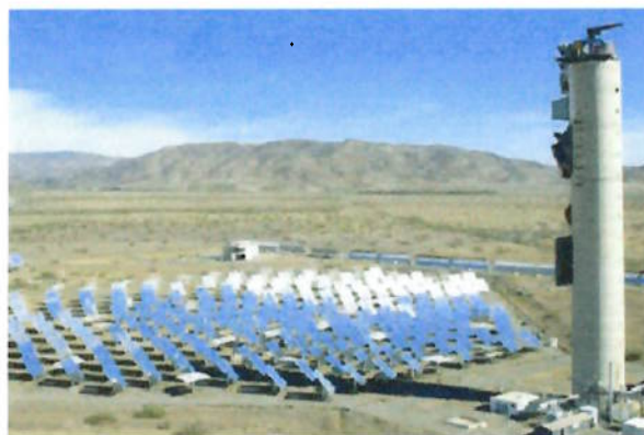
Figura 2 – Instalação de receptor solar de torre
