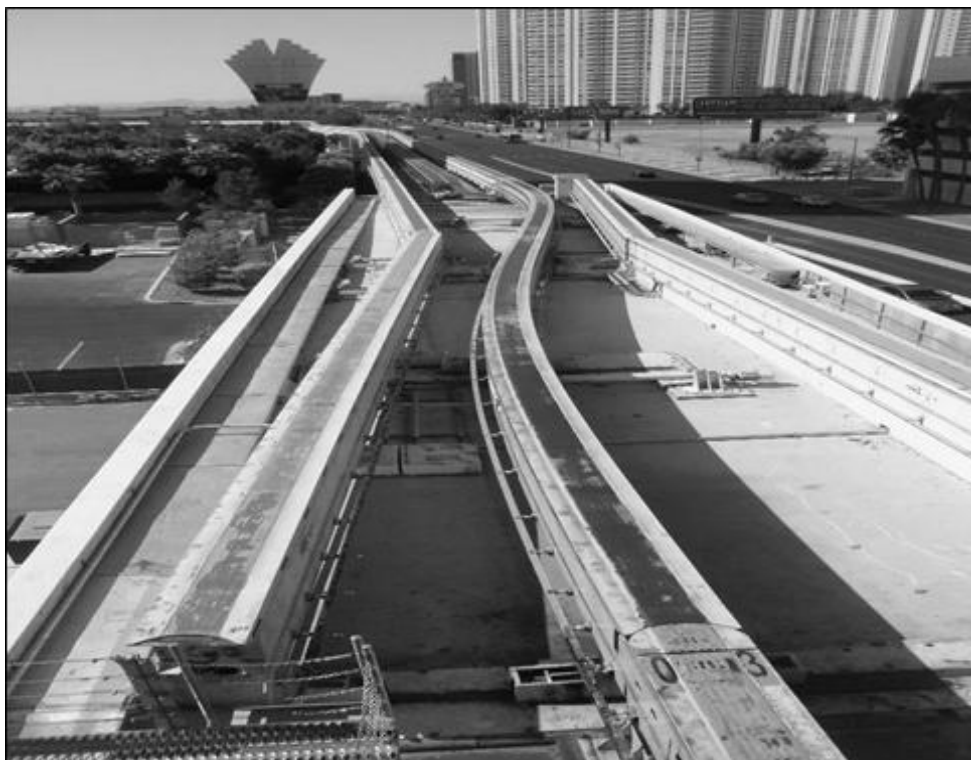
Figura 1.2 – Um aparelho de mudança de via – AMV – do monotrilho de Las Vegas (EUA).
