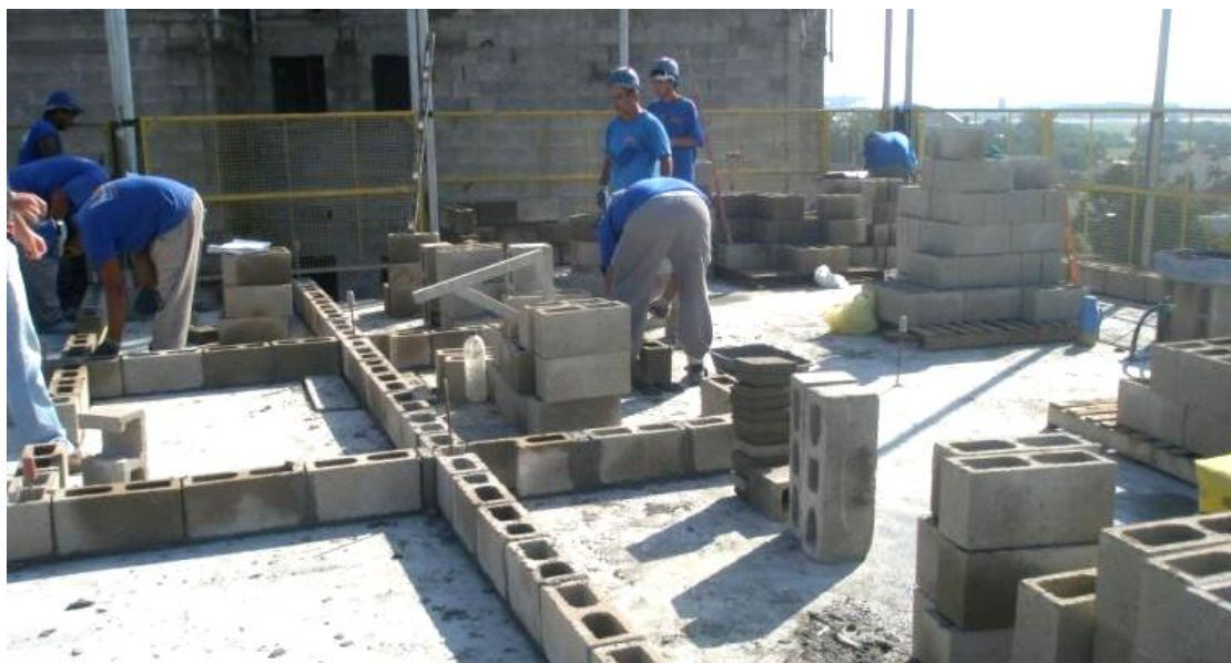
Figura 16 - Primeira Fiada de um Pavimento (fonte: https://www.ufrgs.br/eso/content/up/3.-Execu%C3%A7%C3%A3o-da-primeira-fiada.jpg )
