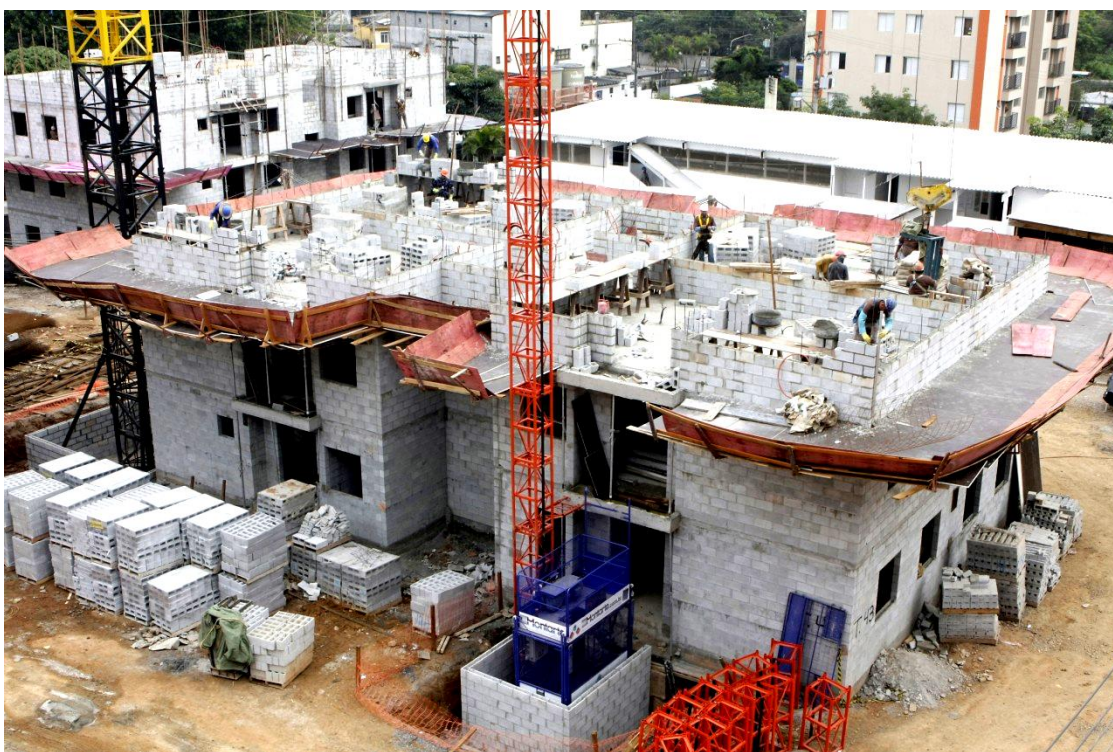
Figura 15 - Pallets em Obra de um Edifício em Alvenaria Estrutural (fonte: http://www.comunidadeconstrucao.com.br/upload/imagens/ABCP%2031_05_2011%20Fotos%20Chico%20Rivers0091.jpg )
