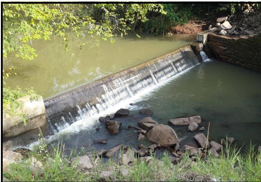
Figura 14 – Ponto de captação de água para tratamento
