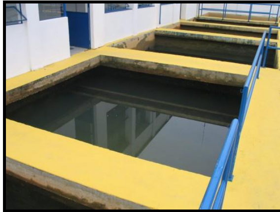
Figura 11 – Filtros de uma ETA do tipo rápido de fluxo descendente
