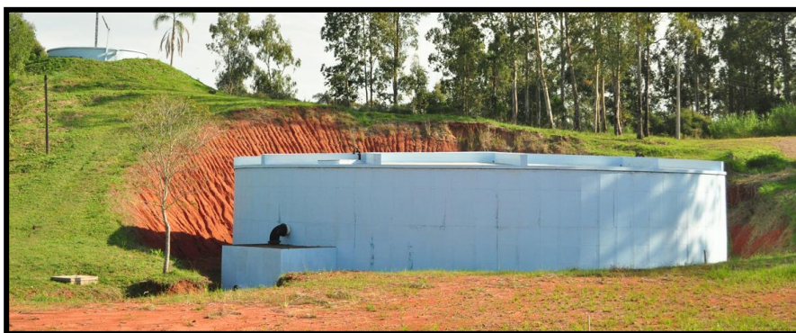
Figura 19 – Reservatórios de 2000m 3 e 150m 3 da ETA municipal
