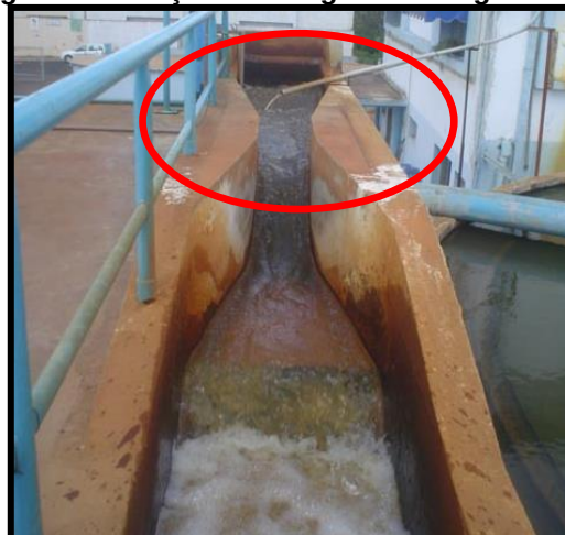
Figura 8 – Adição de coagulante à água bruta
