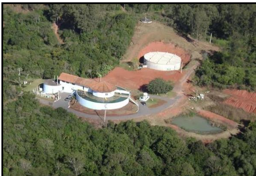
Figura 13 – Estação de Tratamento de Água
