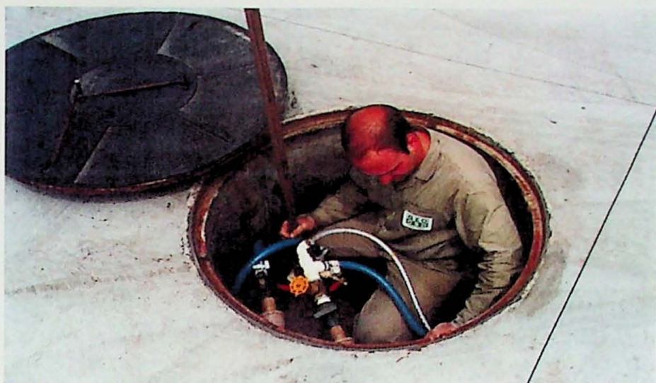
Caixa de Visita do Poço de Extração
